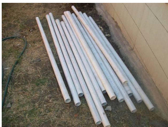
Figura 108. Tubos de P.V.C., cortados a 2 m. En cada tramo de tubo fueron realizados 10 orificios de pulgada y media de diámetro, dejando 20 cm entre orificio y orificio, (figuras 109 a 111).
