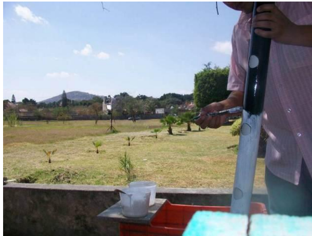
Figura 118. Aplicación de una capa de pintura color blanco.
