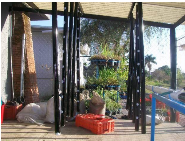
Figura 117. Aplicación de una capa de pintura color negro.
