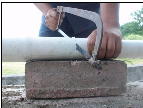
Figura 107. Segado de los tubos de P.V.C.
