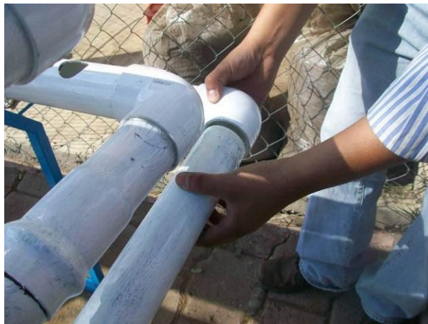
Figura 122. Unión de las piezas de P.V.C.
