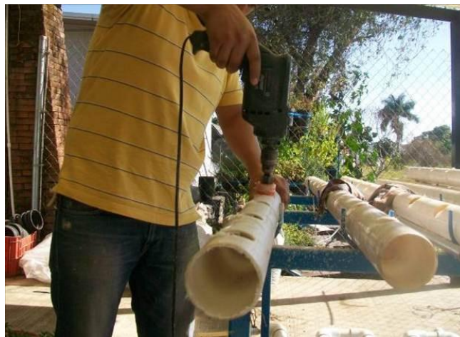
Figura 111. Realización de los orificios en los tubos.
