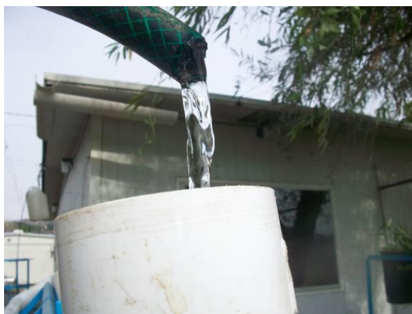
Figura 146. Flujo entrante al sistema de conducción.
