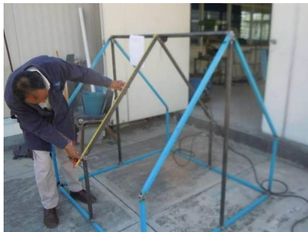
Figura 101. Construcción de la base metálica.
