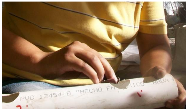
Figura 113. Eliminación de las rebabas.
