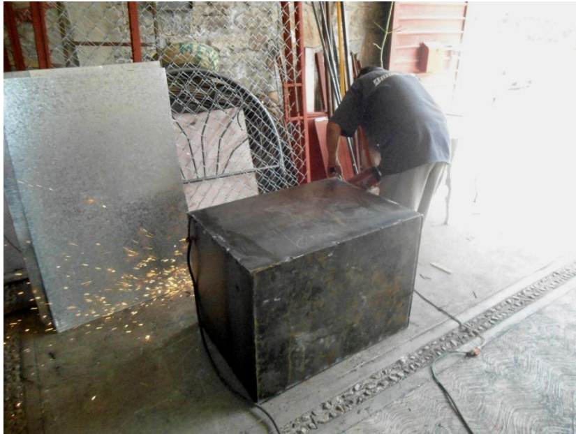
La caja de amortiguación en construcción
