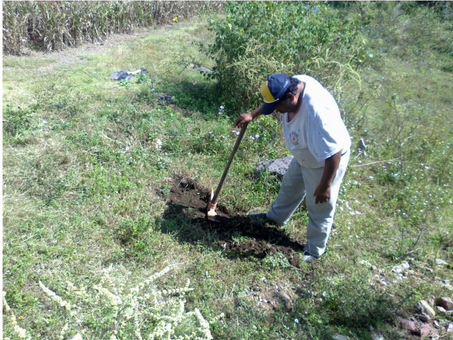
Iniciando los trabajos para instalación de aforador. Se niveló el suelo.
