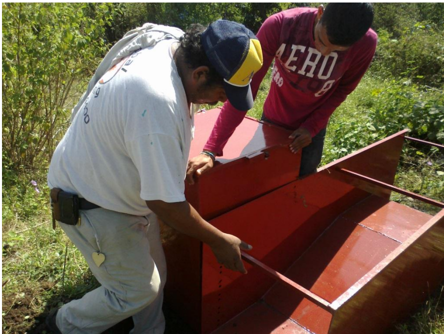
El proceso de ensamble de caja amortiguadora y canaleta de aforo
