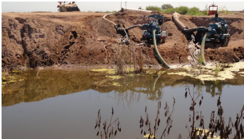
Ilustración 47. Bombeo de agua de drenaje para riego, el 04 de abril de 2013.
