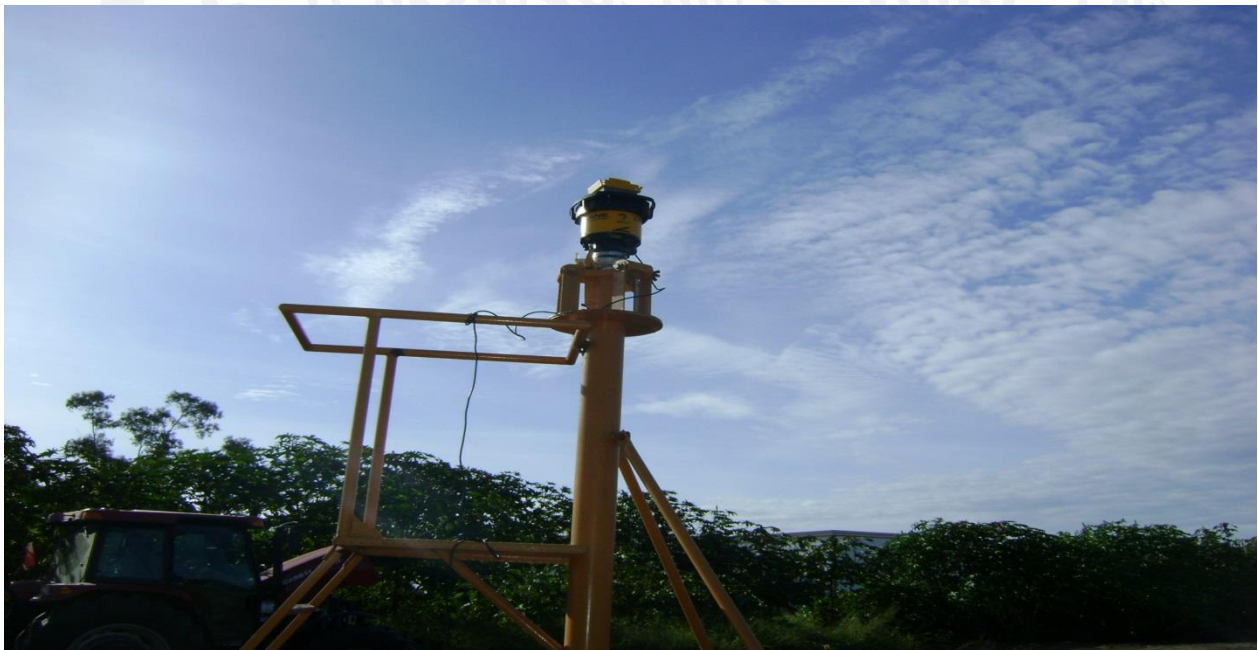
Ilustración 20. Trabajos de nivelación de tierras. Laser.
