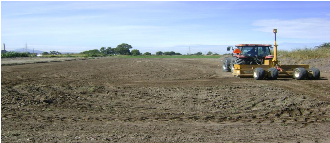
Ilustración 19. Trabajos de nivelación de tierras. Niveladora Laser.
