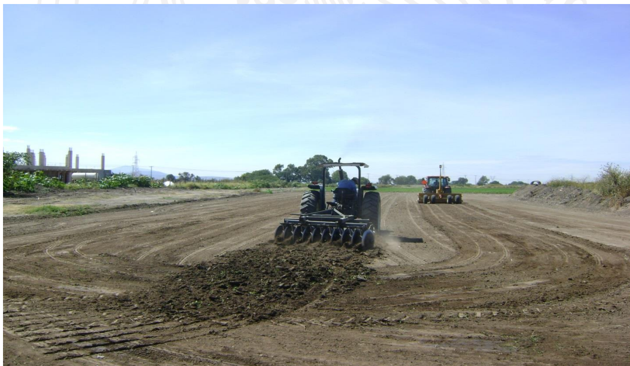
Ilustración 22. Preparación del terreno
