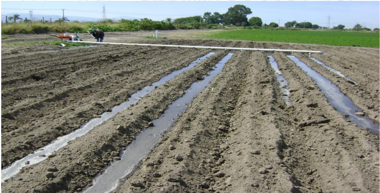
Ilustración 18. Líneas de tubería de muticompuestas y válvula hidrante.
