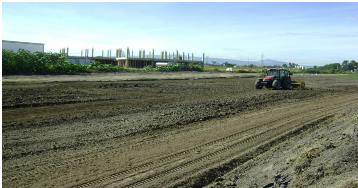
Ilustración 21. Preparación del terreno
