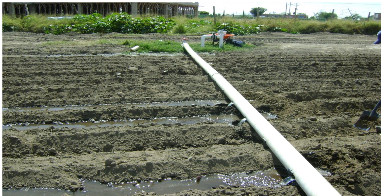
Ilustración 43. Ensayos en campo (pruebas de riego)
