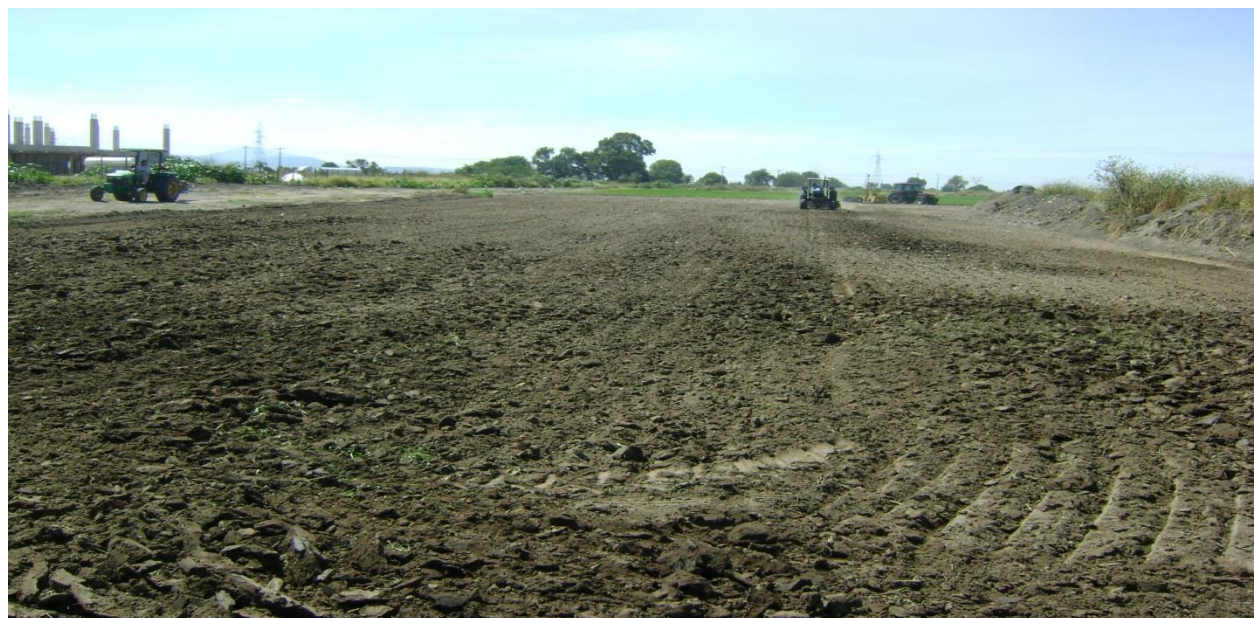
Ilustración 23. Preparación del terreno
