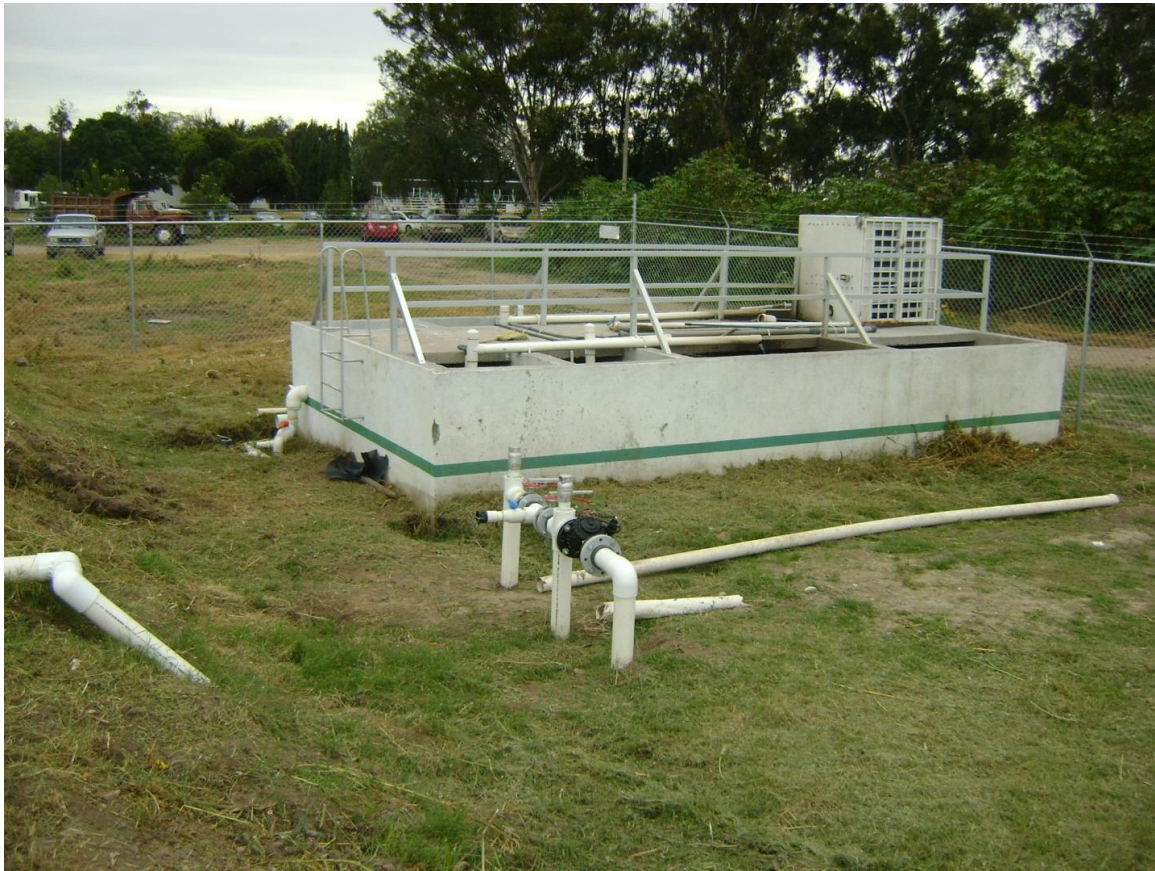
Ilustración 14. Adecuación a la planta de tratamiento.
