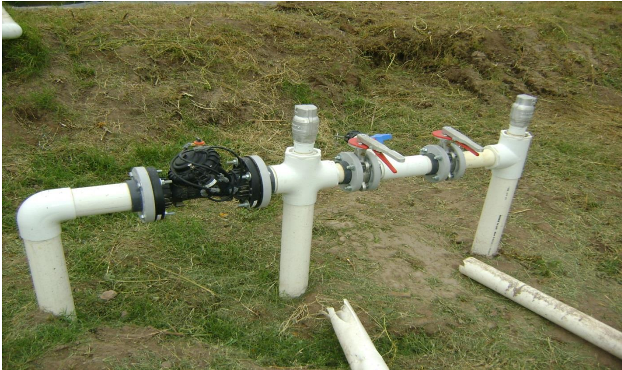
Ilustración 15. Adecuación a la planta de tratamiento.
