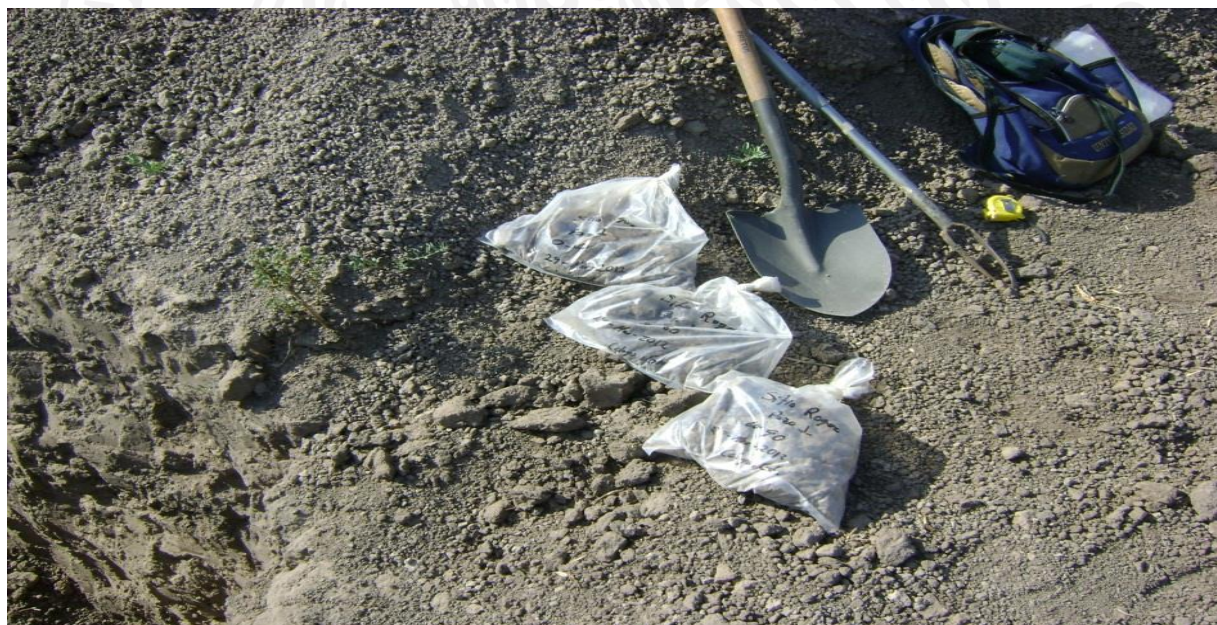
Ilustración 28. Trabajos de muestreo de suelos.
