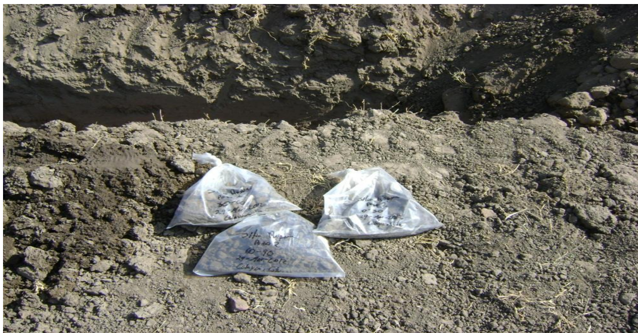
Ilustración 29. Trabajos de muestreo de suelos.
