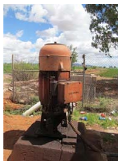
No tiene tubo para medir nivel dinámico
