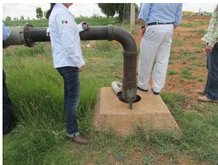
No tiene tubo para medir nivel dinámico
