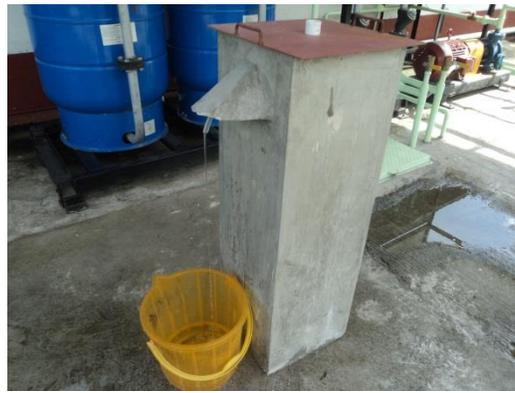
Figura 6. Filtro empacado con vidrio reciclado molido malla 80/90.
