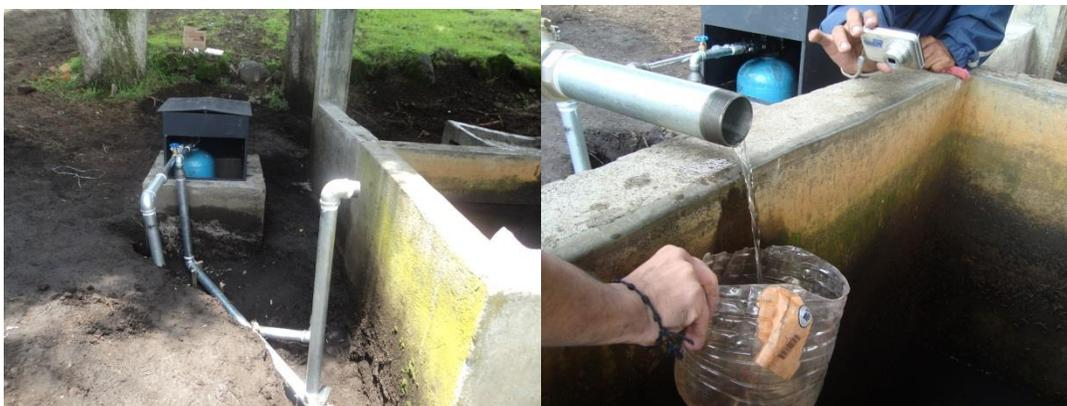
Figura 4. Filtro de carbón activado instalado en Fierro del Toro Huitzilac.
