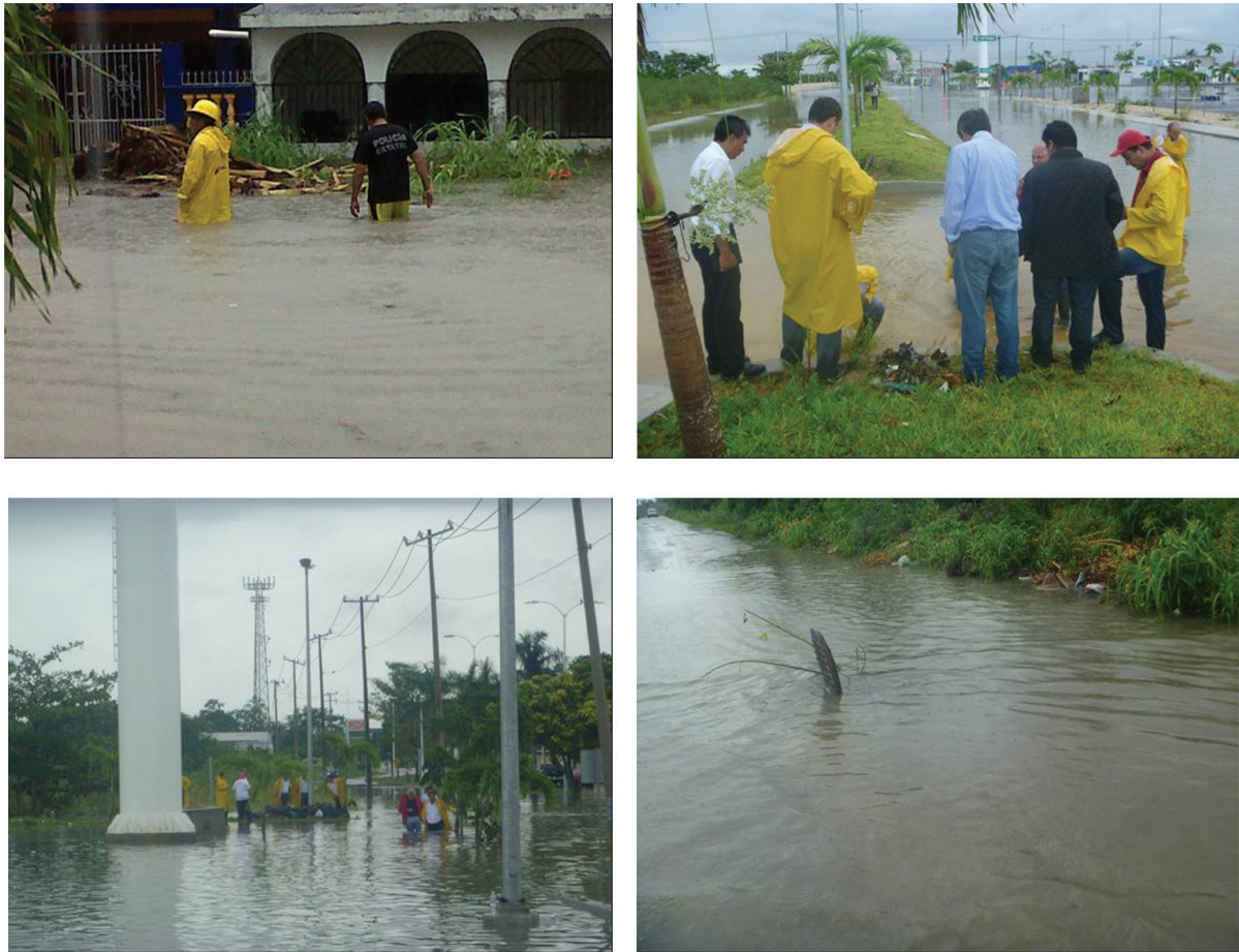
Figura 17. Drenaje deficiente debido a contaminación de vías públicas
