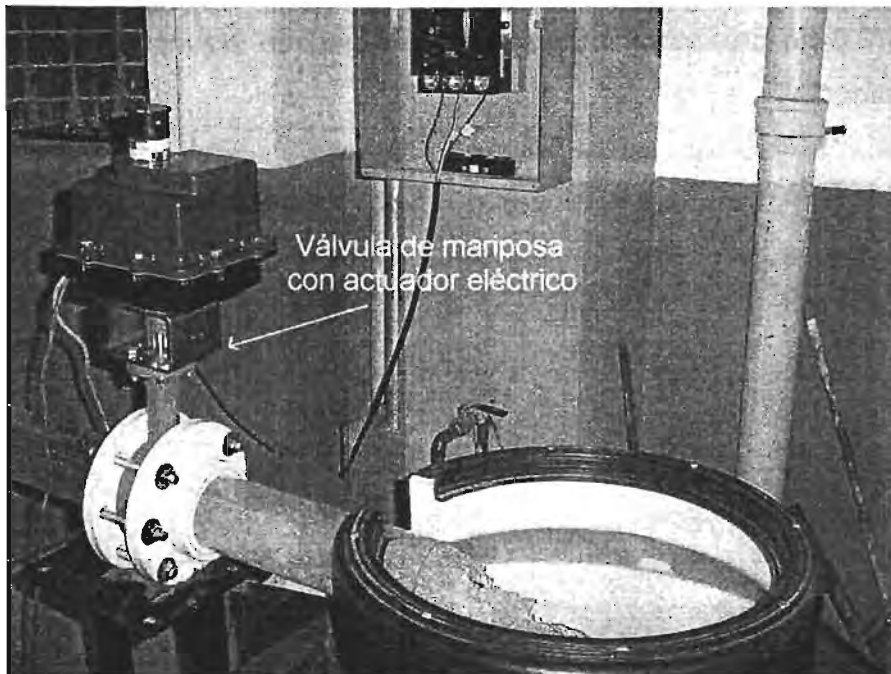
Figura 3.8. Final del segundo tramo de la tubería de pruebas
