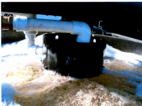
Figura 18 Prueba hidráulica con agua tratada a caudal máximo de 1 l/s.
