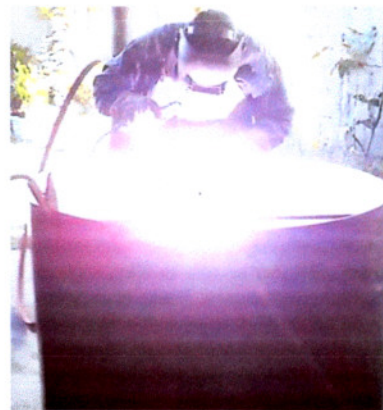
Figura 24 Fabricación de tanque principal aplicación de soldadura.
