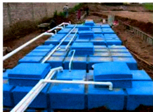
Figura 9 Ejemplos de plantas de tratamiento tipo paquete, fabricadas en fibra de vidrio marca BIOseptic.
