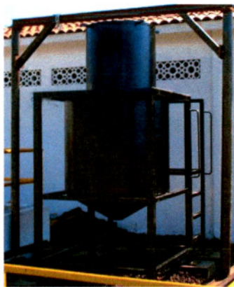
Figura 23 Instalación de tanque secundario dentro del tanque principal.
