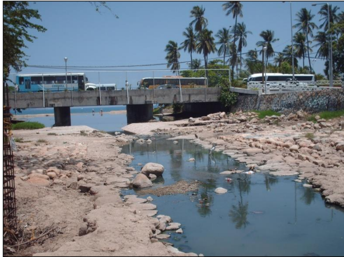
Fotografía 5. Medición de caudal y parámetros ambientales en la salida de la descarga del arroyo El Camarón.
