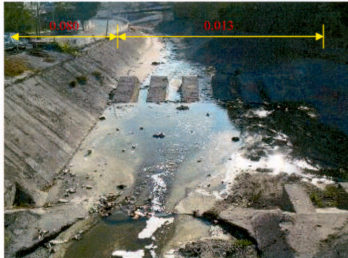
Figura 5.9 Condiciones existente en el canal del cauce y las márgenes para la selección de coeficientes de rugosidad "n" en la sección transversal del arroyo Topo Chico.
