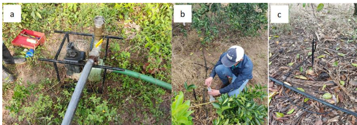
Figura 20. Instalación del sistema de riego por goteo.
