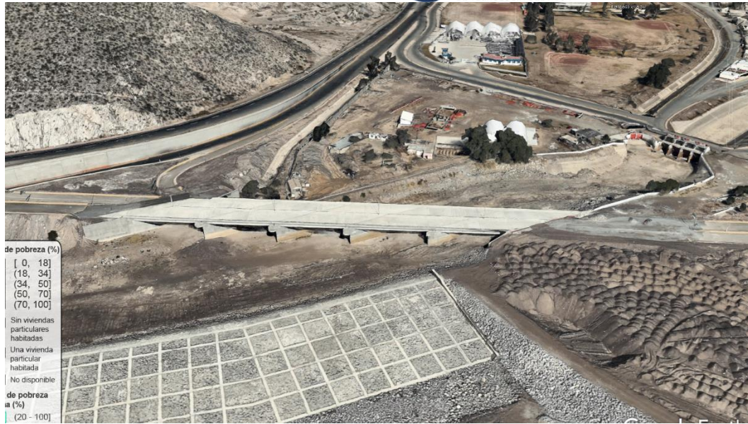
Figura 33. Imagen lecho seco del Nazas en la ZML, con extracción de material pétreo. Fuente: Google Earth , 2019.
