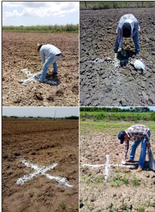
*Figura 29. Marcado de puntos de control sobre el terreno*
