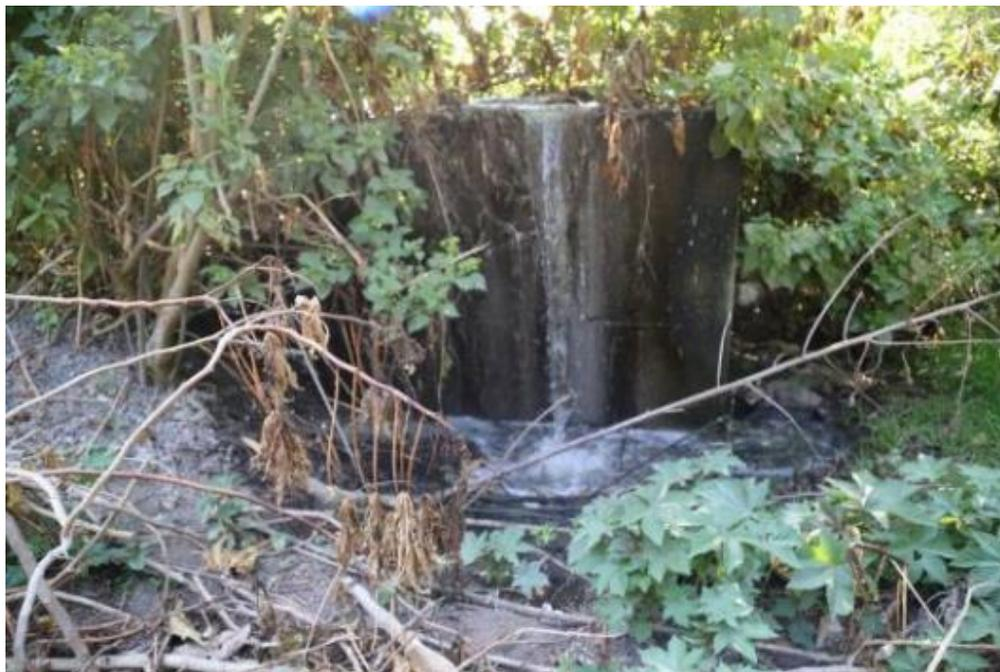
Foto 5.2.2.3.6- Segundo módulo de la PTAR. Punto donde se derrama prácticamente el 100% del agua residual sin completar el ciclo de tratamiento y se canaliza al río Amanalco.
