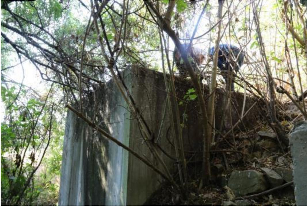
Foto 5.2.2.3.7- Cuarto y último módulo de la planta de tratamiento. A este módulo sólo llegan algunas gotas de agua.
