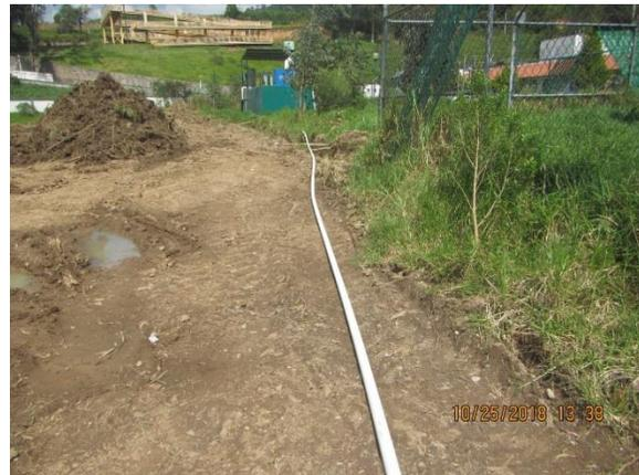
Foto 5.6.4.1.29 y 5.6.4.1.30- Manguera que encausa las aguas residuales, provenientes del cárcamo de bombeo, hacia el canal exterior sur del hospital.
