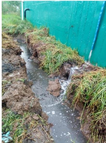
Foto 5.6.4.1.8- Aguas residuales provenientes del cárcamo de bombeo.
