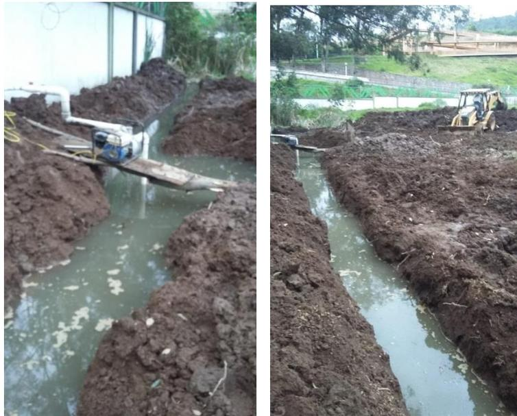
Foto 5.6.4.1.45 y 5.6.4.1.46- Se instaló en el cárcamo de bombeo una bomba de gasolina para enviar el agua hacia el canal exterior.
