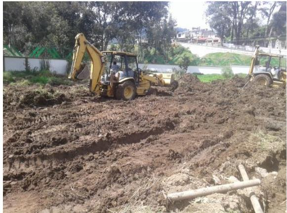
Foto 5.6.4.1.19 a la 5.6.4.1.22- Despalme y desalojo del material del área donde se instalará el humedal.
