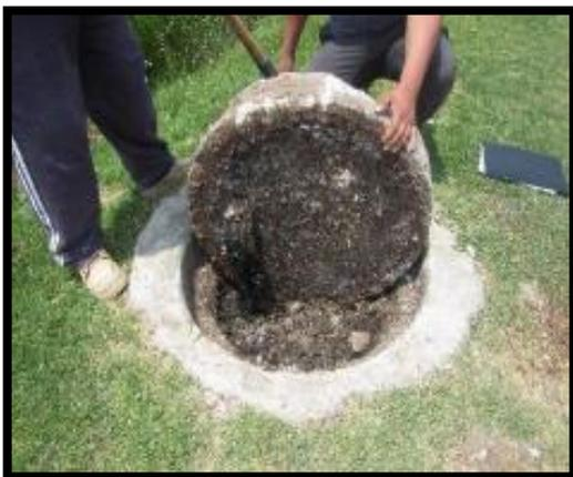
Foto 5.1.4.2.8- Aguas residuales y azolve retenido en los pozos de visita del colector marginal de Amanalco.
