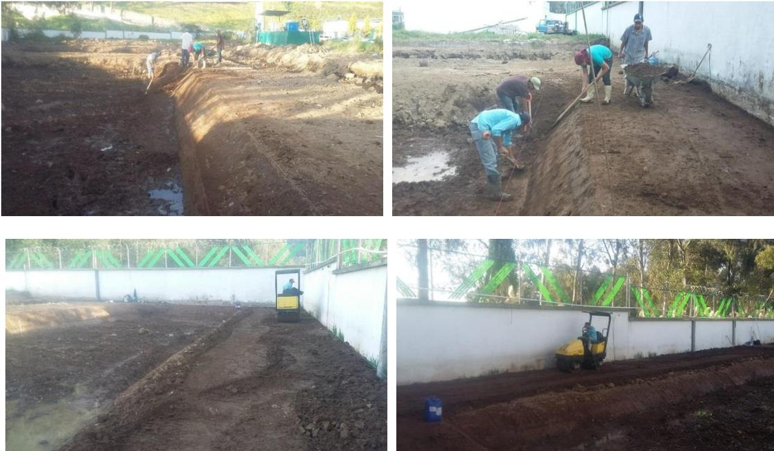
Foto 5.6.4.1.66 a la 5.6.4.1.69- Perfilado de los taludes y continuación de compactación de bordos.
