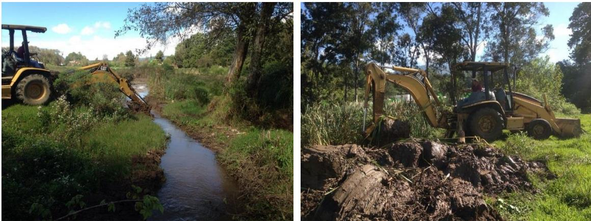
Foto 5.6.4.1.32 y 5.6.4.1.33- Desazolve de un tramo del canal sur exterior, a donde se enviaría el agua del cárcamo.
