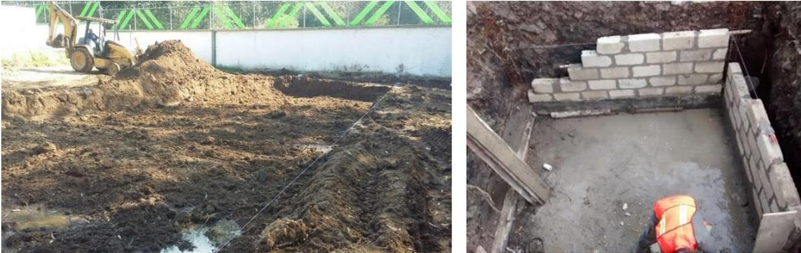
Foto 5.6.4.1.64 y 5.6.4.1.65- Construcción de los estanques y registros.
