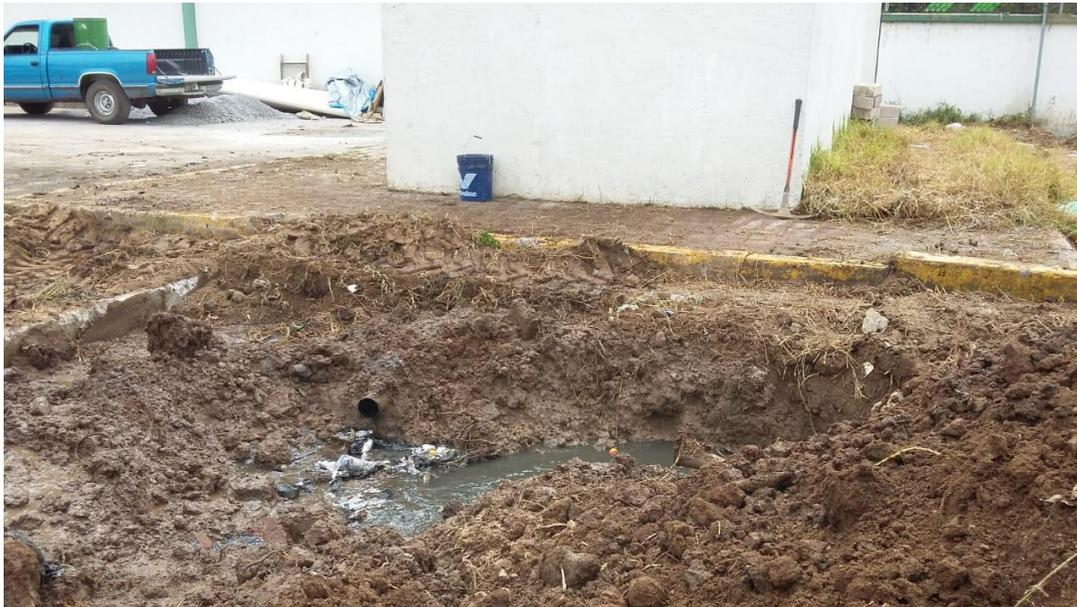
Foto 5.6.4.1.77-Tubería rota, que hace que se infiltre el agua residual a los estanques.
