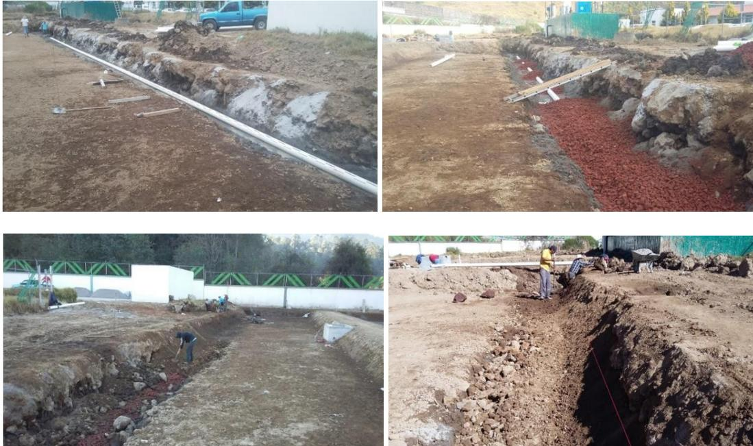
Foto 5.6.4.1.79 a la 5.6.4.1.82- Colocación de tubería ranurada para la subpresión.
