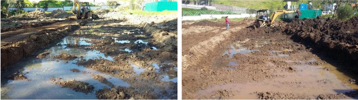
Foto 5.6.4.1.58 y 5.6.4.1.59- Dificultad para la excavación de los estanques.
