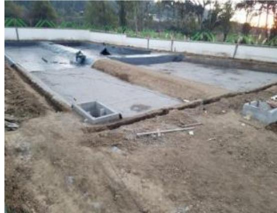
Fotos 5.2.2.4.9.1 a 5.2.2.4.9.6- Aspectos de la instalación del humedal artificial en el hospital del IMSS en Amanalco.
