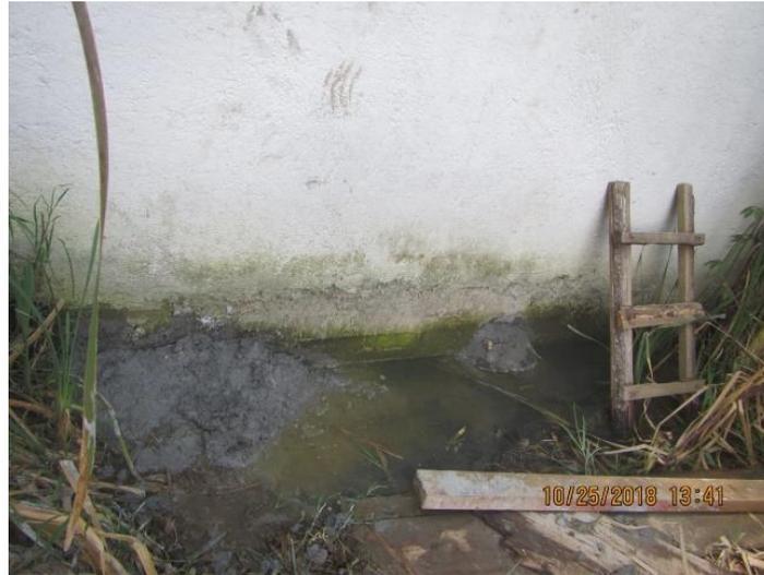
Foto 5.6.4.1.28- Taponamiento de las perforaciones que servían para drenar el terreno.
