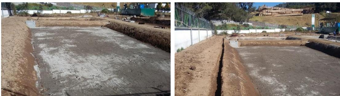
Foto 5.6.4.1.83 y 5.6.4.1.84 Colocación de capa de arena en los estanques.
