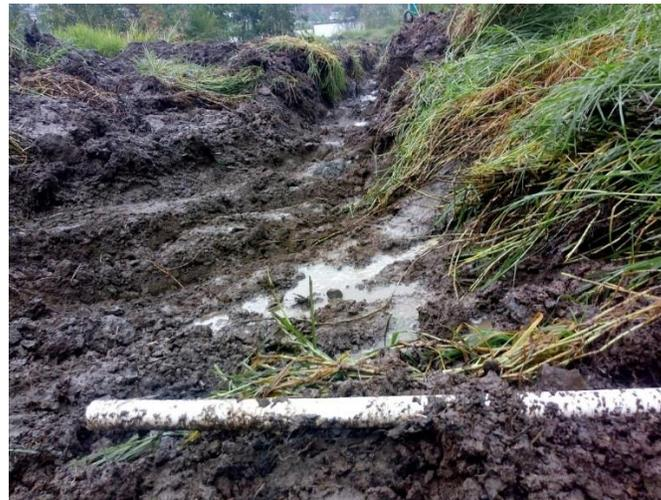
Foto 5.6.4.1.5 y 5.6.4.1.6- Construcción de canales para drenar agua.
