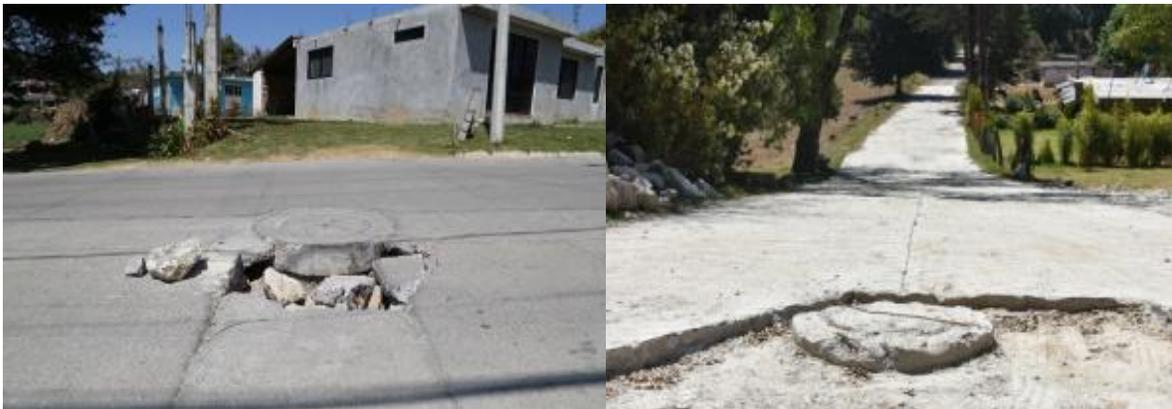
Fotos 5.4.2.1 y 5.4.2.2- Calles de San Mateo con pavimento dañado por las obras de drenaje.
