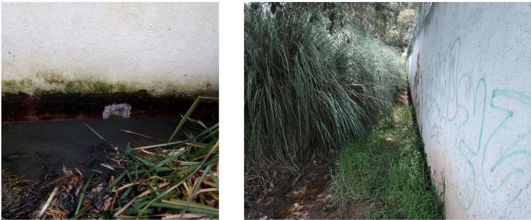
Foto 5.6.4.1.9 y 5.6.4.1.10- Agujero en la pared y el canal exterior al IMSS, donde estaba vertiendo el agua.
