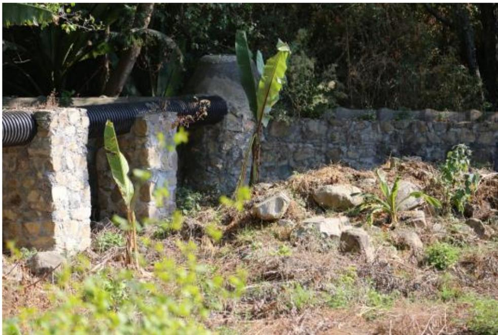
Foto 5.2.2.3.4- Fotografía del colector de alcantarillado de San Francisco Mihualtepec antes de llegar a la planta de tratamiento.
