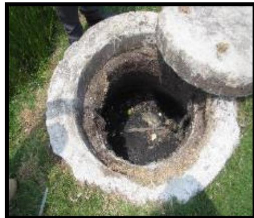
Foto 5.1.4.2.7- Aguas residuales y azolve retenido en los pozos de visita del colector marginal de Amanalco.
