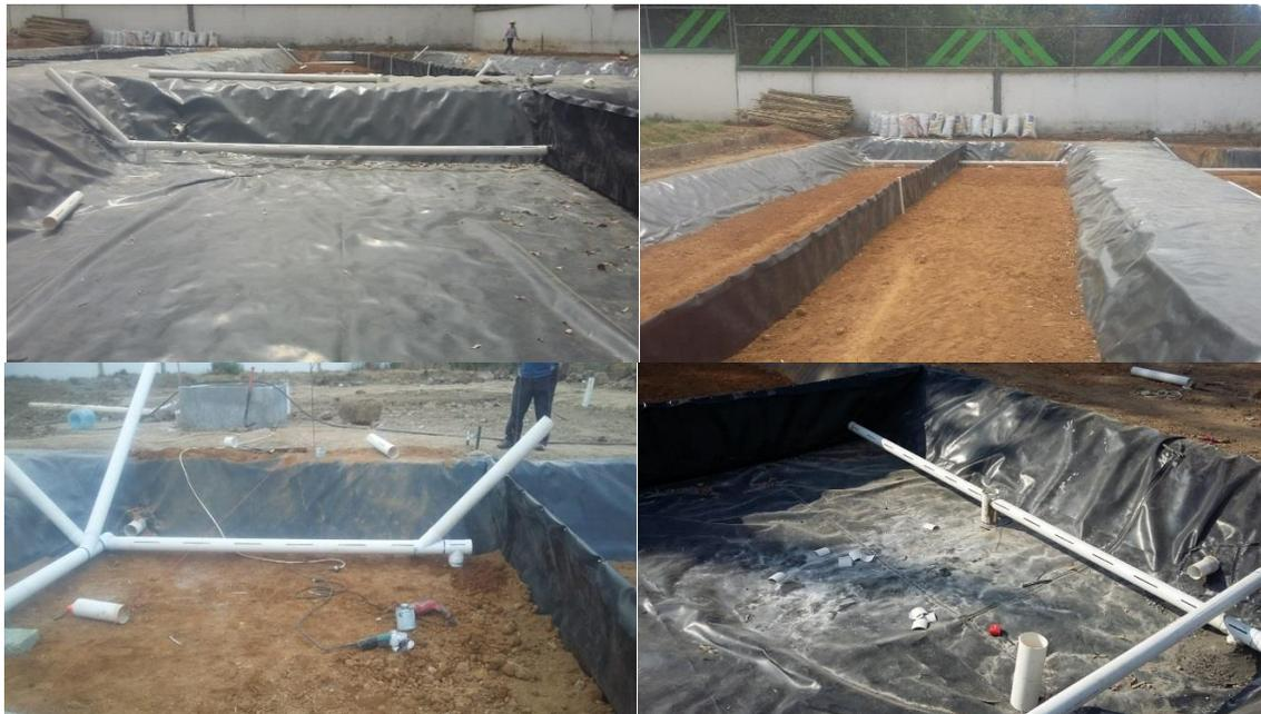
Foto 5.6.4.1.89 a la 5.6.4.1.92 Colocación de capa de arcilla, sobre la que se colocaron las tuberías.
