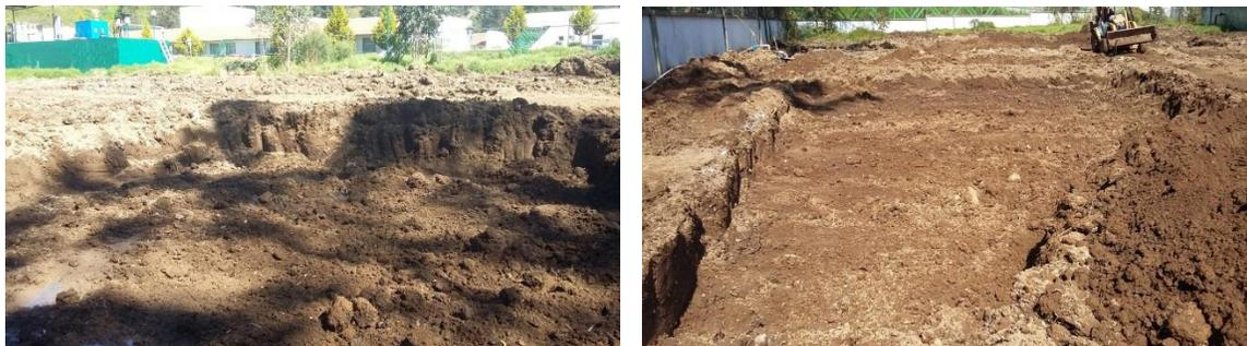
Foto 5.6.4.1.56 y 5.6.4.1.57- Excavación de los estanques.
