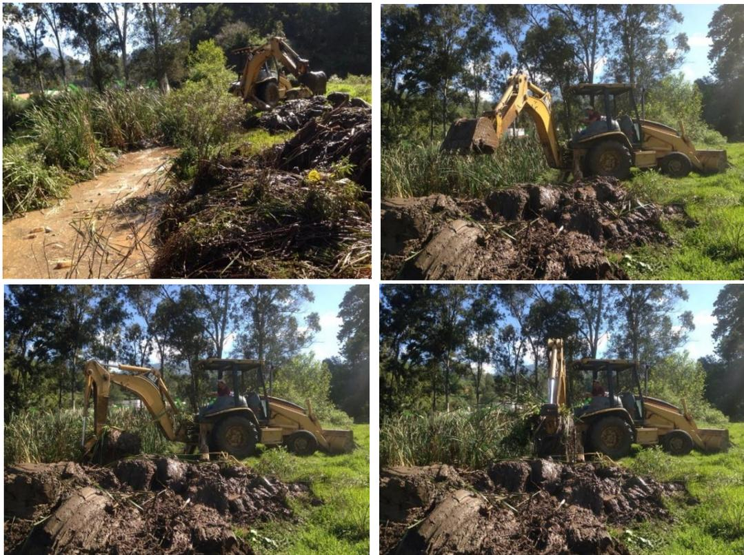
Foto 5.6.4.1.39 a la 5.6.4.1.42- Desazolve del canal sur mediante la retroexcavadora para facilitar el flujo del agua.
