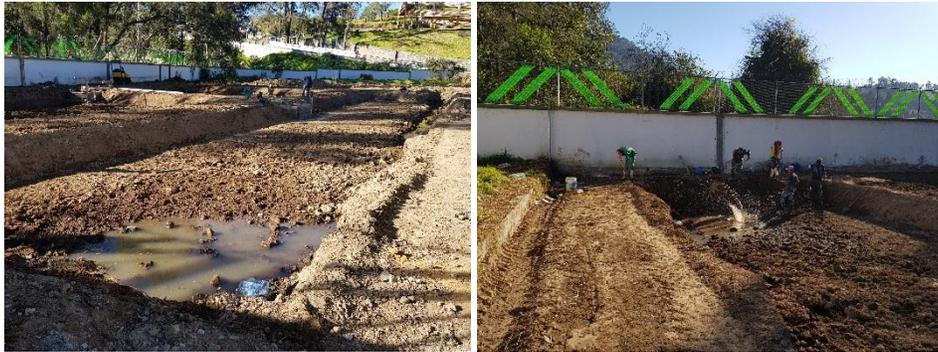
Foto 5.6.4.1.70 y 5.6.4.1.71- Agua en estanque, de tubería rota de aguas residuales proveniente del Hospital.
