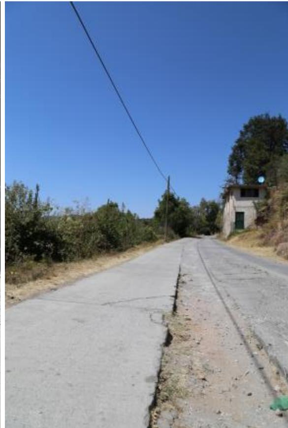
Fotos 5.4.3.3 y 5.4.3.4- Aspectos de las calles de San Miguel Tenex-tepec dañadas por la introducción de drenaje en la 1ª Sección.
