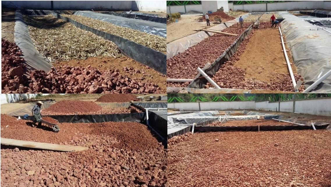
Foto 5.6.4.1.93 a la 5.6.4.1.96- Relleno de dos humedales con medio filtrante y cuatro con tezontle.
