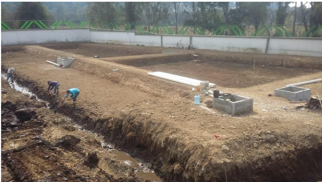
Foto 5.6.4.1.78 Canal para eliminar el agua residual del tubo junto a la caseta de desperdicios.
