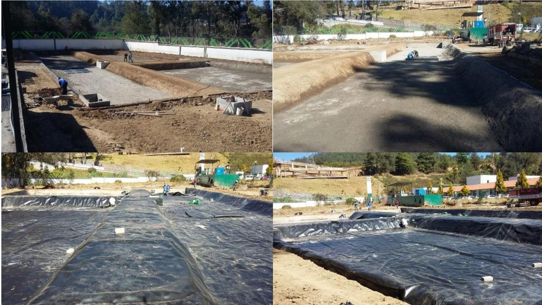
Foto 5.6.4.1.85 a la 5.6.4.1.88 Colocación de capa de arena y de geomembrana para su impermeabilización.
