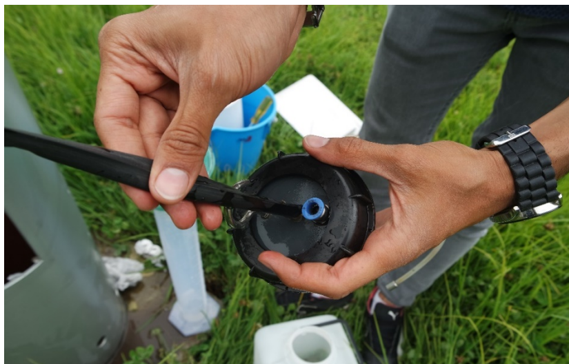
Figura 18 Forro negro para aislar la luz y evitar la proliferación de algas
