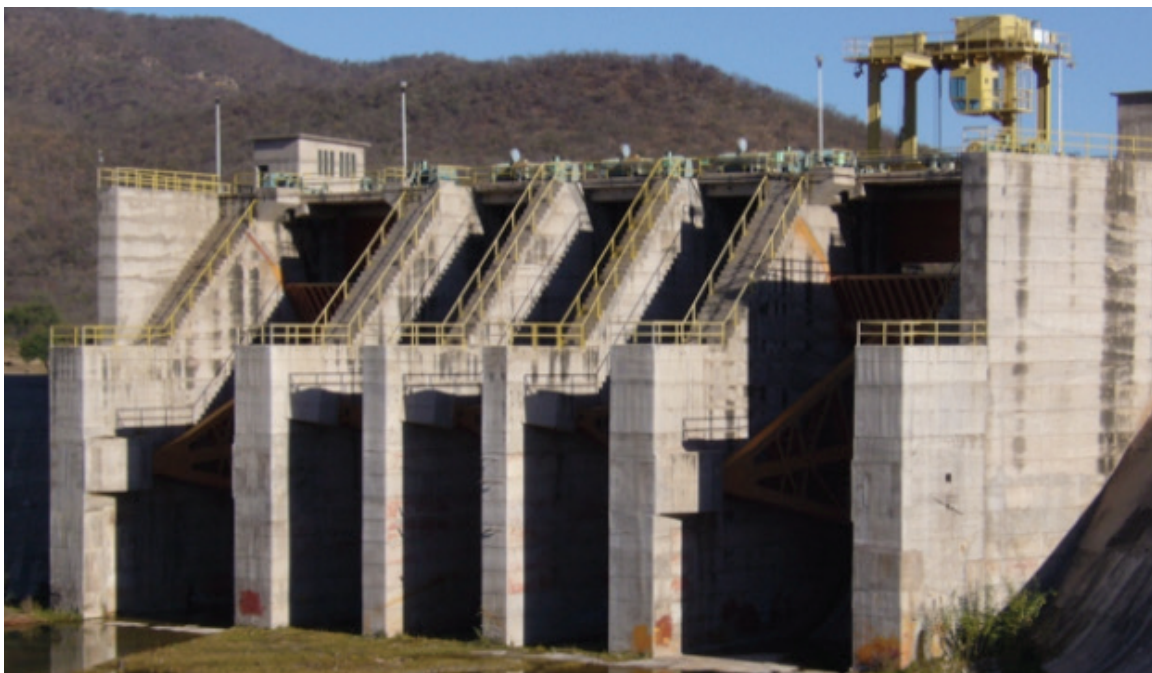
Figura 4.10. Presa Adolfo Ruíz Cortínez, "Mocuzari", Álamos, Sonora, 1955
