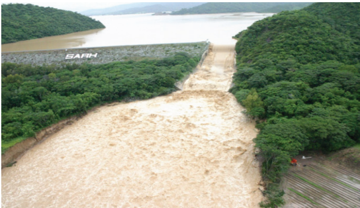
Figura 4.7. Presa derivadora “Juan Sabines”, Chiapas 1982
