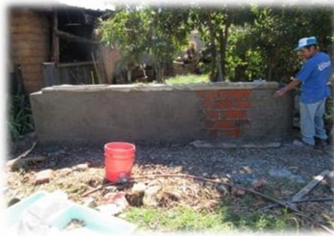
Ilustración 24: Aplanado exterior del lavadero ecológico.
