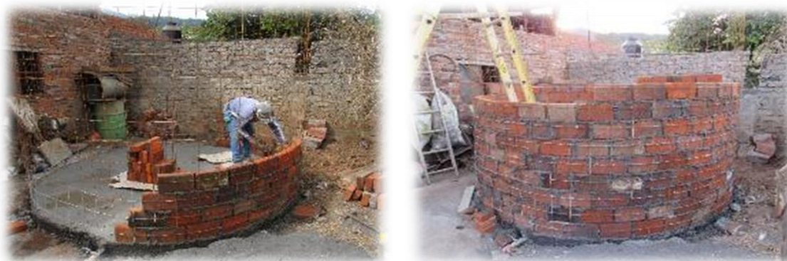
Ilustración 44: Levantamiento de muro capuchino.
