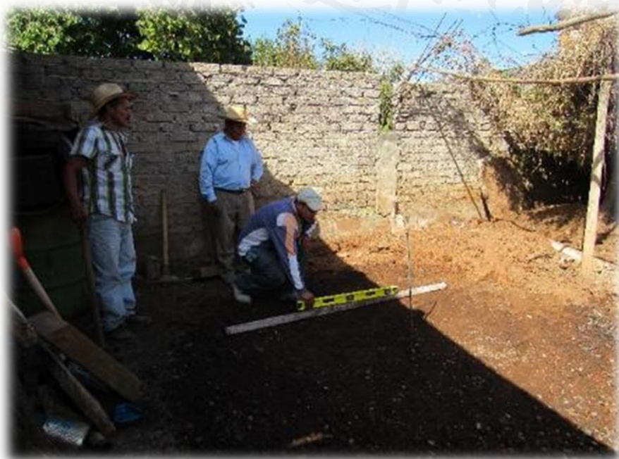
Ilustración 35: Nivelación del terreno.
