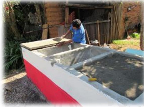
Ilustración 27: Colocación de rellenos en el lavadero ecológico.
