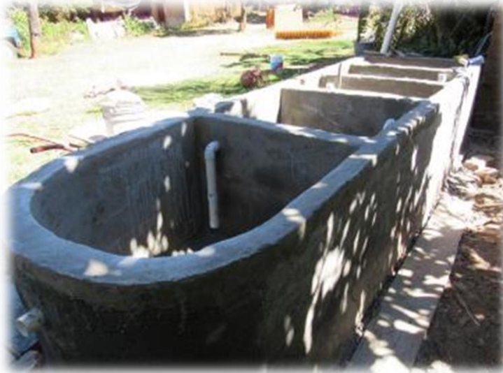
Ilustración 26: Instalación de la tubería.
