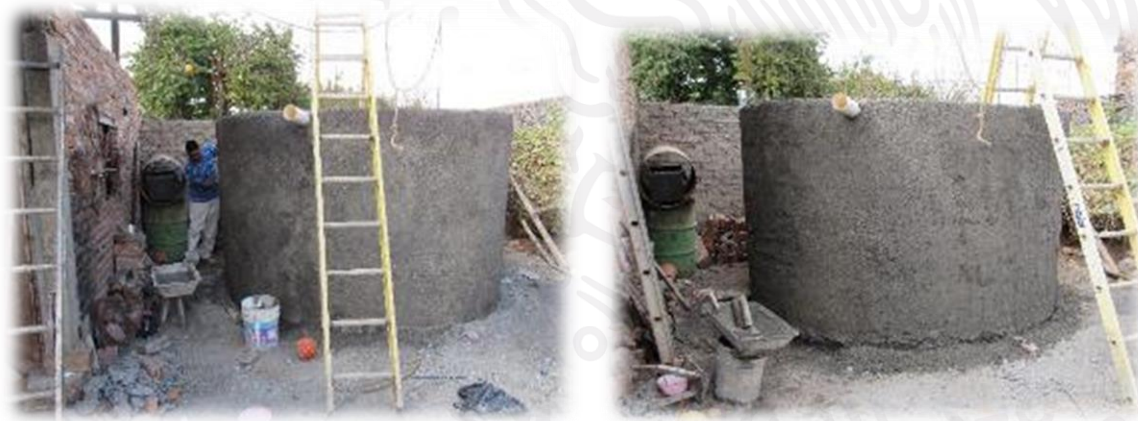
Ilustración 45: Aplanado exterior de la cisterna.
