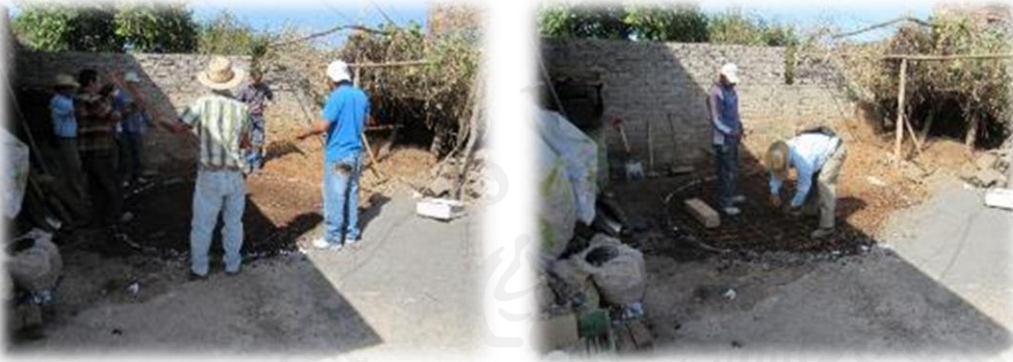
Ilustración 38: Montaje y fijación de la malla electrosoldada para el piso.
