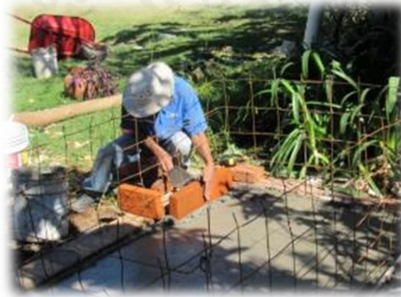
Ilustración 22: Elaboración del muro tipo capuchino.
