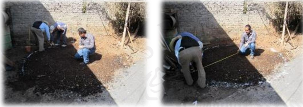
Ilustración 36: Trazo de la circunferencia de la cisterna tipo capuchino.
