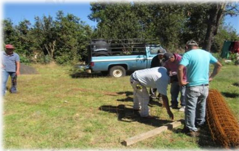
Ilustración 17: Corte de malla electrosoldada.
