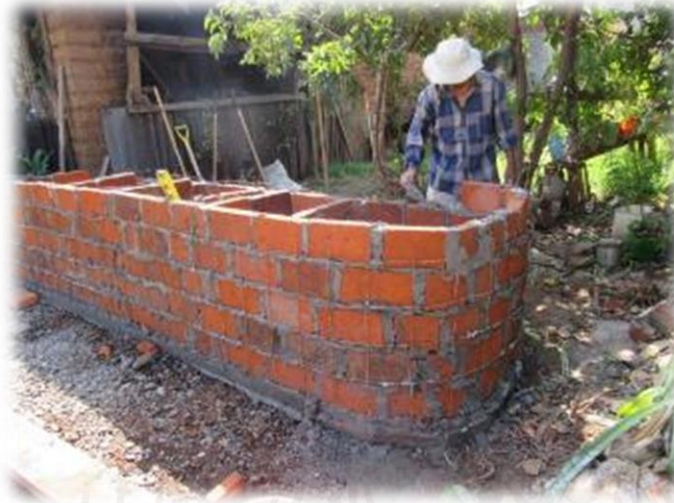
Ilustración 23: Colocación del tabique entrelazado.
