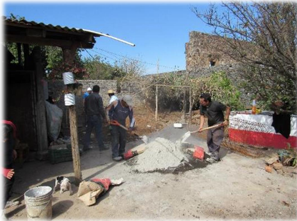
Ilustración 40: Preparación de la revoltura de concreto.
