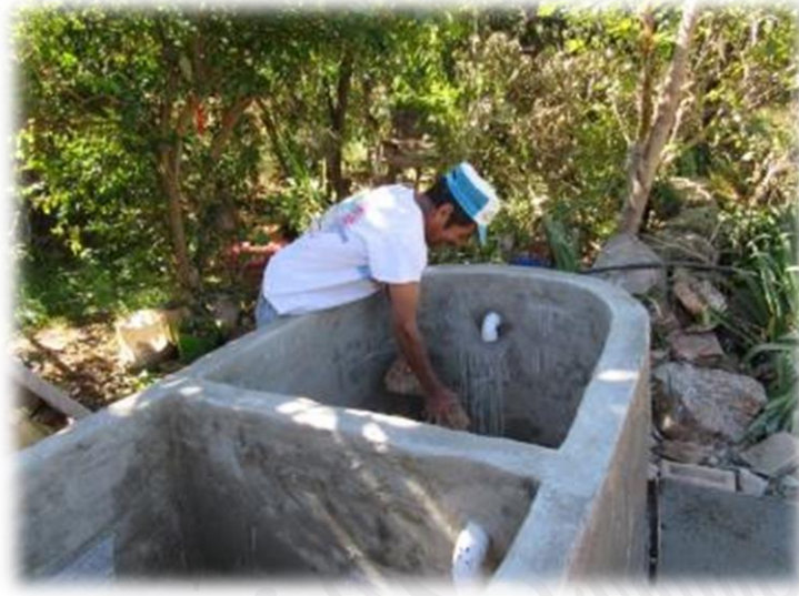
Ilustración 25: Aplanado interior del lavadero ecológico.
