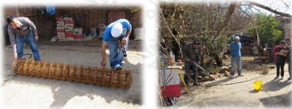
Ilustración 37: Corte de malla electrosoldada.
