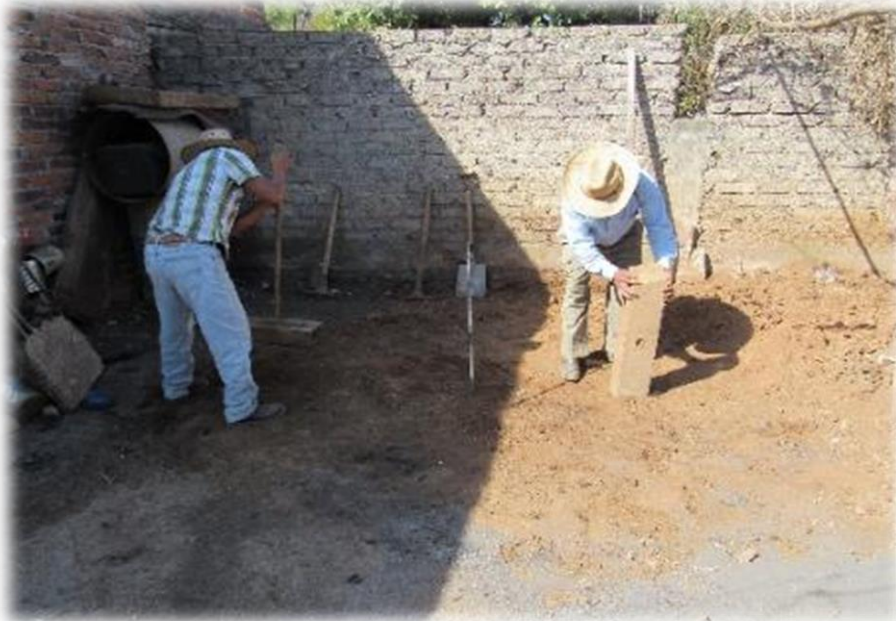
Ilustración 33: Compactación del suelo.
