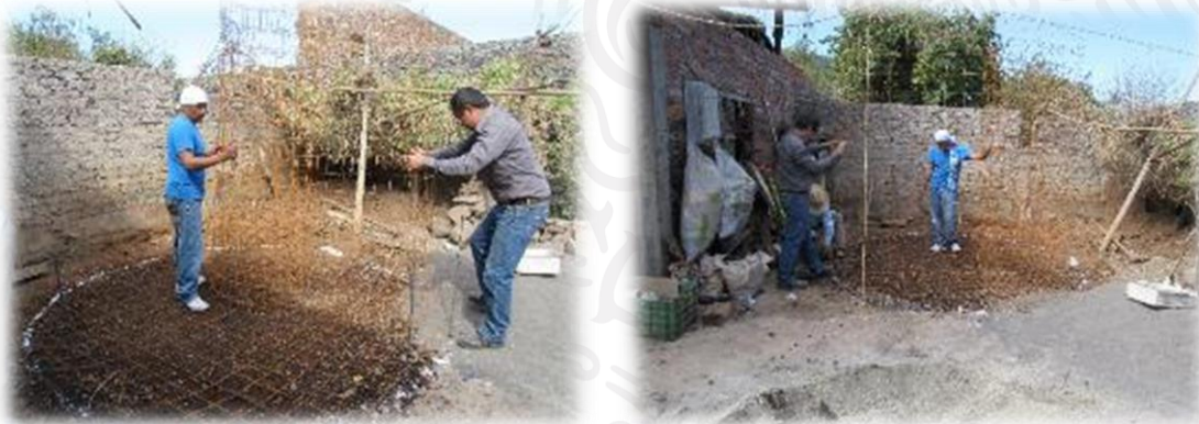
Ilustración 39: Armado de la estructura cilíndrica.
