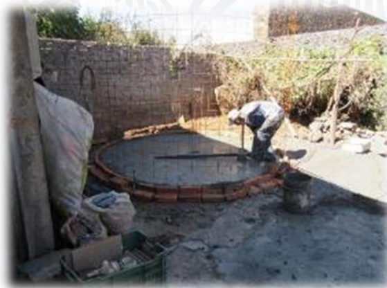
Ilustración 43: Nivelación de la losa de fondo.
