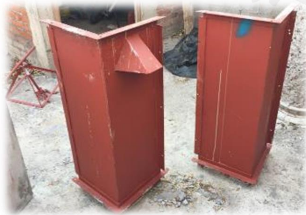
Ilustración 51: Molde para el filtro de flujo lento terminado.
