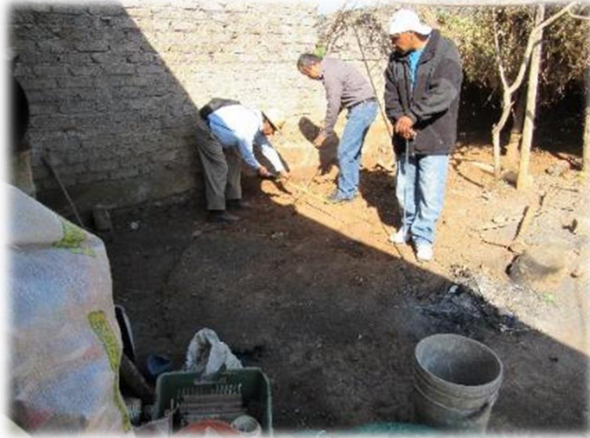
Ilustración 32: Trazo preliminar de la circunferencia.
