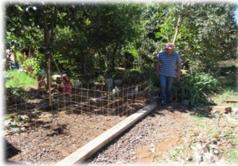
Ilustración 19: Preparación del terreno para la losa de fondo..
