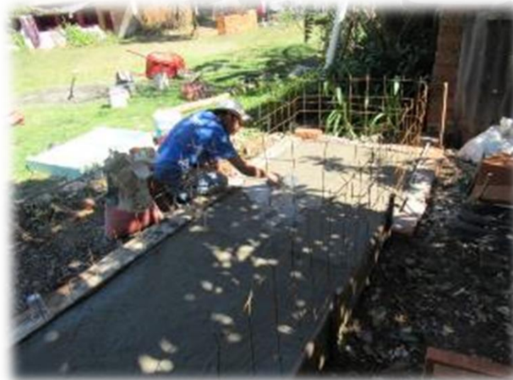
Ilustración 21: Compactado y pulido de la losa de fondo.
