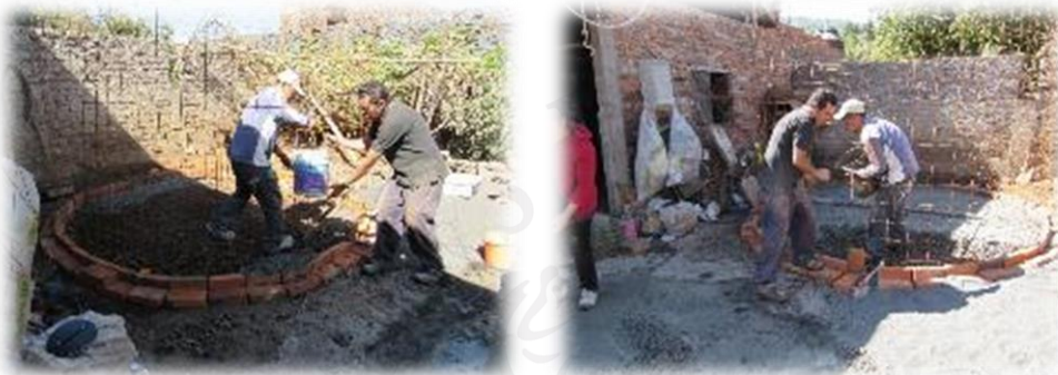
Ilustración 42: Colado de la losa de fondo de la cisterna.
