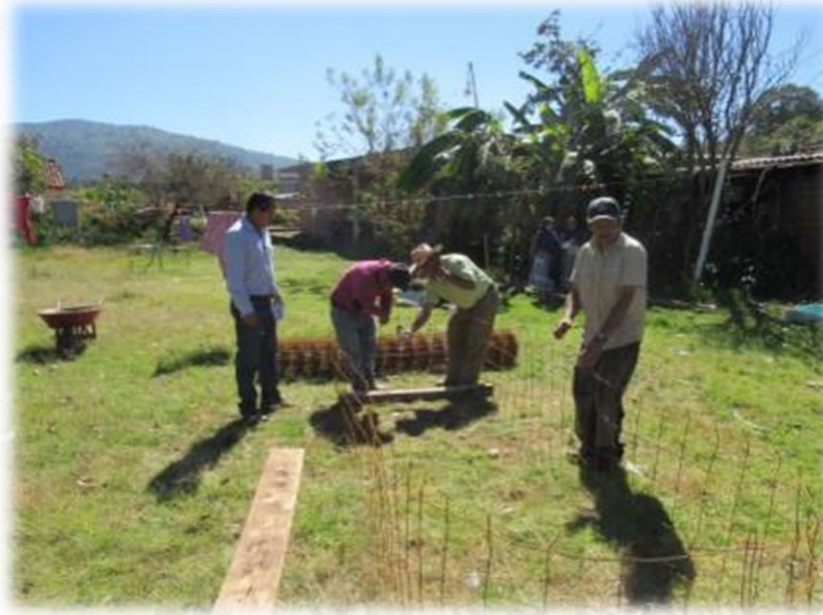
Ilustración 18: Armado de la estructura del lavado ecológico.
