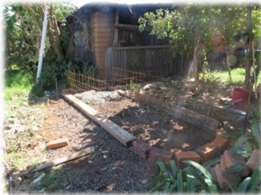
Ilustración 20: Colocación de fronteras para el colado de la losa de fondo.
