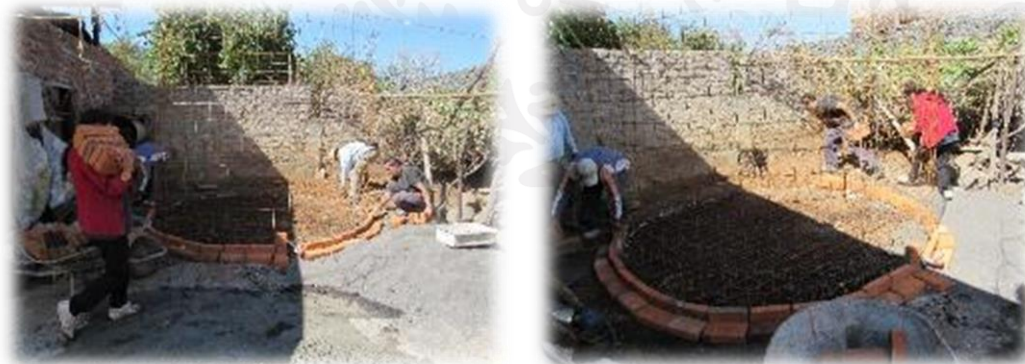
Ilustración 41: Colocación de fronteras en la periferia de la cisterna.
