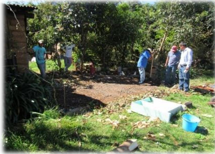
Ilustración 15: Compactación del terreno.
