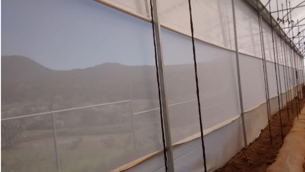
FIGURA 13. Cortina lateral parcialmente abierta para ventilación del invernadero.
