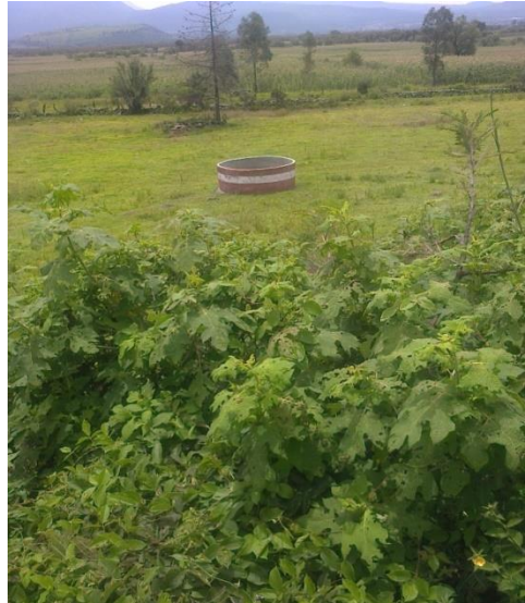
Figura 2. Tanque de descarga de fondo en Potrero de Las Cuevas.
