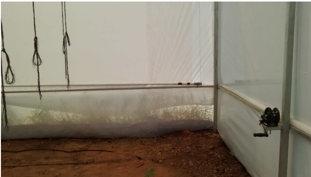
FIGURA 14. Cortina lateral cerrada y manivela del malacate de control.
