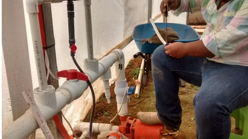
FIGURA 31. Cambio de mangueras entre bomba y entrada al sistema de riego.
