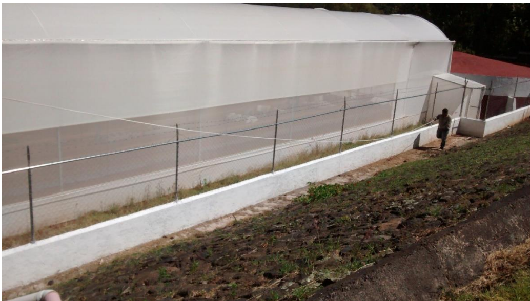
FIGURA 9. Vista parcial del invernadero con cortina lateral parcialmente abierta.
