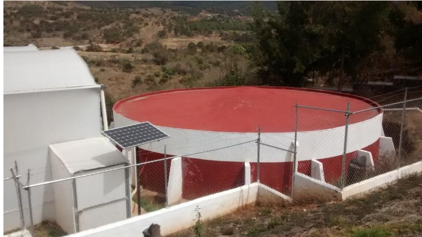
FIGURA 29. Vista del techo del tanque después de su limpieza.
