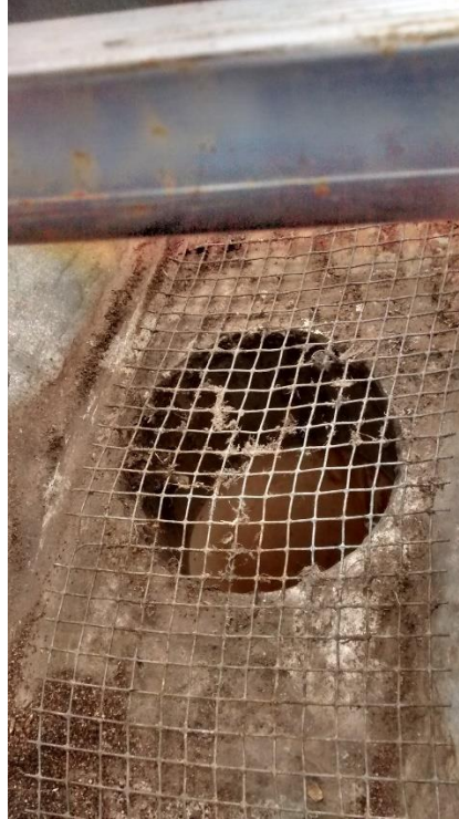
FIGURA 27. Entrada al tubo bajante de agua al final de canaleta.
