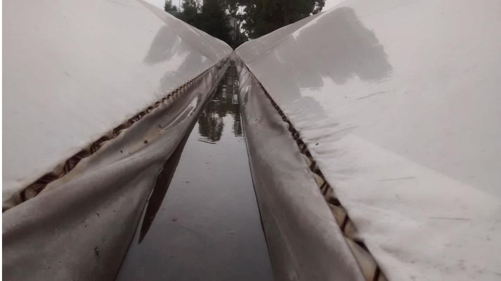
FIGURA 18. La canaleta central que conduce el agua de lluvia al tubo bajante.
