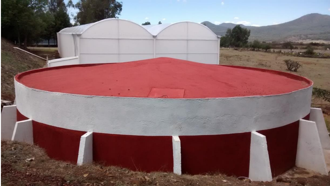
FIGURA 20. Vista general del tanque-cisterna para captación de agua de lluvia.
