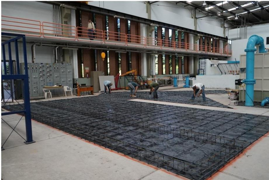
Figura 2-7. Armado para el firme de concreto
