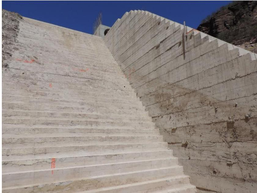
*Figura 4-79. Zona de la cortina donde el modelo numérico arrojó esfuerzos de tensión que superan la resistencia.*
