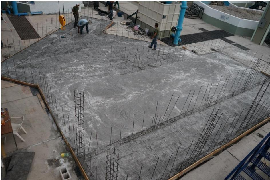
*Figura 2-10. Losa de concreto hidráulico terminada*
