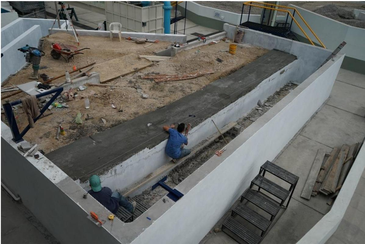
*Figura 2-15. Nivelación a plomo y colocación de tarrajas*
