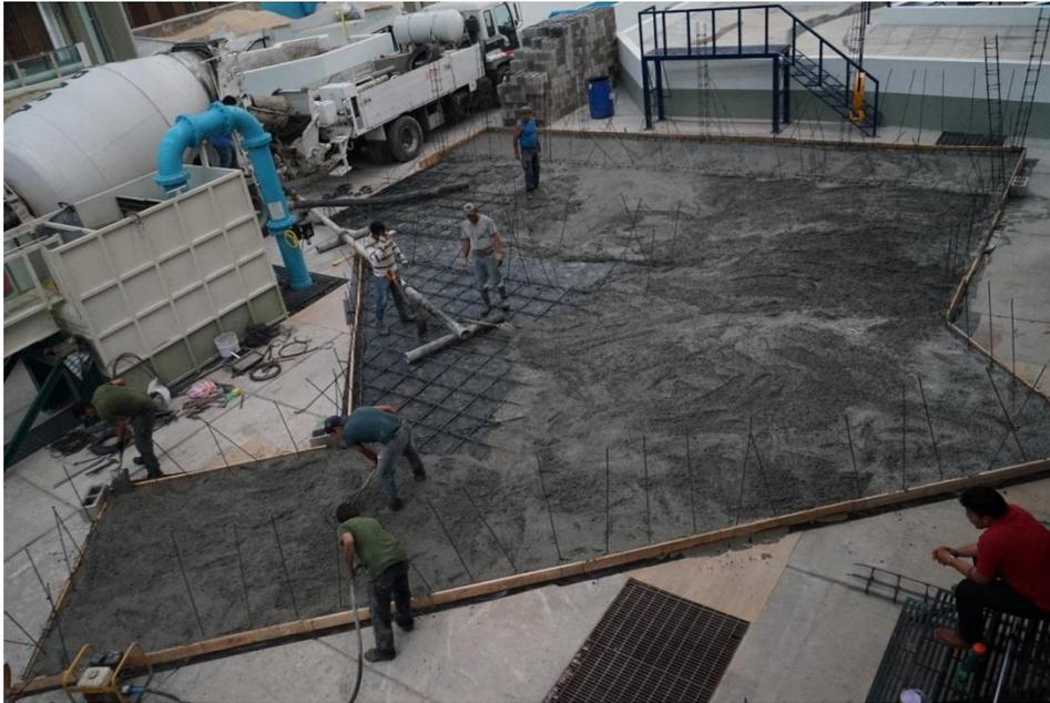
*Figura 2-9. Colado de concreto para conformar el firme*
