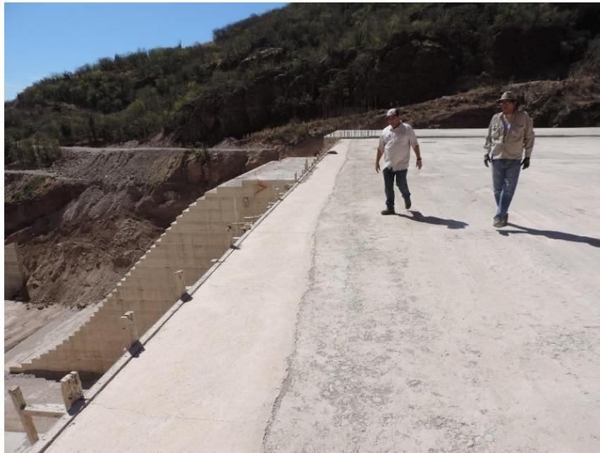
Figura 4-81. Vista general de la chapa de concreto  $f'c=150$  kg/cm<sup>2</sup>.
