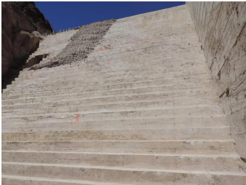
*Figura 4-80. Vista general del monolito 6, donde el modelo numérico arrojó zonas de tensión.*
