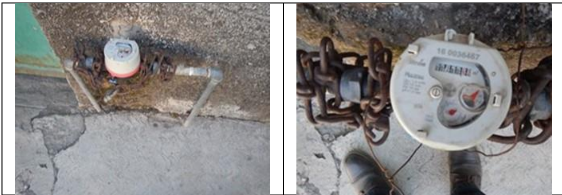
Figura 11. Medidor Itrón, Multimag, 160036467, Clase C, sin VAF. Cuadro de toma y detalle de medidor con número de serie. Comunidad El sauz alto, municipio de Pedro Escobedo. Lectura del medidor: 180.47 m 3 . Atendió el titular del contrato. Indica servicio continuo. Comentó que tiene rentada la casa. El medidor no tiene su tapa y se encontró que debe corregirse la marca (es Itrón, no Itrón-Actaris) en el catálogo de medidores del sistema informático.
