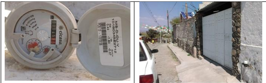
Figura 26. Medidor CICASA, MS Delaunet 17270136, clase B, sin VAF. Detalles de medidor con número de serie. Comunidad San Fandila, municipio de Pedro Escobedo. Lectura del medidor: 45.873 m 3 . Se encontró que debe corregirse el modelo (es MS-Delaunet, no MMD-15-LR) en el padrón de usuarios.
