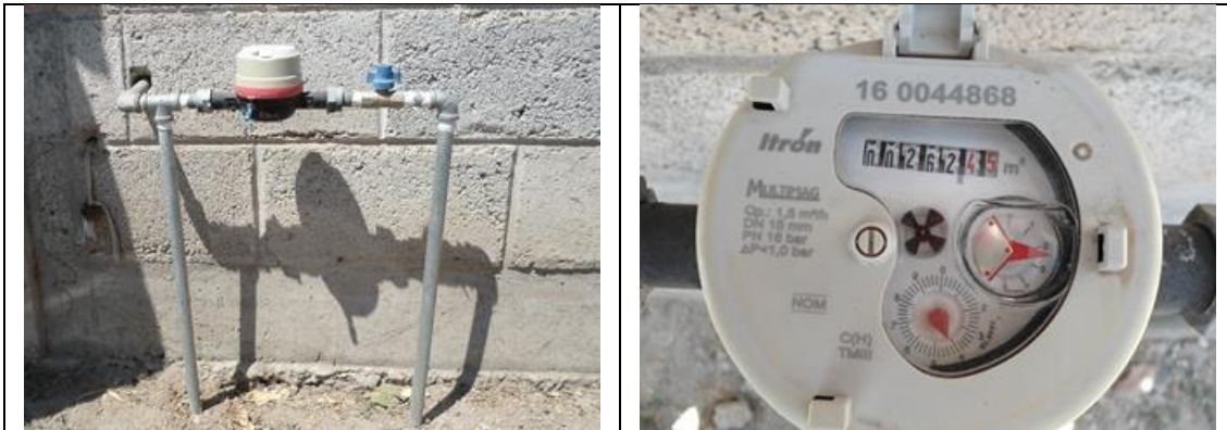
Figura 5. Medidor Itrón, Multimag 160044868, clase C, con VAF. Cuadro de toma y detalle de medidor con número de serie. Colonia Loma Bonita, municipio de Pedro Escobedo. Lectura del medidor: 262.45 m 3 . Se encontró que debe corregirse la marca (es Itrón, no Itrón-Actaris) en el padrón de usuarios. No se encontró a ninguna persona en el domicilio.
