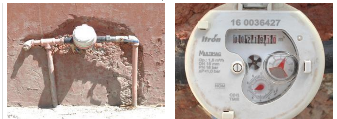
Figura 24. Medidor Itrón, Multimag 160036427, clase C, sin VAF. Cuadro de toma y detalle de medidor con número de serie. Comunidad Quintanares, municipio de Pedro Escobedo. Lectura del medidor: 219.10 m 3 . Se encontró que debe corregirse la marca (es Itrón, no Itrón-Actaris) en el padrón de usuarios. Atendió usuario titular.
