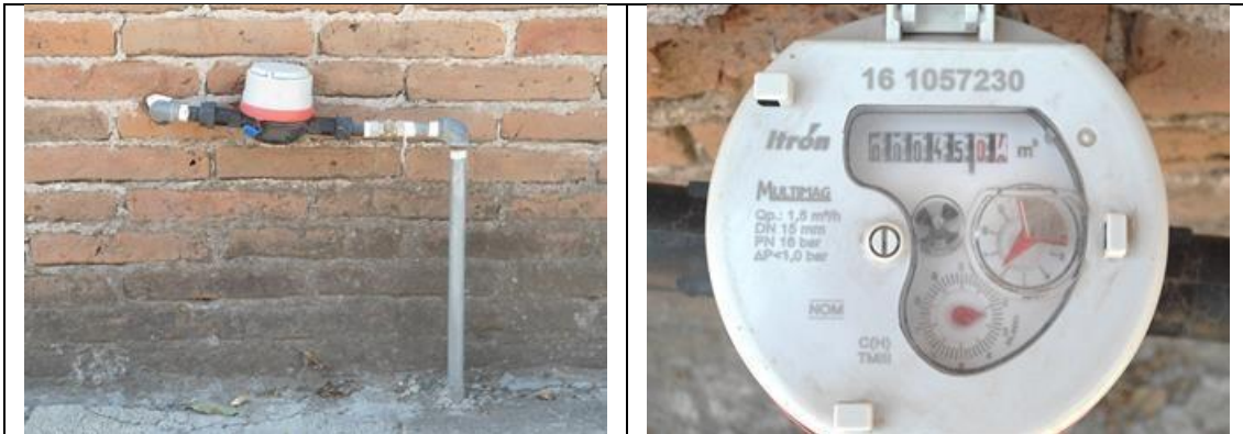
Figura 23. Medidor Itrón, Multimag 161057230, clase C, sin VAF. Cuadro de toma y detalle de medidor con número de serie. Comunidad Quitanares, municipio de Pedro Escobedo. Lectura del medidor: 45.07 m 3 . Se encontró que debe corregirse la marca (es Itrón, no Itrón-Actaris) y actualizarse el número de predio (25-B) en el padrón de usuarios. Atendió hija del usuario titular.
