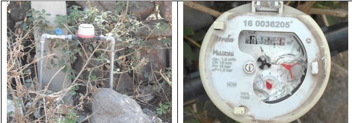
Figura 25. Medidor Itron, Multimag 160036205, clase C, con VAF. Cuadro de toma y detalle de medidor con número de serie. Comunidad San Cirilo, municipio de Pedro Escobedo. Lectura del medidor: 80.19 m 3 . Se encontró que debe corregirse la marca (es Itron, no Itron-Actaris) en el padrón de usuarios. El medidor presenta el cristal de la carátula roto, por lo que debe ser reemplazado. No se encontró a ninguna persona en el domicilio.
