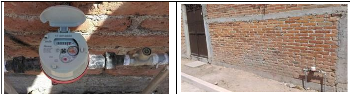
Figura 20. Medidor Itrón, Multimag, 176014652, Clase C, con VAF. Cuadro de toma y detalle de medidor con número de serie. Comunidad La Venta, municipio de Pedro Escobedo. Lectura del medidor: 0.363 m 3 . Se encontró que debe corregirse la marca (es Itrón, no Itrón-Actaris) en el catálogo de medidores del sistema informático.
