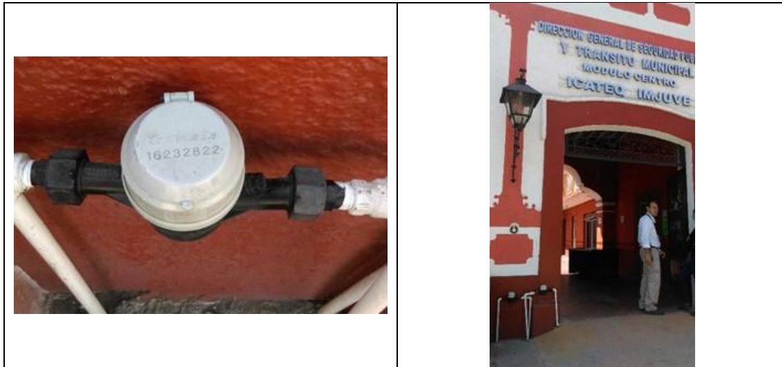
Figura 2. Medidor CICASA, MS Delaunet 16232822, clase B, sin VAF. Detalles de medidor con número de serie. Colonia Centro, municipio de Pedro Escobedo. Lectura del medidor: 347.509 m 3 . Se encontró que debe corregirse el modelo (es MS-Delaunet, no MMD-15-NG) en el padrón de usuarios.
