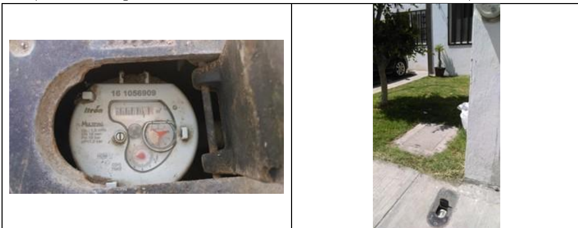
Figura 27. Medidor Itron, Multimag 161056909, clase C, sin VAF. Detalle de medidor con número de serie. Fracc. Las Canteras, municipio de Pedro Escobedo. Lectura del medidor: 79.242 m 3 . Se encontró que debe corregirse la marca (es Itron, no Itron-Actaris) en el padrón de usuarios. El medidor no tiene su tapa y está instalado en la banqueta. No se encontró a ninguna persona en el domicilio.
