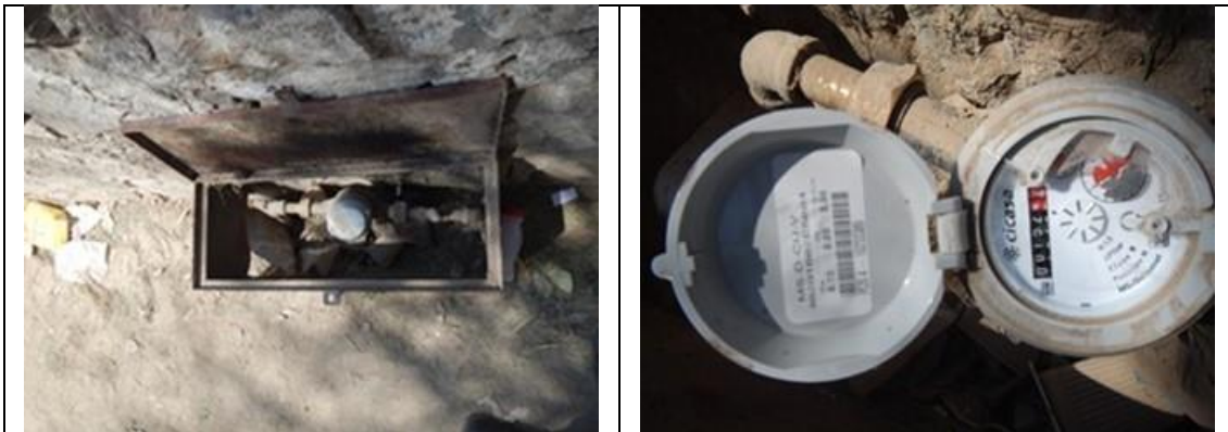
Figura 12. Medidor CICASA, MS Delaunet, 16233389, clase B, sin VAF. Cuadro de toma y detalle de medidor con número de serie. Centro de Salud de la Comunidad Epigmenio González, municipio de Pedro
