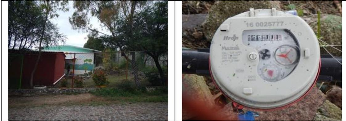
Figura 27. Medidor 160025777, clase C. Predio y detalle de medidor con número de serie. Sin VAF. Comunidad Santa Bárbara. Lectura del medidor: 91.13 m<sup>3</sup>.
