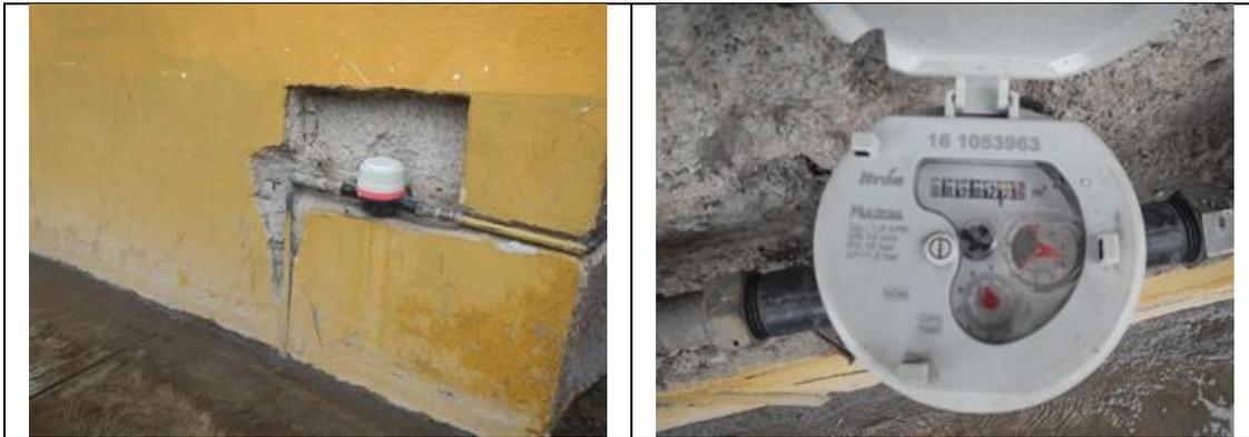
Figura 22. Medidor 161053963, clase C. Toma y detalle de medidor con número de serie. Sin VAF. Calle Morelos esq. 20 de Noviembre S/N, col. Centro, Cadereyta. Atendió la Sra. Ma. Luis Martínez González, titular del contrato, quien confirmó el cambio de medidor recientemente. Lectura del medidor: 202.22 m<sup>3</sup>.
