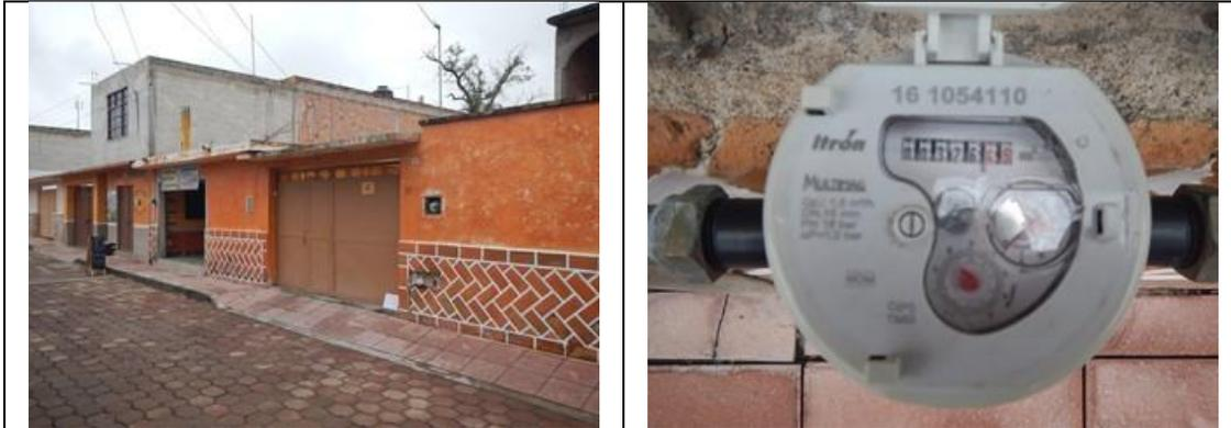
Figura 18. Medidor 161054110, clase C. Predio con toma y detalle de medidor con número de serie. Sin VAF. Calle Mina No. 8, col. Centro, Cadereyta. Atendió la persona de una lavandería existente en el predio y no quiso dar detalles de la toma. Lectura del medidor: 326.66 m<sup>3</sup>.
