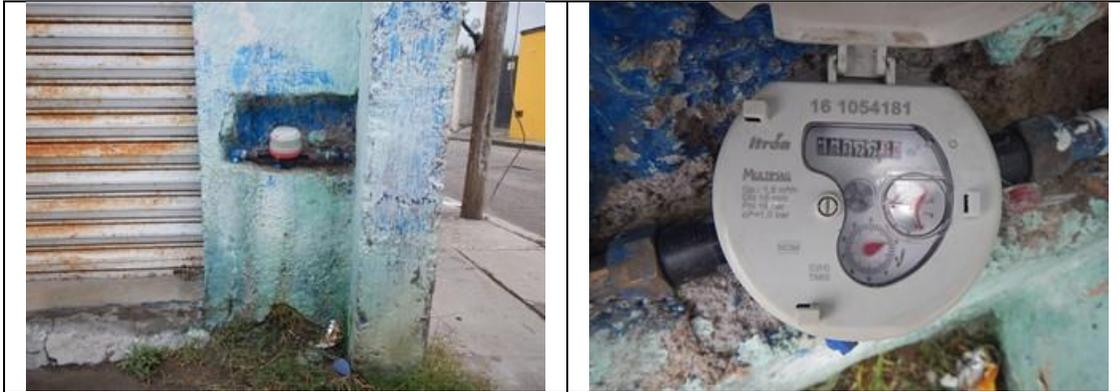
Figura 24. Medidor 161054181, clase C. Toma y detalle de medidor con número de serie. Sin VAF. Calle Magisterial S/N, col. Centro, Cadereyta. Lectura del medidor: 322.15 m<sup>3</sup>.
