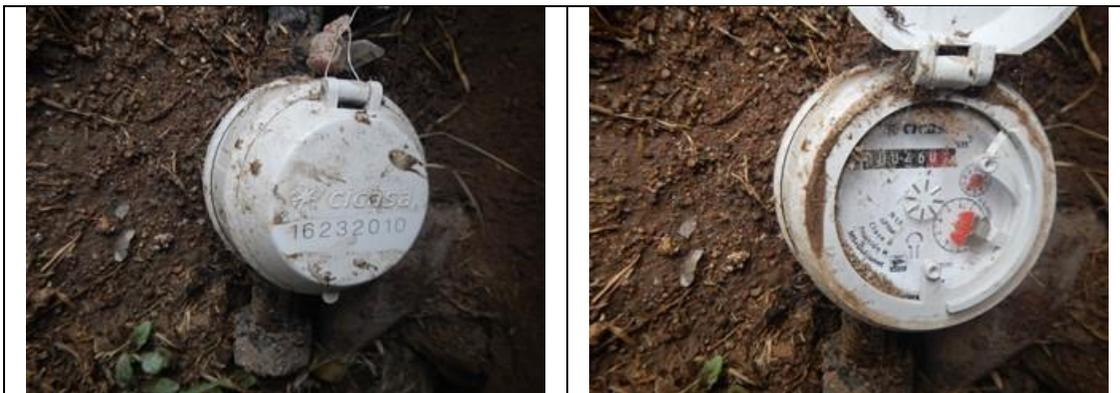
Figura 19. Medidor 16232010, clase B. Detalle de medidor con número de serie. Sin VAF. Calle Vicente Guerrero S/N, col. Centro, Cadereyta. Lectura del medidor: 26.00 m<sup>3</sup>.
