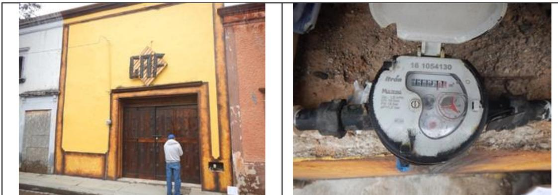
Figura 14. Medidor 161054130, clase C. Predio con toma y detalle de medidor con número de serie. Sin VAF. Calle Miguel Hidalgo S/N, col. Centro, Cadereyta. Lectura del medidor: 91.68 m<sup>3</sup>.
