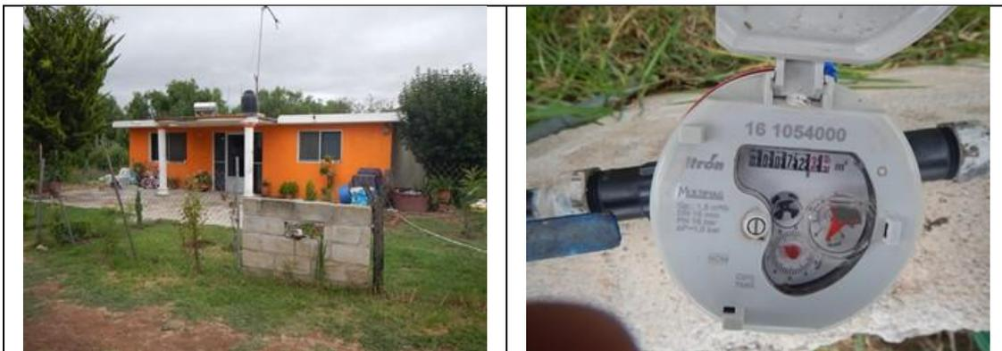
Figura 29. Medidor 161054000, clase C. Predio con toma y detalle de medidor con número de serie. Sin VAF. Calle Francisco Villa S/N, Barrio Los Vázquez. Lectura del medidor: 72.36 m<sup>3</sup>.
