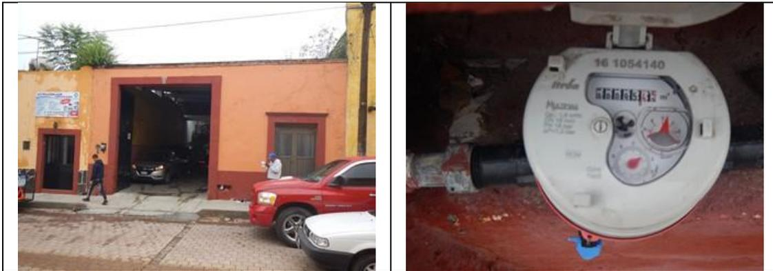
Figura 13. Medidor 161054140, clase C. Predio con toma y detalle de medidor con número de serie. Sin VAF. Calle Ignacio Zaragoza No. 5, col. Centro, Cadereyta. Lectura del medidor: 95.42 m<sup>3</sup>.
