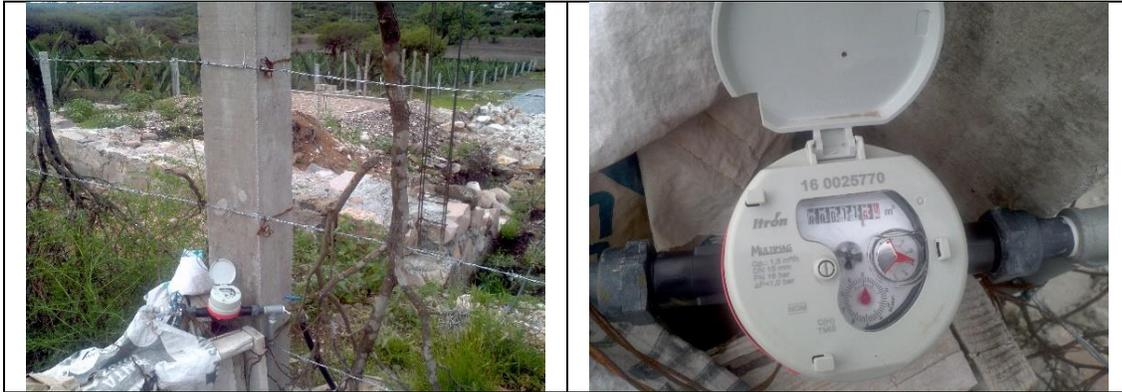
Figura 12. Medidor 160025770, clase C. Predio con toma y detalle de medidor con número de serie. Sin VAF. Comunidad El Palmar. Toma nueva en predio en construcción. Lectura del medidor: 11.6 m<sup>3</sup>.
