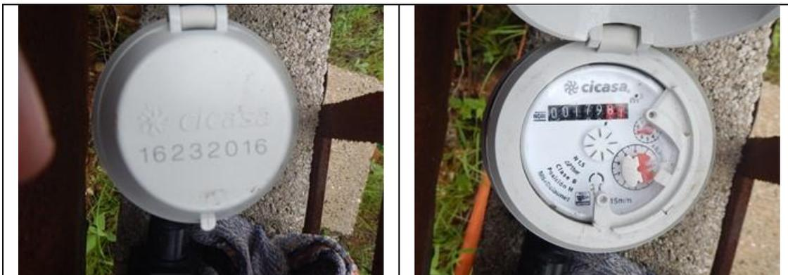
Figura 26. Medidor 16232016, clase B. Detalle de medidor con número de serie. Sin VAF. Comunidad Boyé. Lectura del medidor: 179.80 m<sup>3</sup>.
