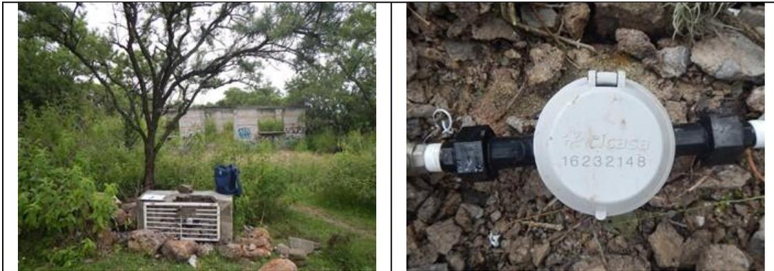
Figura 28. Medidor 16232148, clase B. Predio con toma y detalle de medidor con número de serie. Sin VAF. Comunidad Puerto de la Concepción. Lectura del medidor: 0.16 m<sup>3</sup>.
