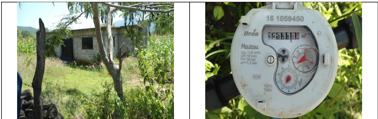
Figura 27. Medidor 161059450, clase C. Predio y detalle de medidor con número de serie. Con VAF. Barrio El Salto, localidad El Refugio. Lectura del medidor: 58.07 m 3 . El número de medidor corresponde con el
