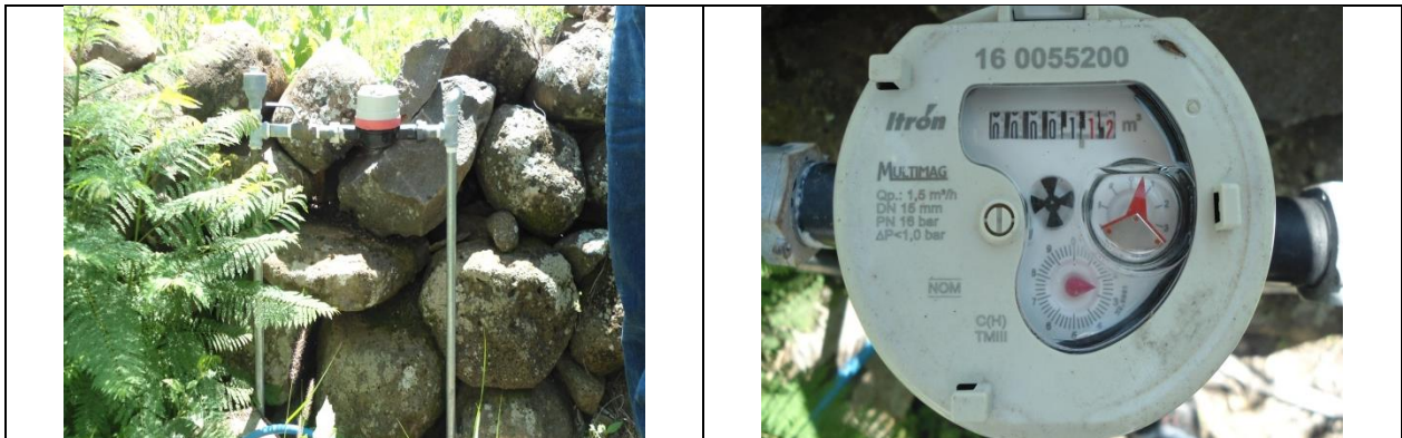
Figura 29. Medidor 160055200, clase C. Toma y detalle de medidor con número de serie. Con VAF. Calle Aldama No. 1, Barrio El Salto, localidad El Refugio. Lectura del medidor: 1.12 m 3 .
