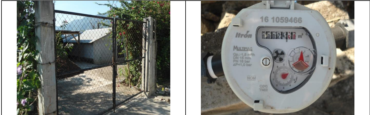
Figura 3. Medidor 161059466, clase C. Predio y detalle de medidor con número de serie. Con VAF. Calle Benito Juárez S/N, localidad El Crucero. Lectura del medidor: 24.50 m 3 . El número de medidor corresponde con el número proporcionado por la CEA, sin embargo la marca, modelo y características (clase) del medidor no corresponden a las registradas en el padrón de usuarios.
