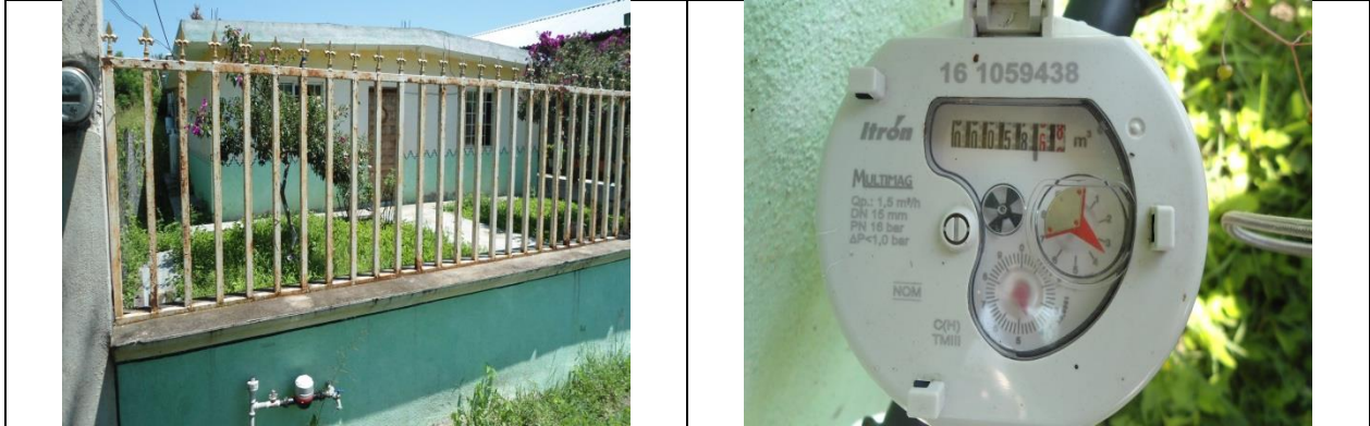
Figura 28. Medidor 161059438, clase C. Predio con toma y detalle de medidor con número de serie. Con VAF. Calle Altamira S/N, Barrio El Salto, localidad El Refugio. Lectura del medidor: 58.68 m 3 . El número de medidor corresponde con el número proporcionado por la CEA, sin embargo la marca, modelo y características (clase) del medidor no corresponden a las registradas en el padrón de usuarios.
