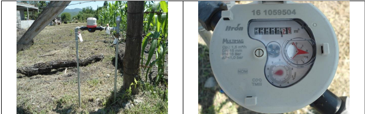
Figura 20. Medidor 161059504, clase C. Predio con toma y detalle de medidor con número de serie. Con VAF. Calle Andrés Balvanera S/N, localidad Arroyo Seco. Lectura del medidor: 0.25 m 3 . El número de medidor corresponde con el número proporcionado por la CEA, sin embargo la marca, modelo y características (clase) del medidor no corresponden a las registradas en el padrón de usuarios.
