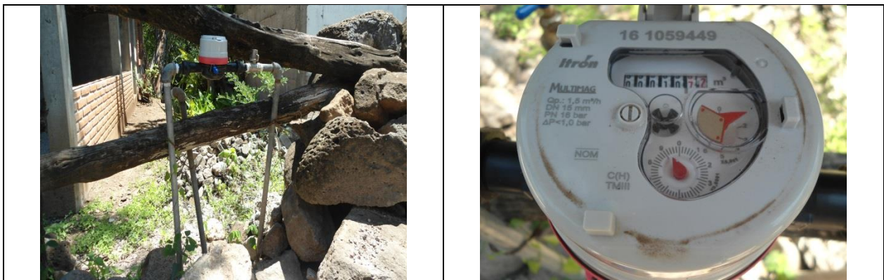
Figura 26. Medidor 161059449, clase C. Predio con toma y detalle de medidor con número de serie. Con VAF. Calle San Isidro S/N, Barrio Centro, localidad El Refugio. Lectura del medidor: 10.72 m 3 . El número de medidor corresponde con el número proporcionado por la CEA, sin embargo la marca, modelo y características (clase) del medidor no corresponden a las registradas en el padrón de usuarios.
