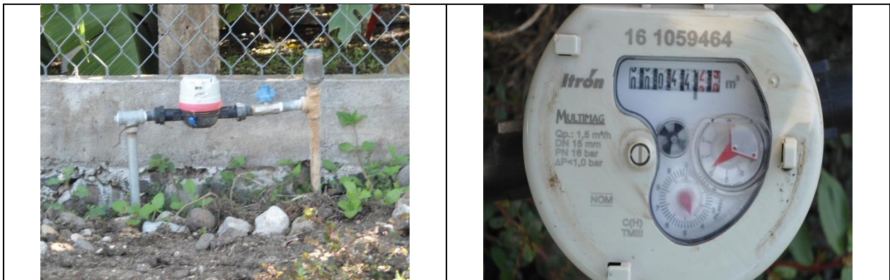
Figura 4. Medidor 161059464, clase C. Toma y detalle de medidor con número de serie. Con VAF. Carretera Federal Jalpan-Río Verde S/N, localidad El Crucero. Lectura del medidor: 44.29 m 3 . El número de medidor corresponde con el número proporcionado por la CEA, sin embargo la marca, modelo y características (clase) del medidor no corresponden a las registradas en el padrón de usuarios.
