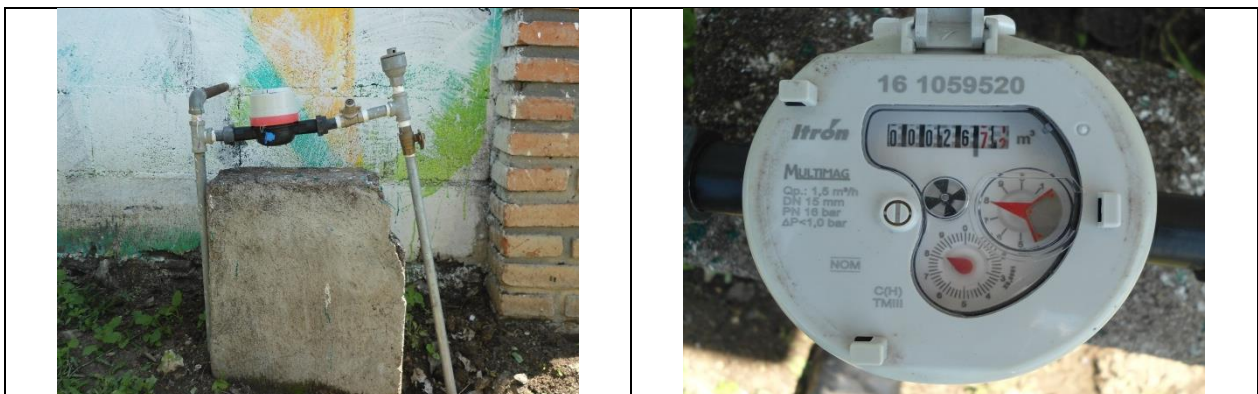
Figura 16. Medidor 161059520, clase C. Toma y detalle de medidor con número de serie. Con VAF. Carr. Federal Jalpan-Río Verde S/N, localidad Mesas de Agua Fría. Lectura del medidor: 26.71 m 3 . El número de
