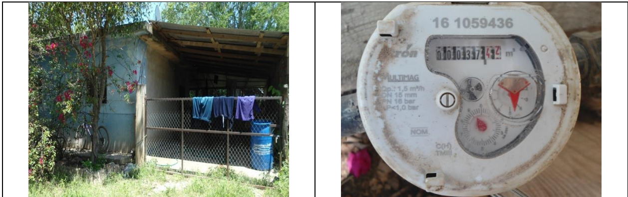
Figura 25. Medidor 161059436, clase C. Predio con toma y detalle de medidor con número de serie. Con VAF. Calle Altamira No. 36, Barrio Norte, localidad El Refugio. Lectura del medidor: 37.42 m 3 . El número de medidor corresponde con el número proporcionado por la CEA, sin embargo la marca, modelo y características (clase) del medidor no corresponden a las registradas en el padrón de usuarios.
