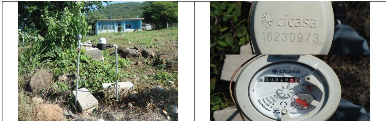
Figura 5. Medidor 16230973, clase B. Toma y detalles de medidor con número de serie. Con VAF. Carretera Federal Jalpan-Río Verde S/N, localidad El Crucero. Lectura del medidor: 28.63 m 3 . Se encontró que el modelo del medidor no corresponde al registrado en el padrón de usuarios de la CEA.
