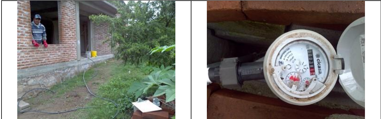
Figura 9. Medidor 16114435, clase B. Predio con toma y detalle de medidor con número de serie. Sin VAF. Dom. Conocido, localidad San Antonio la Labor. Predio en construcción. Toma nueva. Lectura del medidor: 38.1 m 3 . El recibo les llega con un comisionista.
