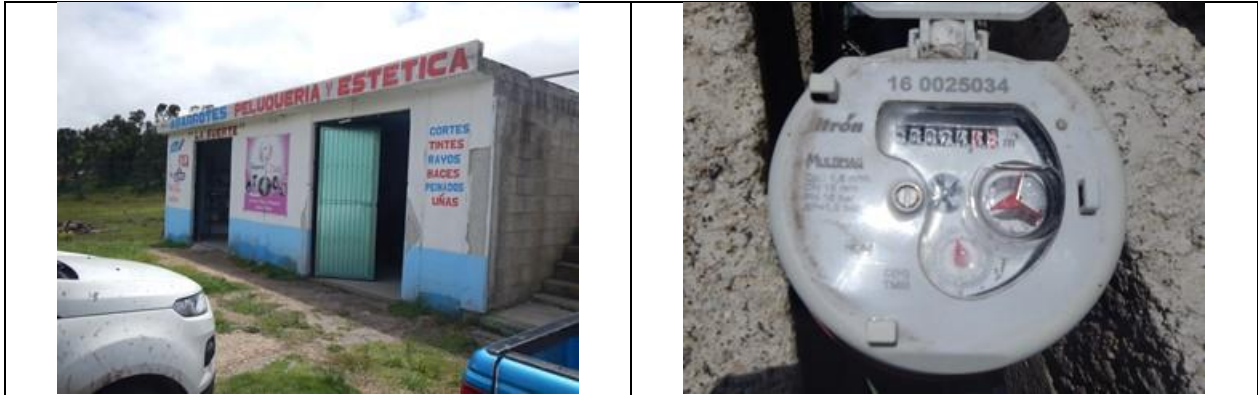
Figura 25. Medidor 160025034, clase C. Predio y detalle de medidor con número de serie. Sin VAF. Domicilio conocido, localidad Loma Linda. Las personas que se encontraron en el predio dijeron no conocer detalles de la toma o de fecha de instalación del medidor. Lectura del medidor: 24.42 m 3 .
