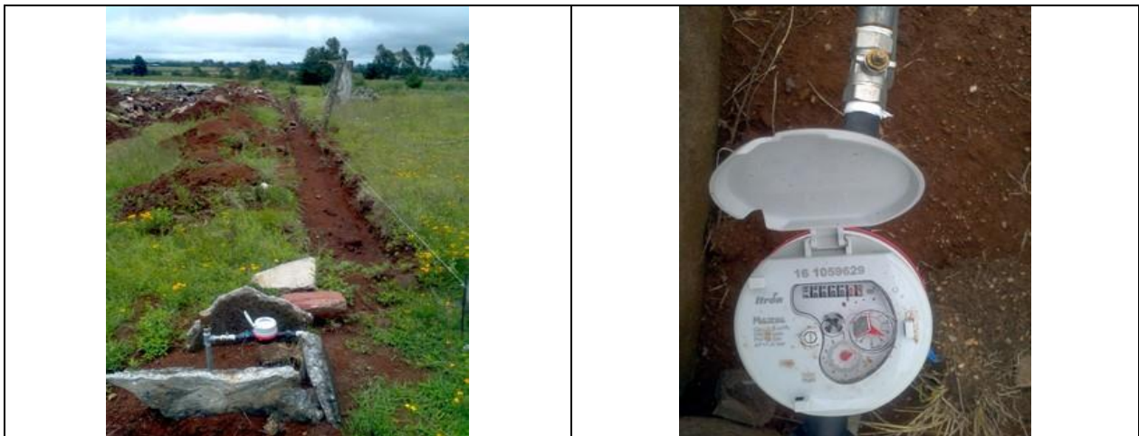
Figura 10. Medidor 16114377, clase B. Predio con toma y detalle de medidor con número de serie. Sin VAF. Dom. Conocido, localidad Hacienda Blanca. Toma nueva. Obra en terminación. Recibo con comisionista. Lectura del medidor: 25.71 m 3 .
