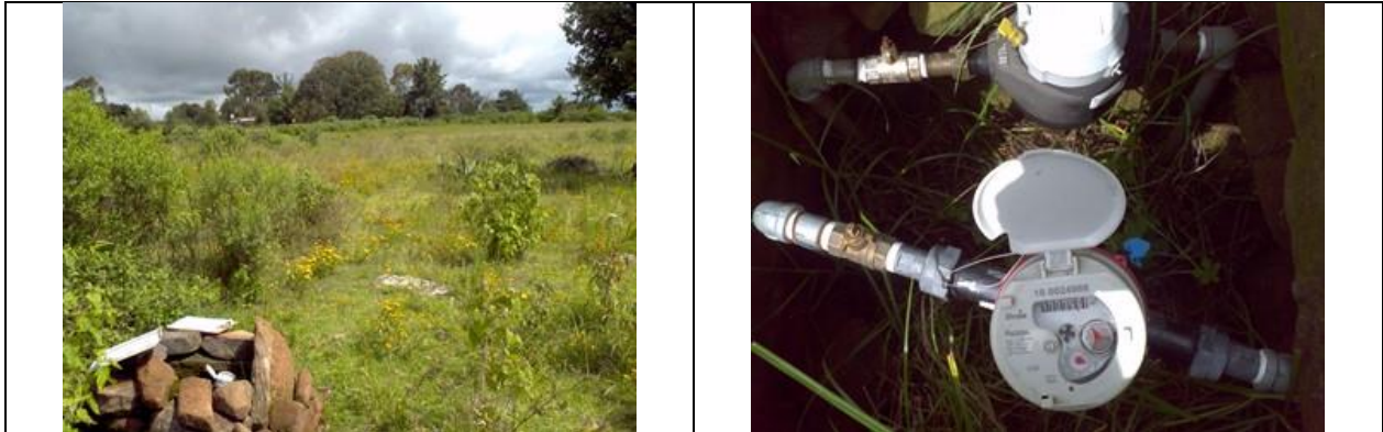
Figura 17. Medidor 160024988, clase C. Predio con toma y detalle de medidor con número de serie. Sin VAF. Dom. Conocido, localidad San José Ithó. Toma alejada del predio. Toma nueva. Recibo con comisionista. Lectura del medidor: 82.73 m 3 .
