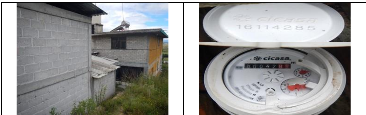
Figura 27. Medidor 16114285, clase B. Predio y detalle de medidor con número de serie. Sin VAF. Domicilio conocido, localidad Donica. No se encontró al usuario de la toma y no quedó claro a que vivienda abastece. Además, el acceso al medidor es complicado debido a que debe uno ingresar a terrenos particulares. Lectura del medidor: 42.88 m 3 .
