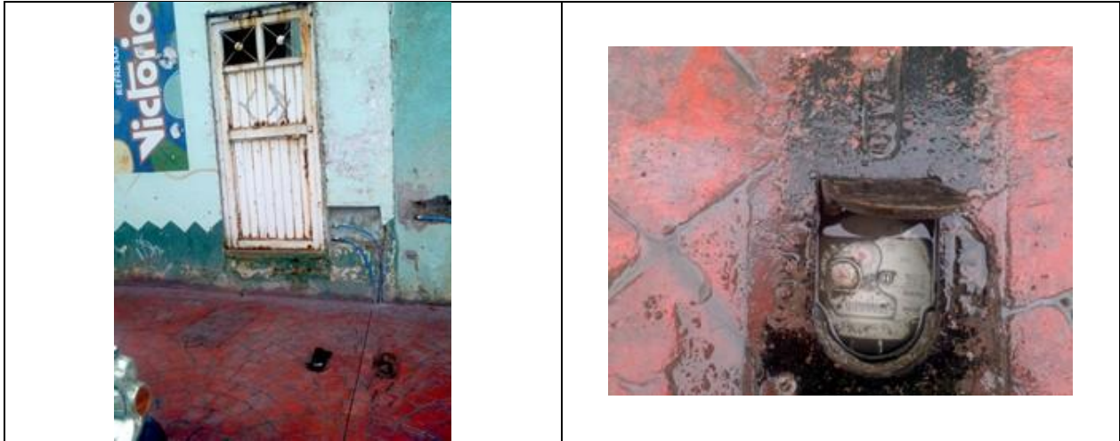
Figura 4. Medidor 161060065, clase C. Predio con toma y detalle de medidor con número de serie. No se aprecia si tiene VAF. Heroico Colegio Militar no. 285, col. Centro. Sustitución por reubicación de pared a banqueta, debido a reconstrucción de la vialidad. Indicó el lectorista que la casa está casi deshabitada. Lectura del medidor: 6.37 m 3 .
