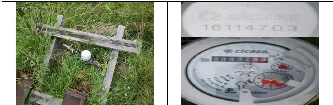
Figura 32. Medidor 16114703, clase B. Toma y detalle de medidor con número de serie. Sin VAF. Domicilio conocido, localidad El Capulín. Lectura de medidor: 32.83 m 3 .
