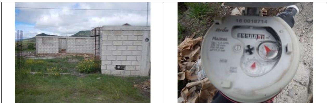
Figura 21. Medidor 160018714, clase C. Predio con toma y detalle de medidor con número de serie. Sin VAF. Domicilio conocido, localidad El Lindero. No se encontró en el domicilio al usuario. Se observó que se inició construcción de una casa, pero ahora se encuentran detenidas las obras. Lectura del medidor: 11.83 m 3 .
