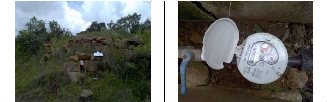
Figura 15. Medidor 161051954, clase C. Predio con toma y detalle de medidor con número de serie. Sin VAF. Dom. Conocido, localidad San Ildefonso Tultepec Sustitución por medidor roto (lecturista). Toma alejada del predio en campo. Recibo con comisionista. Lectura del medidor: 23.5 m 3 .
