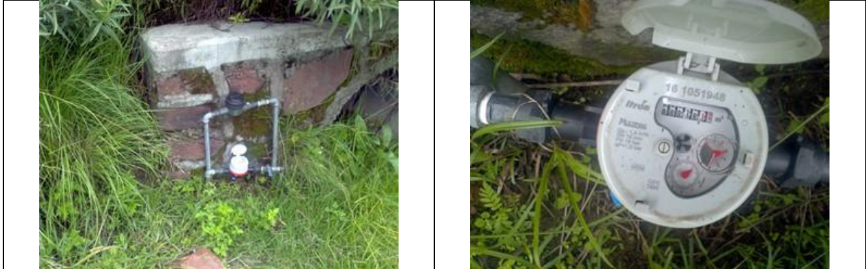
Figura 12. Medidor 161051948, clase C. Predio con toma y detalle de medidor con número de serie. Sin VAF. Localidad El Bothe. Toma entre plantación de maíz. Reemplazo por medidor anterior parado (lecturista). Difícil ubicar predio. Recibo con comisionista. Lectura del medidor: 19.10 m 3 .
