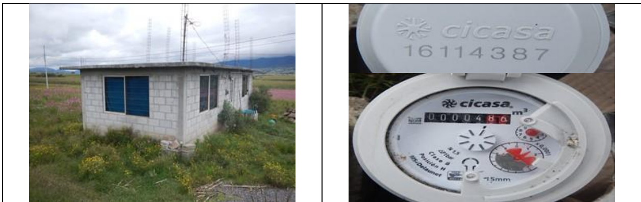
Figura 30. Medidor 16114387, clase B. Predio con toma y detalle de medidor con número de serie. Sin VAF. Domicilio conocido, Barrio 6to., localidad Santiago Mexquititlán. Lectura de medidor: 4.86 m 3 .
