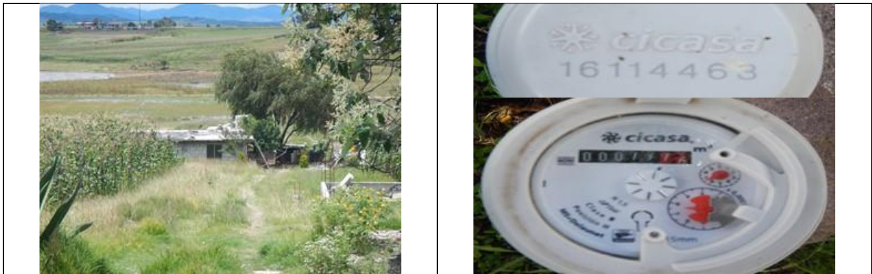
Figura 26. Medidor 16114463, clase B. Predio y detalle de medidor con número de serie. Sin VAF. Domicilio conocido, Barrio 4to., localidad Santiago Mexquititlán. Lectura de medidor: 77.75 m 3 .
