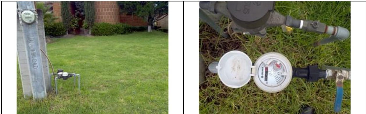
Figura 13. Medidor 16114260, clase B. Predio con toma y detalle de carátula de medidor. Sin VAF. Dom. Conocido, localidad San Ildefonso Tultepec. Sustitución por medidor parado. No estaba el usuario. No es claro el predio al que pertenece. Recibo con comisionista. Lectura del medidor: 137.81 m 3 .
