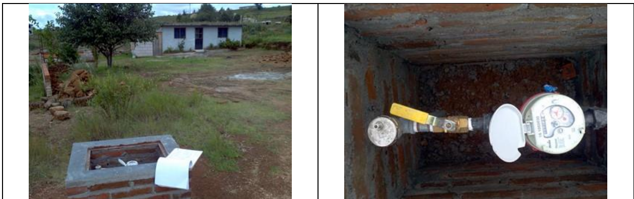
Figura 13. Medidor 16114260, clase B. Predio con toma y detalle de carátula de medidor. Sin VAF. Dom. Conocido, localidad San Ildefonso Tultepec. Sustitución por medidor parado. No estaba el usuario. No es claro el predio al que pertenece. Recibo con comisionista. Lectura del medidor: 137.81 m 3 .
