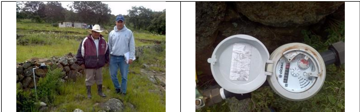
Figura 7. Medidor 16114295, clase B. Predio con toma y detalle de carátula de medidor. Sin VAF. Dom. Conocido, ejido San. Juan Dehedo. Toma nueva. Usuario manifestó que el servicio es continuo. Lectura del medidor: 37.4 m 3 .
