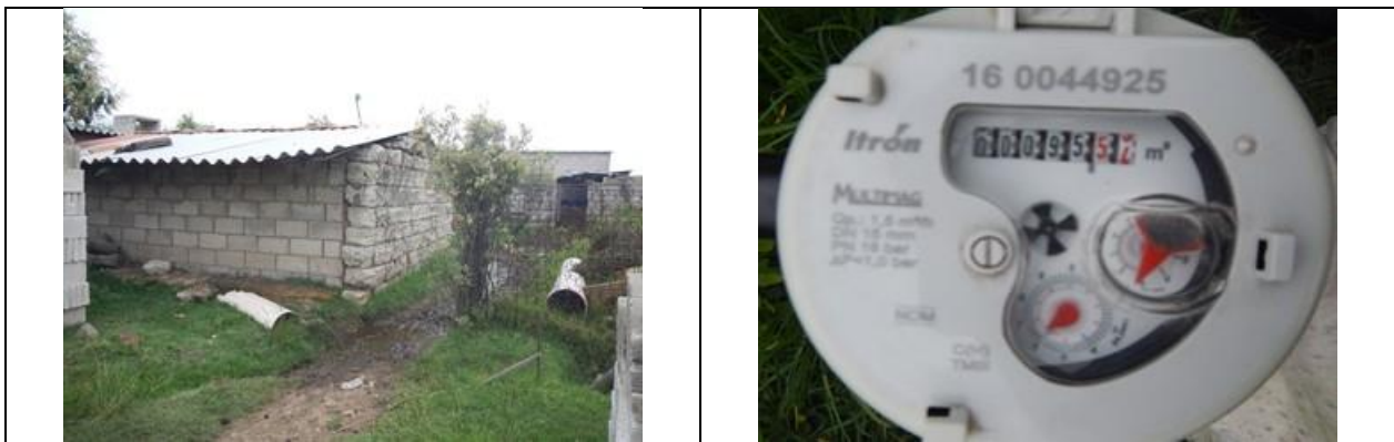
Figura 29. Medidor 160044925, clase C. Predio y detalle de medidor con número de serie. Sin VAF. Domicilio conocido, Barrio 6to., localidad Santiago Mexquititlán. Lectura del medidor: 95.53 m 3 .
