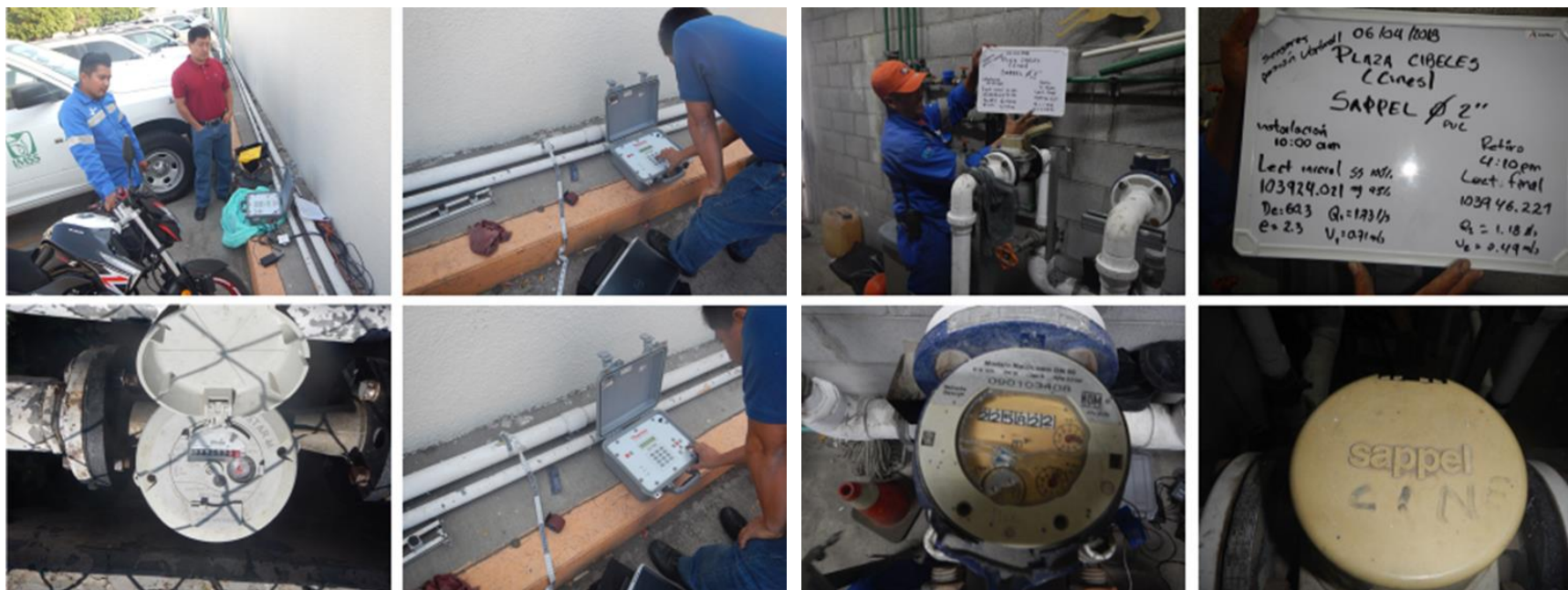
Ilustración 13. Auditoria a medidores (diámetro >25mm)
