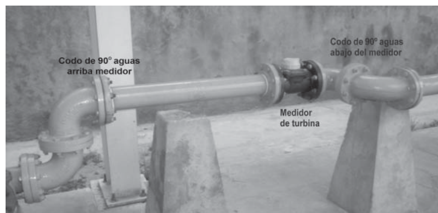
Figura 2. Vista del tramo de pruebas.
