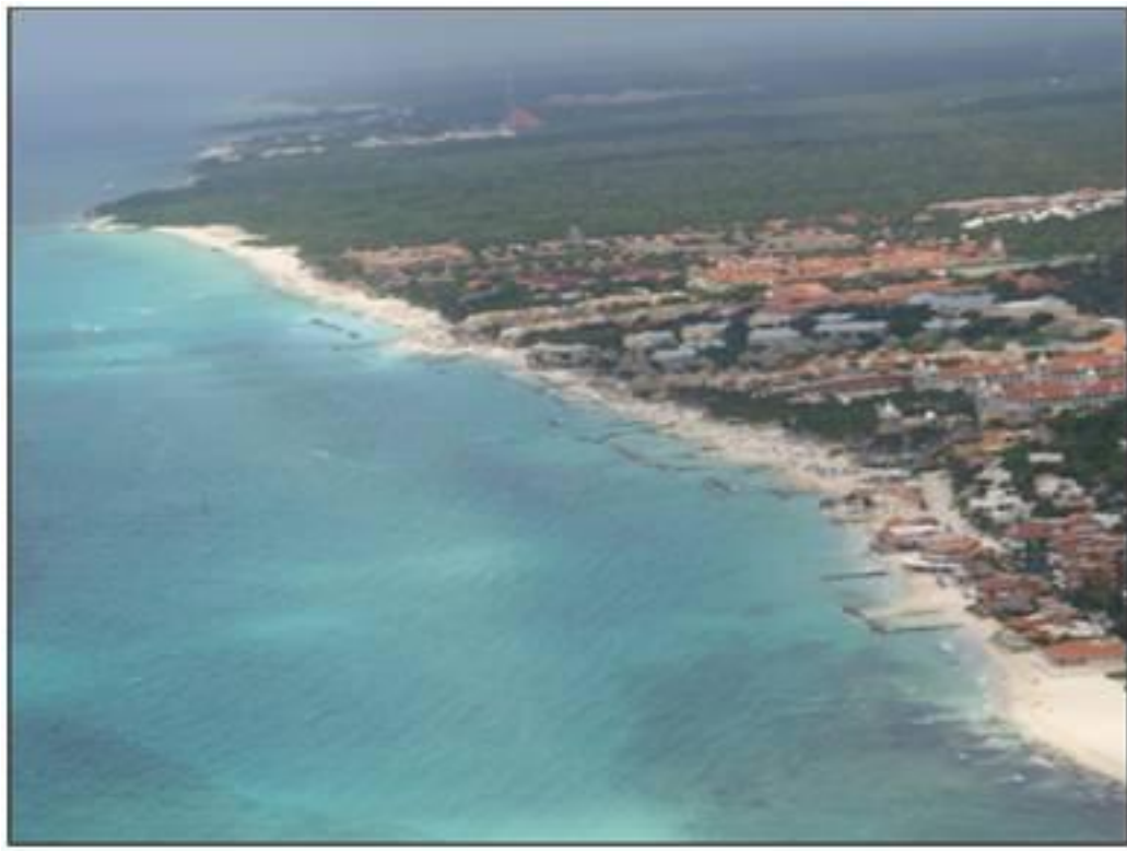
Figura 8. Estructuras de protección (geotubos) instalados de manera indiscriminada en Playa del Carmen
