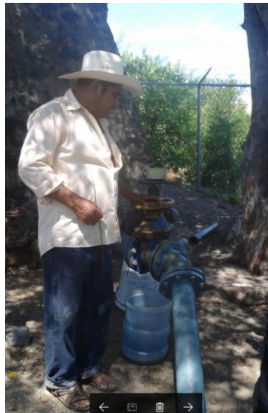
Figura 4-2 Fotografías del cárcamo de bombeo de Xicatlacotla
