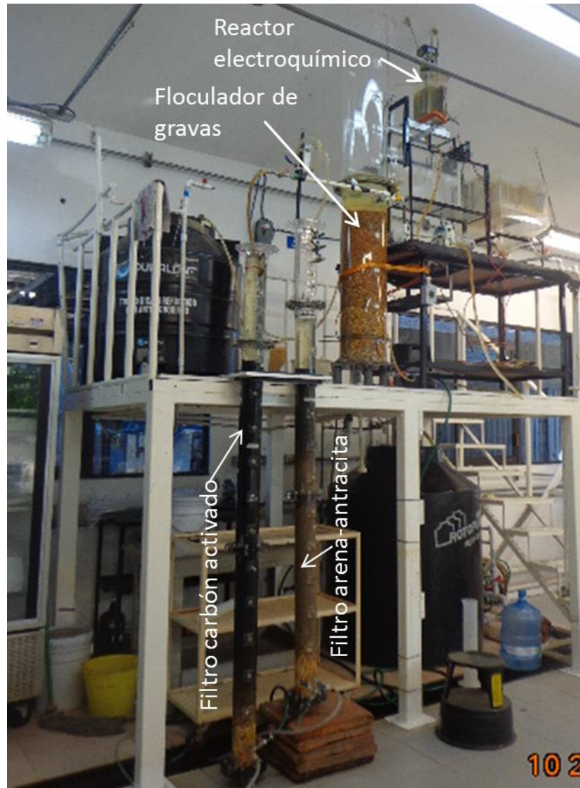
Figura 6-1 Fotografía de la planta semipiloto para remover arsénico.
