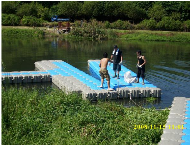
Figura 1.1.36 Ensamblaje de los módulos.
