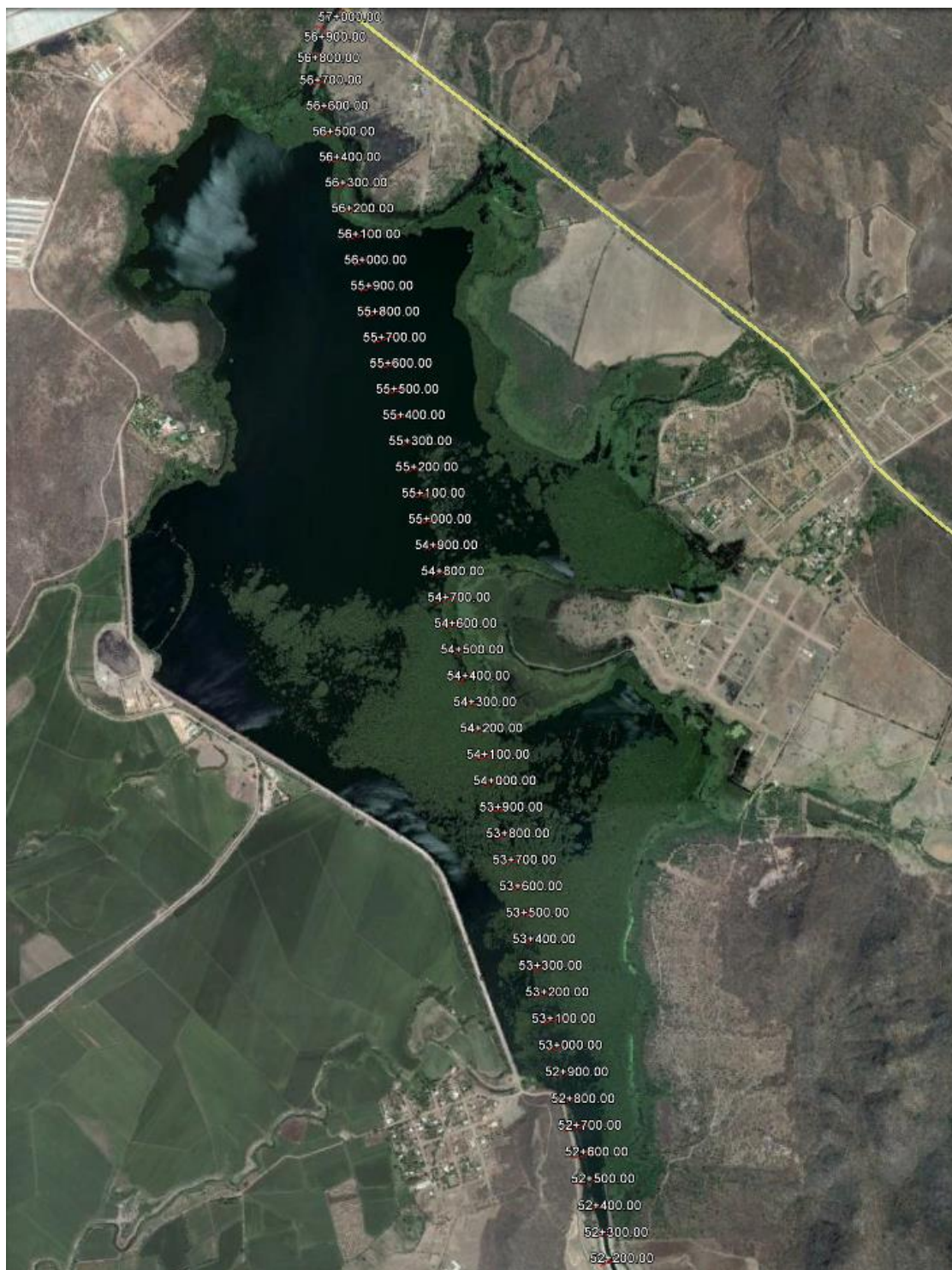
Figura 1.1.3 Dique Mariquita en los cadenamientos km 52+317 al km 56+860 del canal Principal Humaya.
