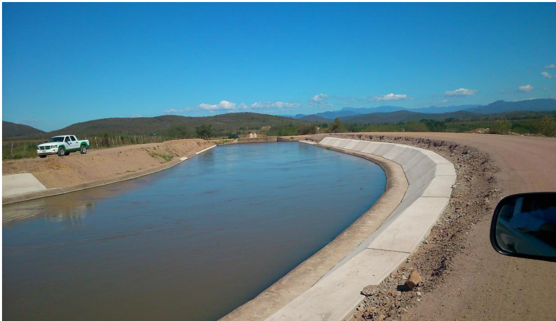
Figura 3.14 El Canal Humaya en proceso de sobreelevación.
