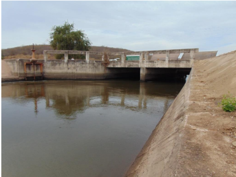
Figura 2.15 Vista general de la represa Km 50+308 del CPH.
