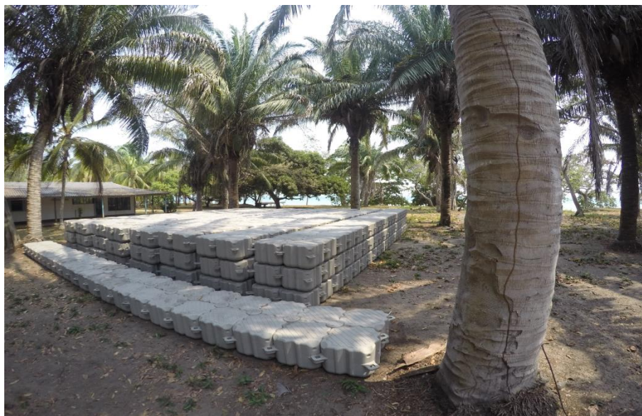
Figura 1.1.35 Organizar los módulos preensamblados.
