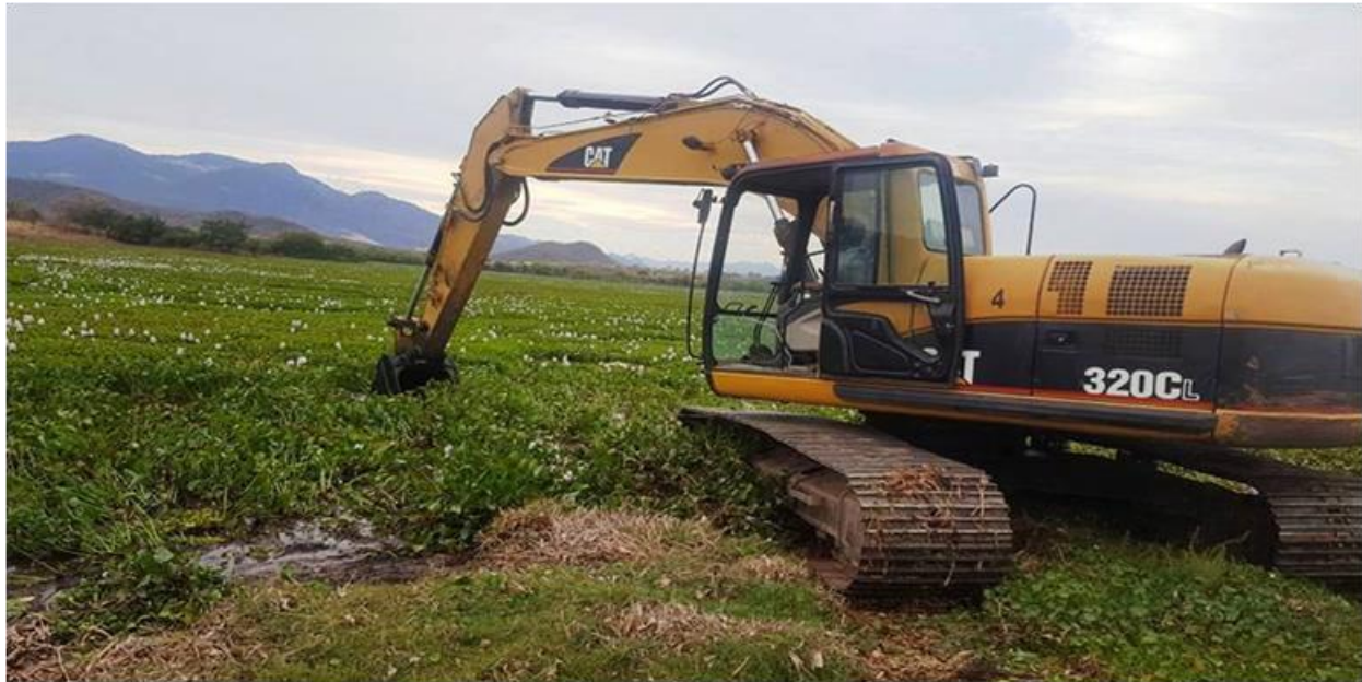
Figura 1.2.21 Extracción mecánica del lirio en un la Presa Hermenegildo Galena con excavadora de brazo largo.
