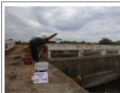
VISTA DE LA EXTRACCION DEL CORAZON DE CONCRETO HIDRAULICO
