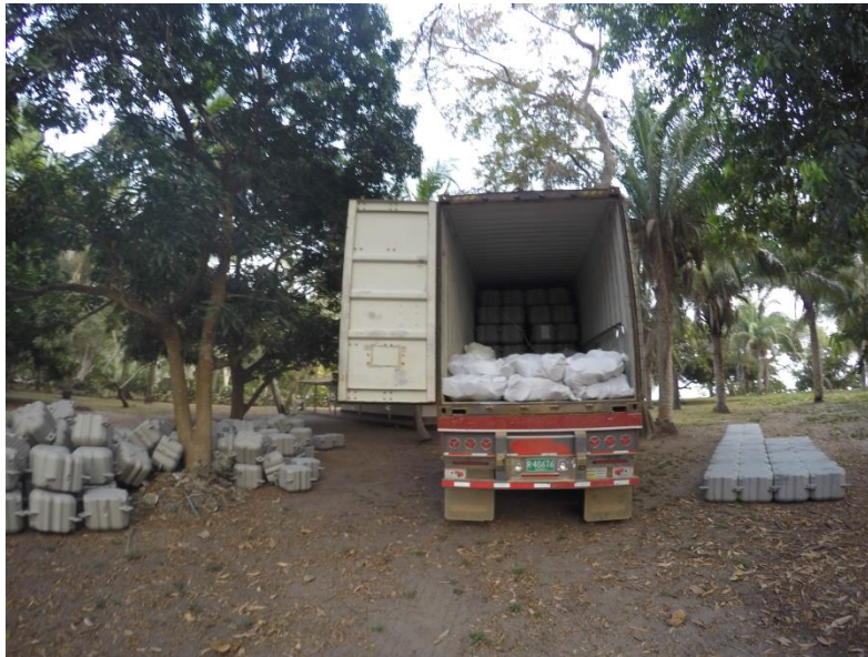
Figura 1.1.34 Descarga de los módulos y partes, en un lugar plano.
