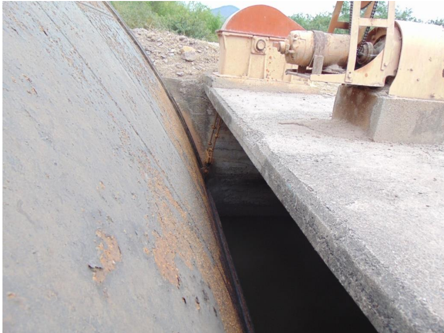
Figura 2.18 Deterioro en concreto.
