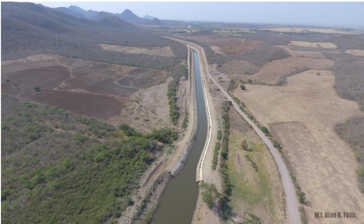
Figura 1.2.12 Estado actual del dique infestado por lirio acuático en la entrada del vaso.
