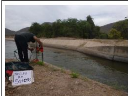
VISTA DE LA EXTRACCION DEL CORAZON DE CONCRETO HIDRAULICO
