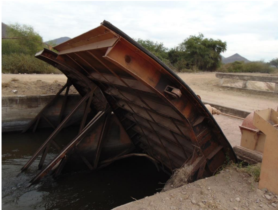
Figura 2.14 Imagen de la represa del Km 50+308 del CPH.
