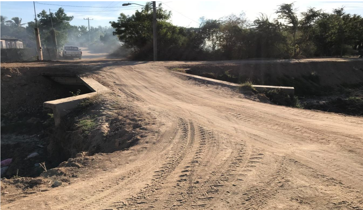
Figura 3.A.9 Puente de acceso principal al pueblo “El Mojolo” que cruza la entrada de agua al Dique que se forma con el bordo del canal principal Humaya formando.
