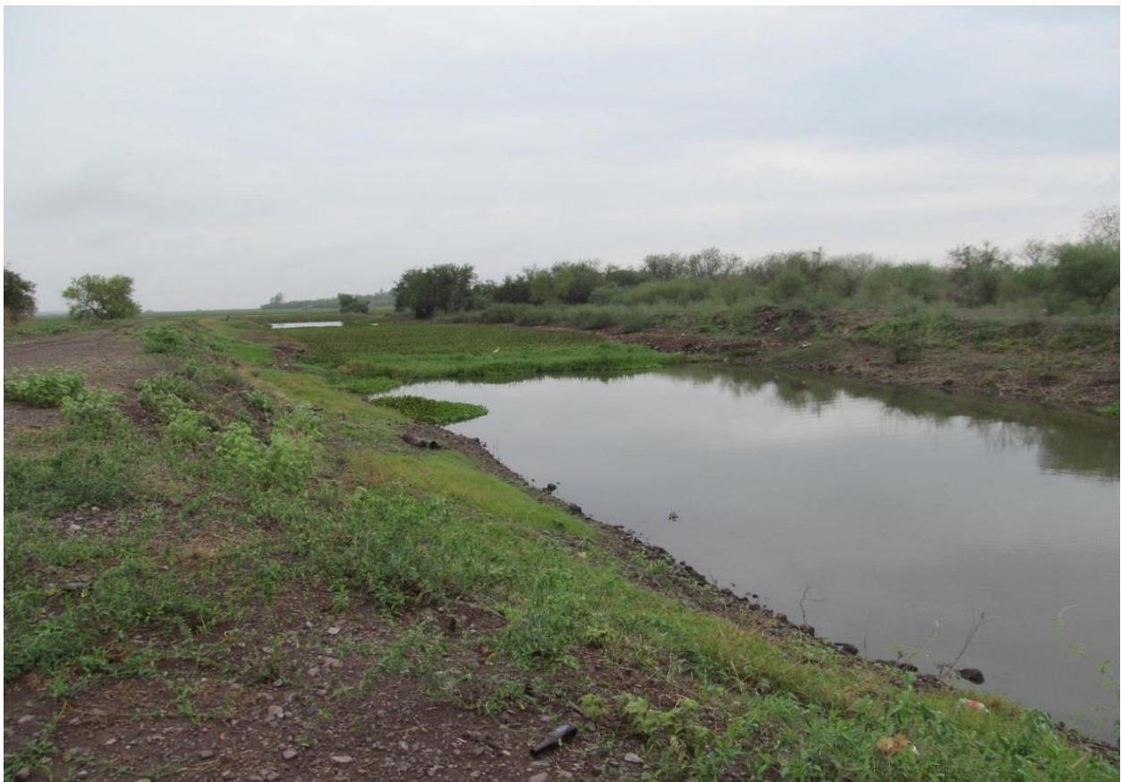
Figura 1.2.4 Tapón de lirio acuático en la salida del Dique Mariquita en el km 56+340 al km 56+420 en su margen izquierda mismo que provoca el remanso aguas arriba.
