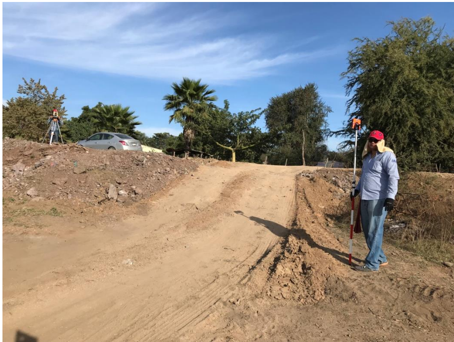
Figura 3.A.14 Levantamiento de niveles y secciones en el Dique El Mojolo.
