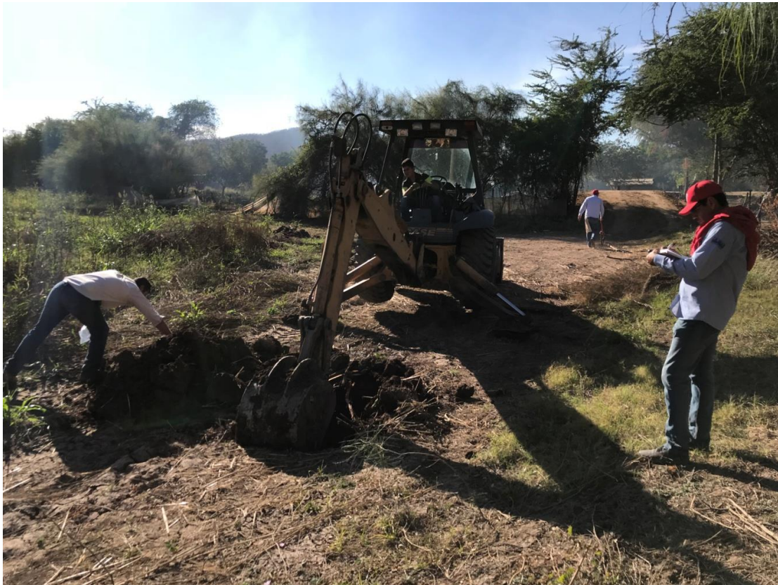
Figura 3.A.22 Sondeo Número 1 en el Dique El Mojolo.
