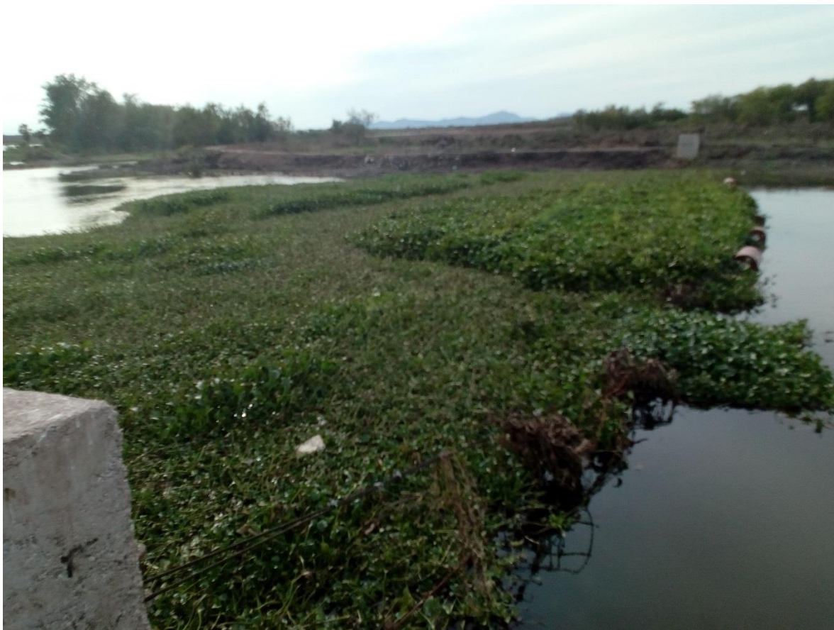
Figura 1.1.13 Retenida actual en la transición actual del Dique Mariquita.
