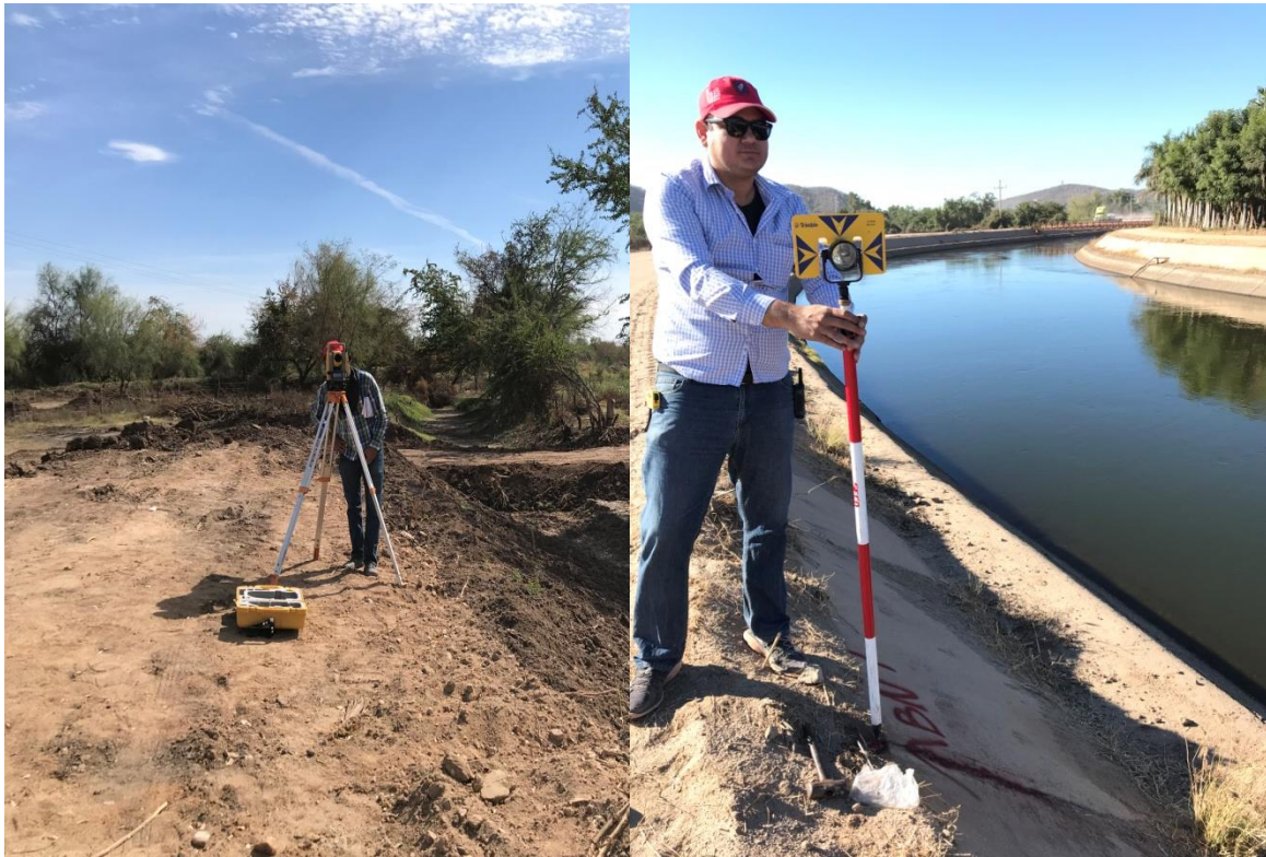
Figura 3.A.13 Levantamiento de niveles y secciones en el Dique El Mojolo.
