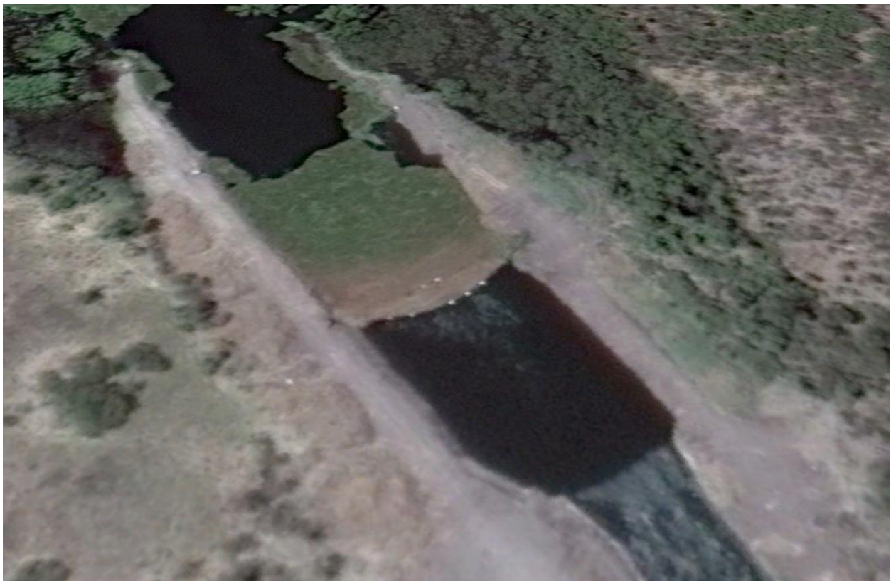
Figura 1.2.9 Retenida actual en la transición actual del Dique Mariquita.
