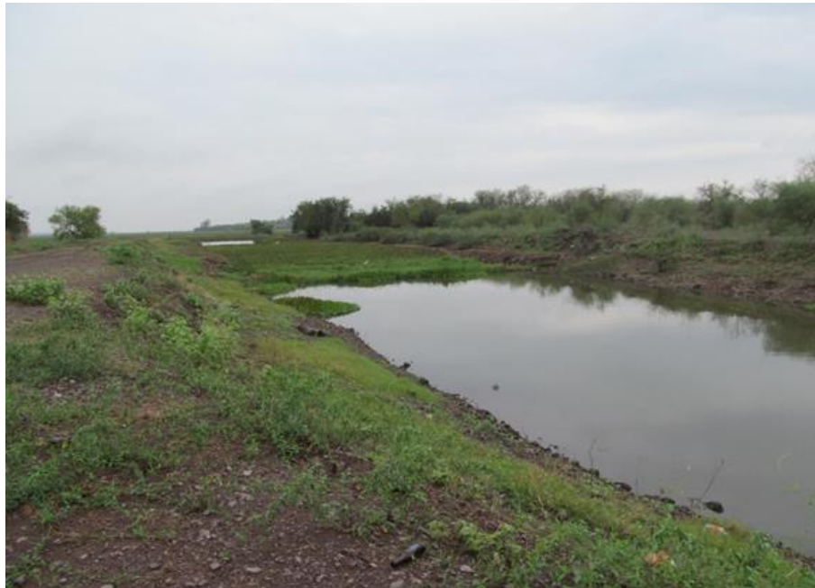
Figura 1.1.7 Tapón de lirio acuático en la salida del Dique Mariquita en el km 56+340 al km 56+420 en su margen izquierda mismo que provoca el remanso aguas arriba.
