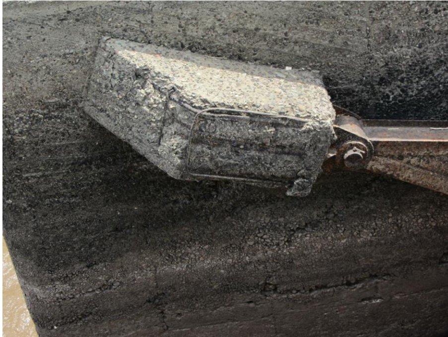
Figura 2.2 Exposición de acero de refuerzo en ménsula.
