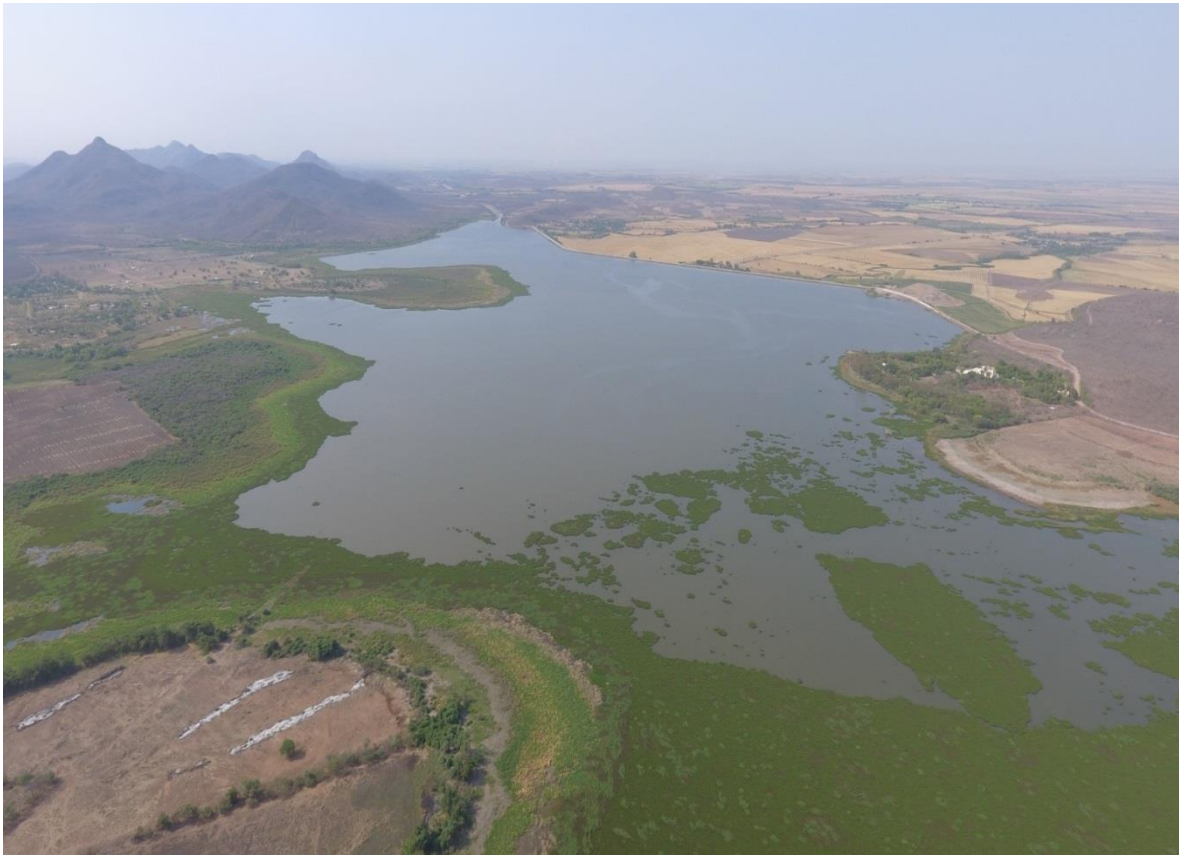
Figura 1.2.10 Estado actual del dique infestado por lirio acuático al centro del vaso.
