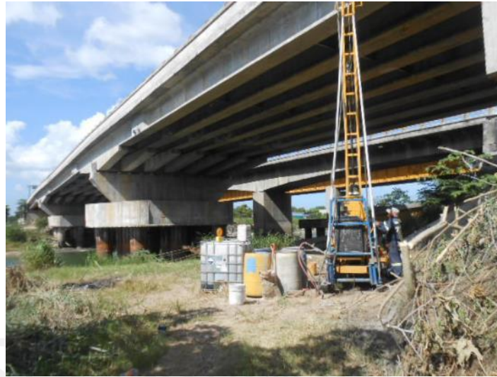
Figura 4.2. Sondeo de penetración estándar SPT-1.
