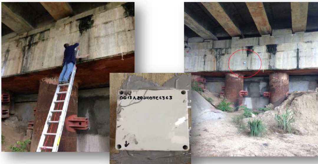
Figura 8.12. Instalación del sensor "inclinómetro" en el estribo de margen derecha.
