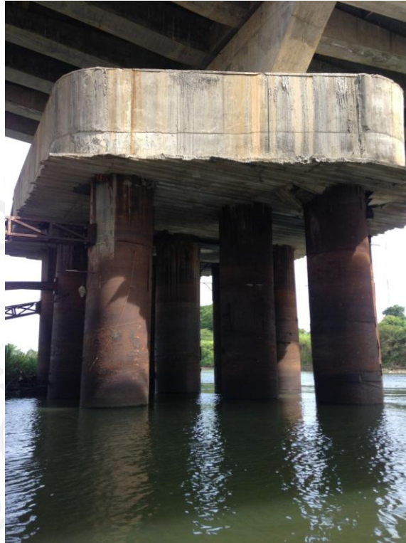
Figura 8.7. Pila del puente centro margen derecha.
