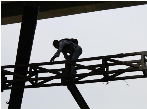
Figura 8.10. Maniobras para instalación del TDA sobre la plataforma de la pila del puente Pigua III, centro, margen derecha.
