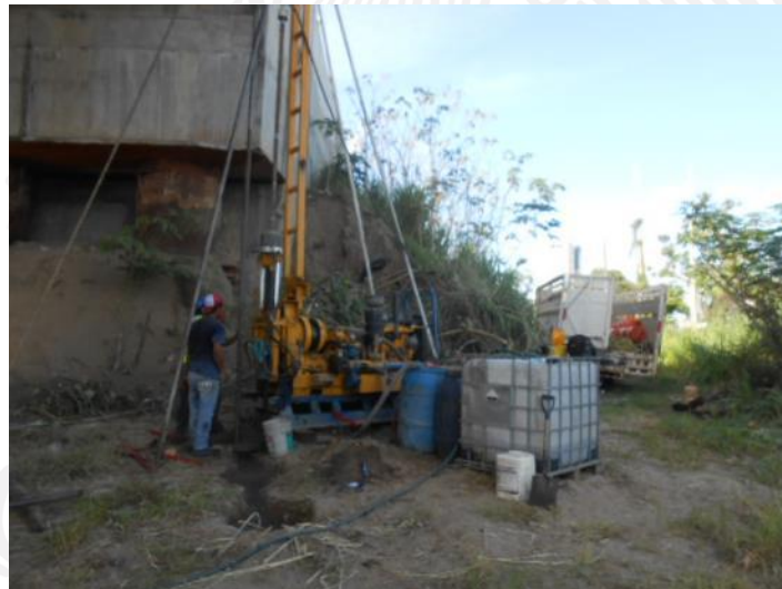
Figura 4.3. Sondeo de penetración estándar SPT-1.
