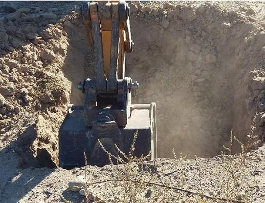
**Fotografía III.22** Excavación del PCA-6, en el terreno de cimentación, lado derecho.
