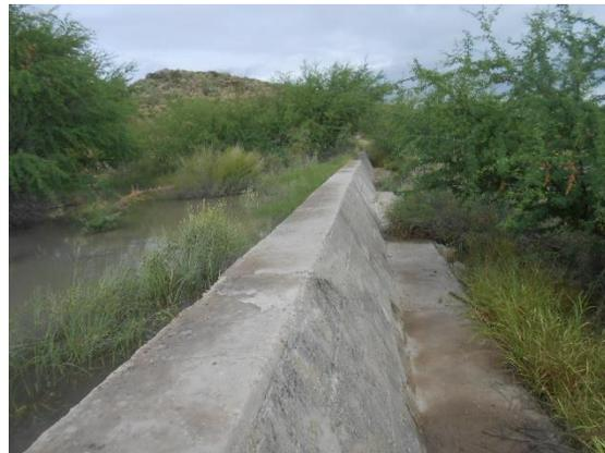
**Fotografía II.43 Muro de concreto al frente del tanque de amortiguamiento.**
