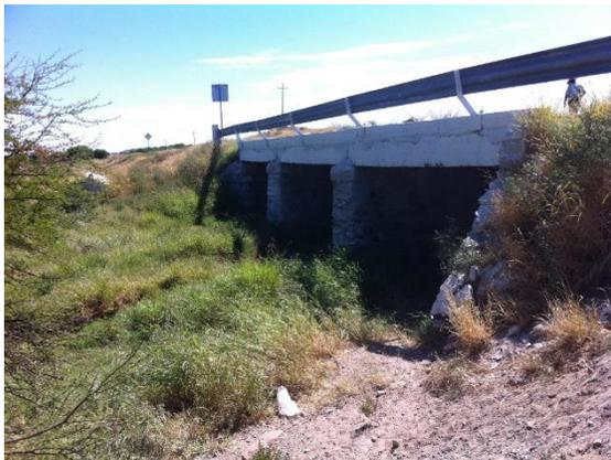
**Fotografía III.10 Alcantarilla bajo la carretera federal 40, cadenamiento 1+227.**
