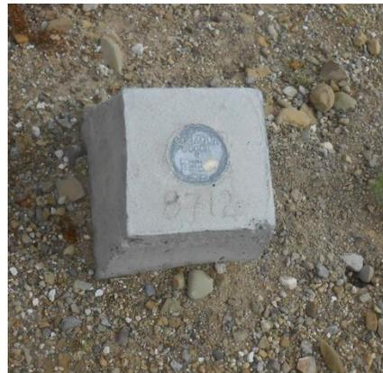
**Fotografía II.13 Detalle del testigo topográfico sobre la corona.**
