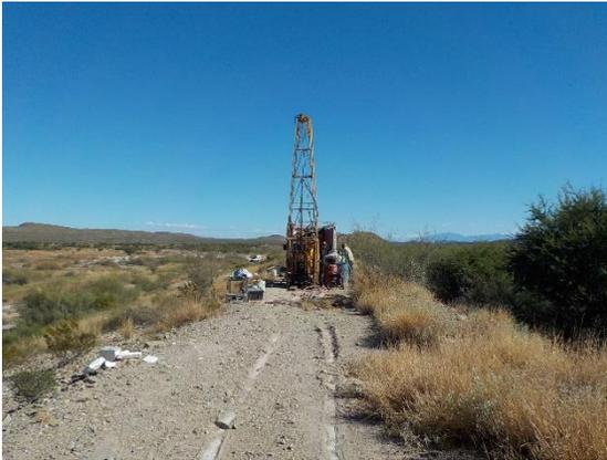
**Fotografía III.26 Perforación del SPT-2 en el lado derecho de la cortina.**
