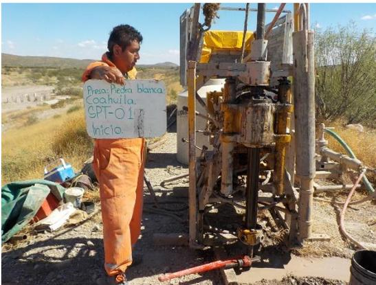
**Fotografía III.24** Perforación del SPT-01 en la sección central de la cortina.
