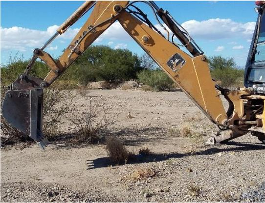
**Fotografía III.20** Excavación del PCA-5, en el terreno de cimentación, lado izquierdo.
