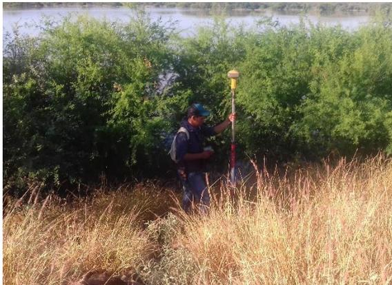
**Fotografía III.6 Levantamiento topográfico del talud aguas arriba.**
