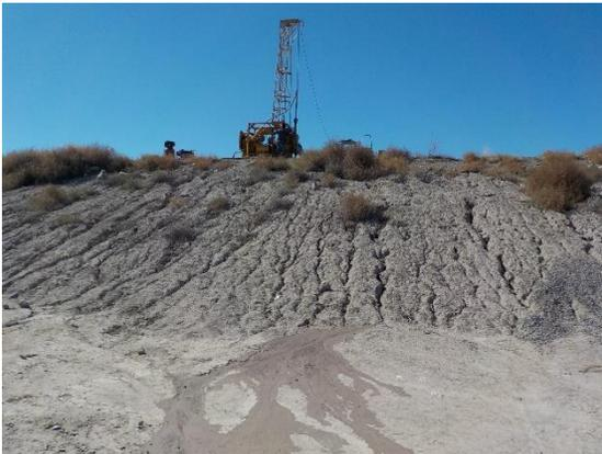
**Fotografía III.28 Perforación del SPT-3 en la zona de la falla.**
