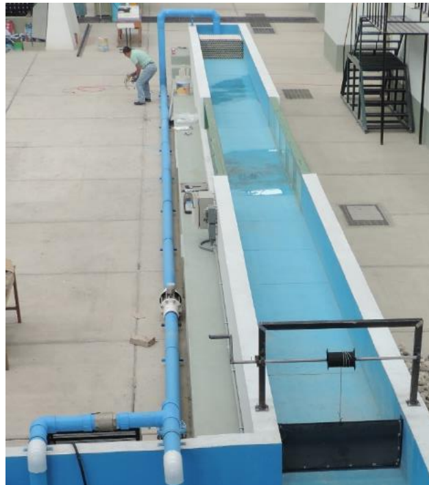
Figura III-11 Instalación de la línea de conducción con tubería de PVC de 6".
