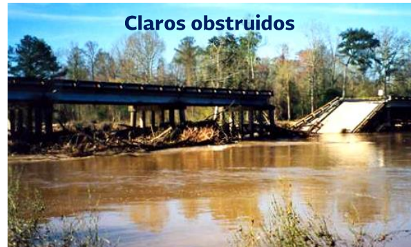
Figura I-5 Ejemplos de acumulación de material leñoso en una pila y entre pilas.
