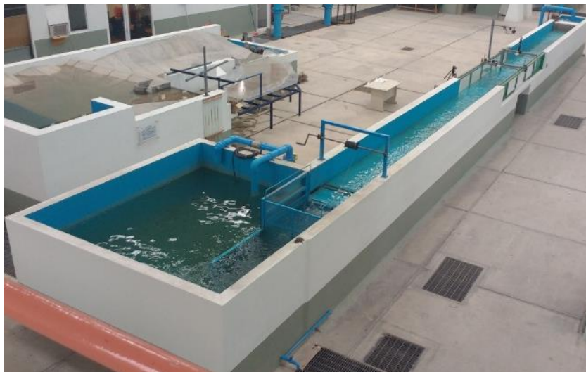
Figura III-12 Canal de pendiente nula terminado y operando.
