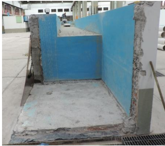
Figura III-4 Demolición de muros existentes.
