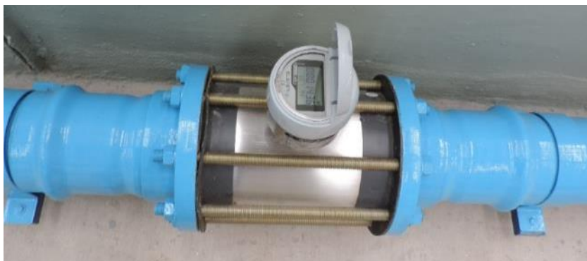
Figura III-13 Instalación de medidor de flujo.
