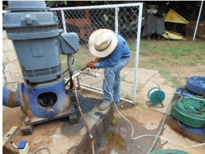
Figura 4.5 Medición de los niveles de bombeo con sonda eléctrica
