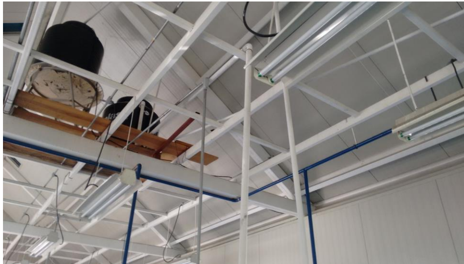
Ilustración 32 Tinacos de 450 litros cada uno, instalados a una altura de seis metros de altura.
