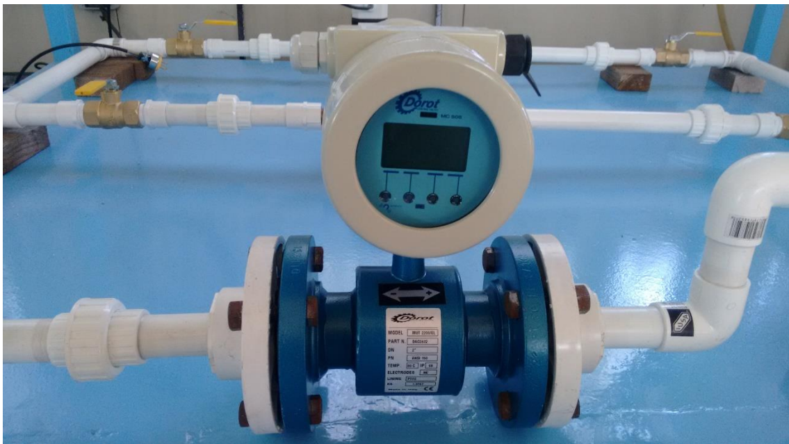
Ilustración 40. Medidor electromagnético Dorot de 2".
