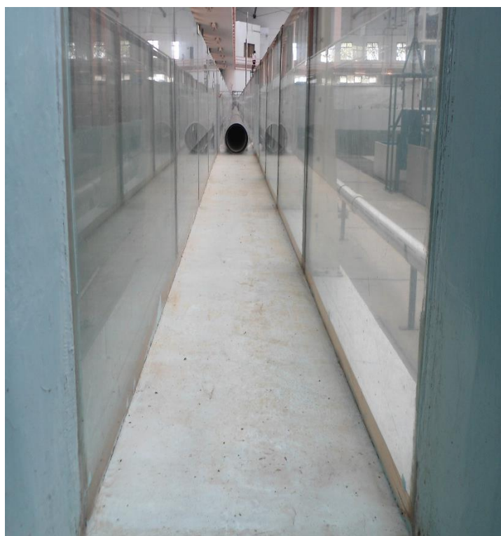
Ilustración 2.33. Ubicación de la estructura de transición de flujo en el canal: vista desde el inicio del canal.
