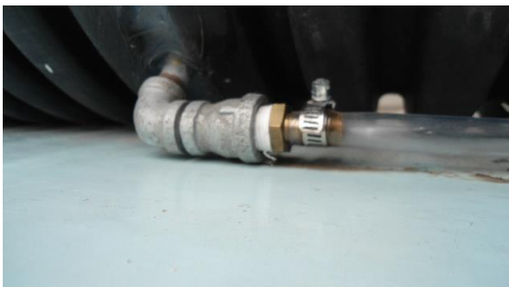
Ilustración 2.46. Conexión de la tubería de prueba a la manguera flexible que transmite la presión a los tubos piezométricos y celdas de presión: detalle de la conexión.
