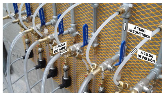
Ilustración 2.45. Celdas de presión instaladas para pruebas en tuberías con flujo a superficie libre: vista de detalle de conexiones y derivaciones.
