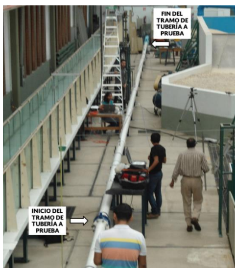
Ilustración 2.10. Vista de la tubería de PVC probada con flujo a presión.
