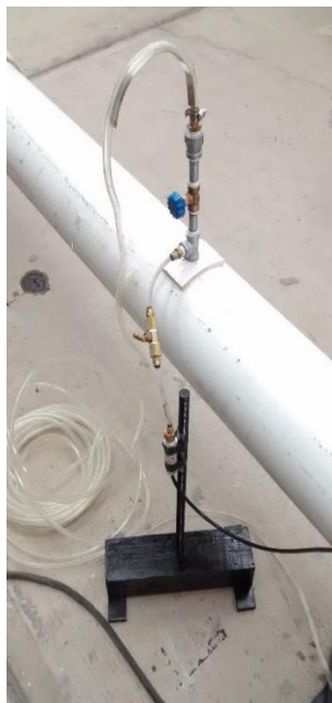
Ilustración 2.24. Tomas de cargas de presión en tubería de PVC.
