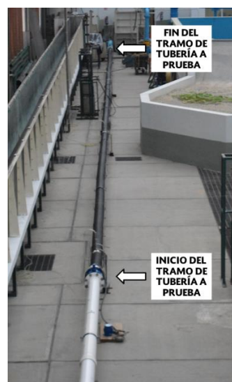
Ilustración 2.11. Vista de la tubería de polietileno probada con flujo a presión.
