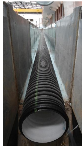
Ilustración 2.37. Tramo de tubería de polietileno (12 pulgadas) instalada: vista desde la descarga.
