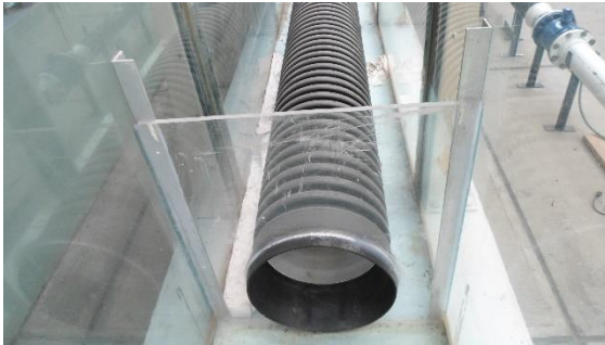
Ilustración 2.34. Estructura de transición: vista general donde se aprecia el sellado.
