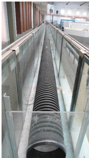
Ilustración 2.36. Tramo de tubería de polietileno (12 pulgadas) instalada: vista desde la estructura de transición.
