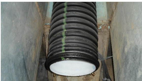
Ilustración 2.38. Descarga del tramo de tubería de polietileno (12 pulgadas): vista general.
