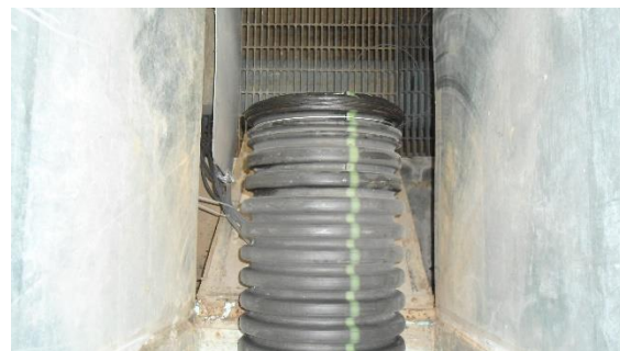
Ilustración 2.39. Descarga del tramo de tubería de polietileno (12 pulgadas): vista superior.
