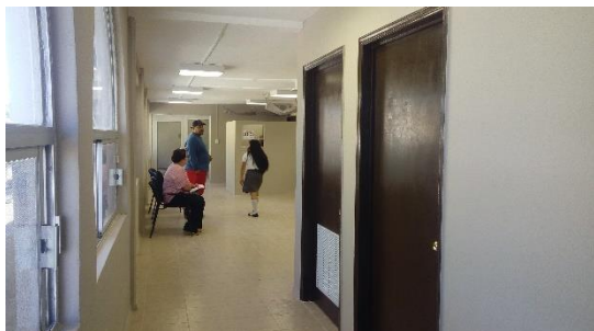
Ilustración 44. Remodelación de oficinas.
