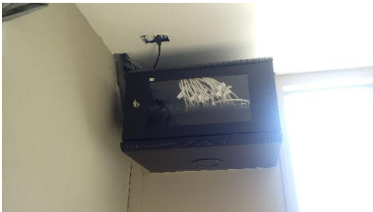
Ilustración 17. Reestructuración de la red.
