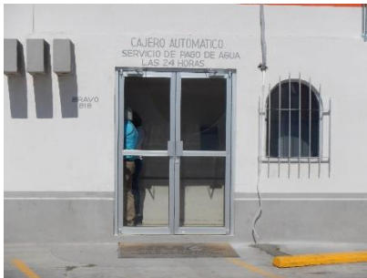
Ilustración 33. Fachada del espacio remodelado del cajero automático.
