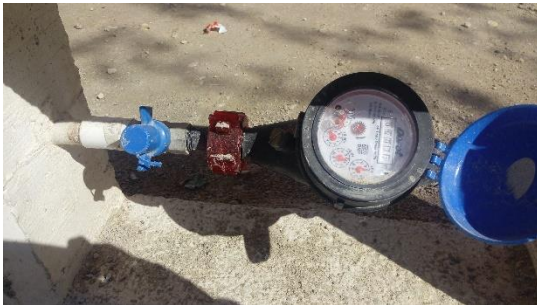
Ilustración 6. Válvula antifraude instalada en medidor nuevo de 1/2".
