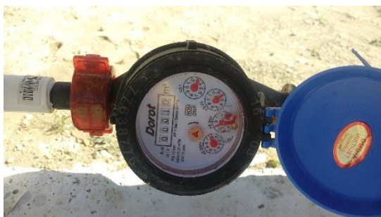
Ilustración 1. Medidor de 1/2" instalado
