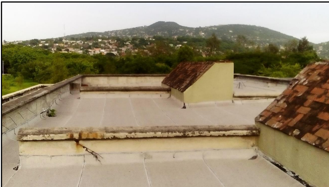
Figura 3.8 Parte del área de azotea considerada para proyecto de captación de agua de lluvia
