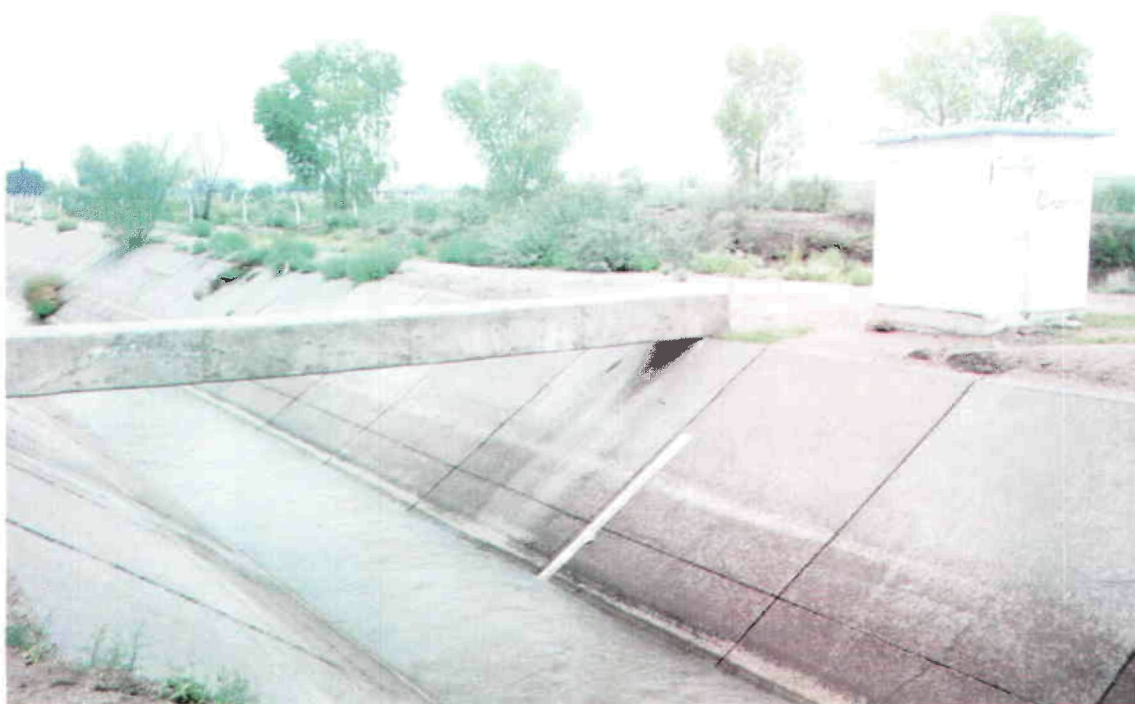
Puente de concreto para aforo con molinete.
