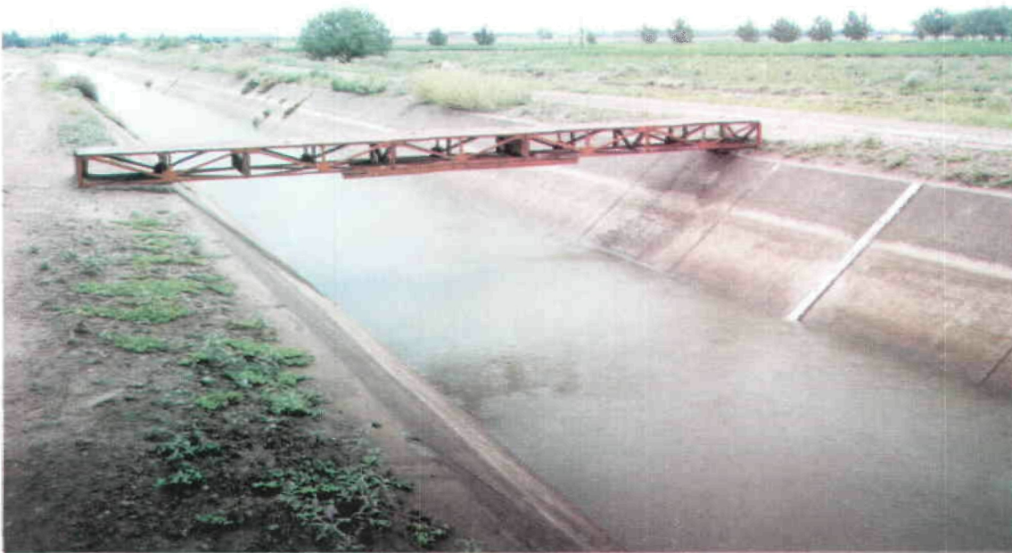
Puente de estructura metálica para aforo con molinete.
