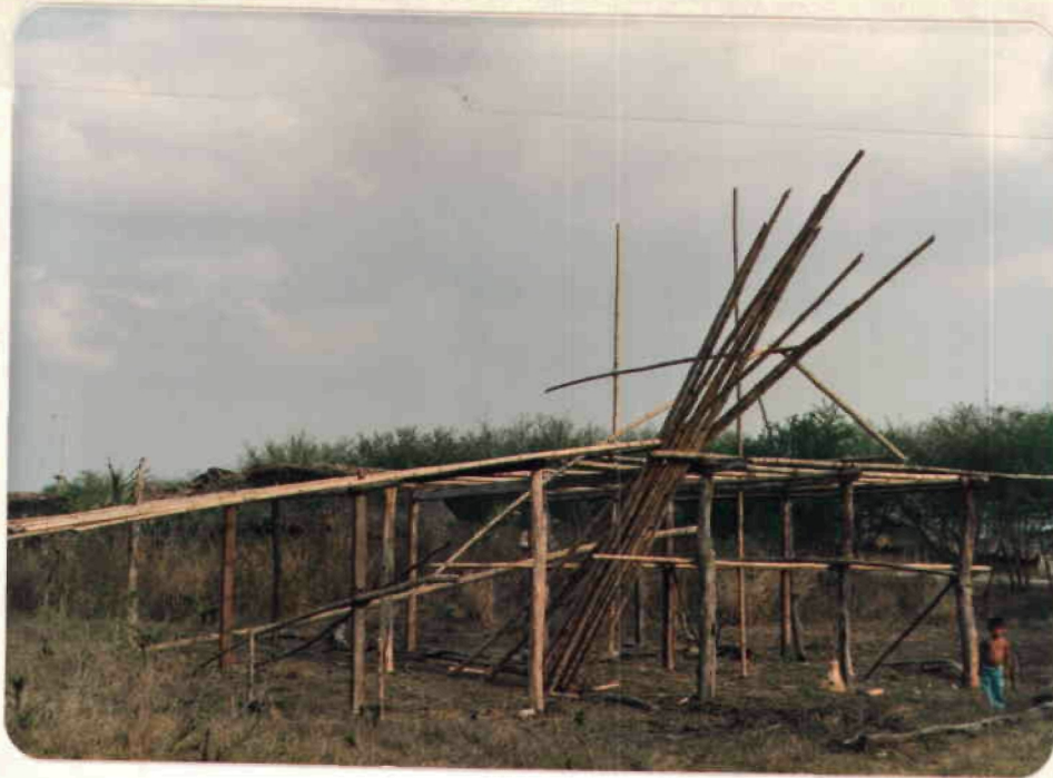
Estructura de tinglado
