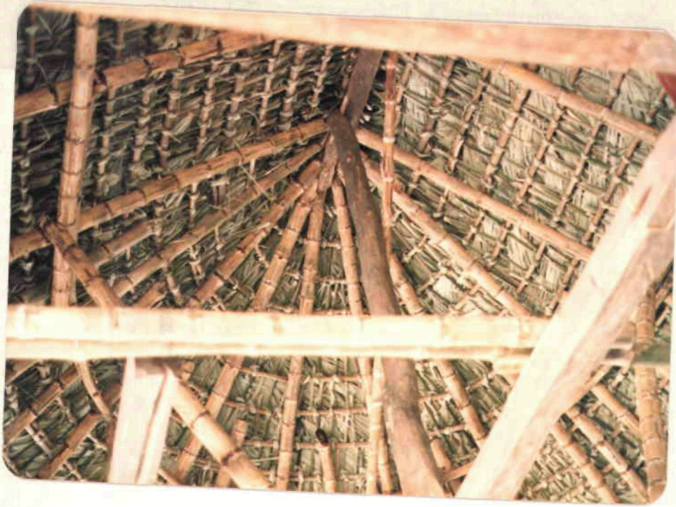
Cubierta del techo
