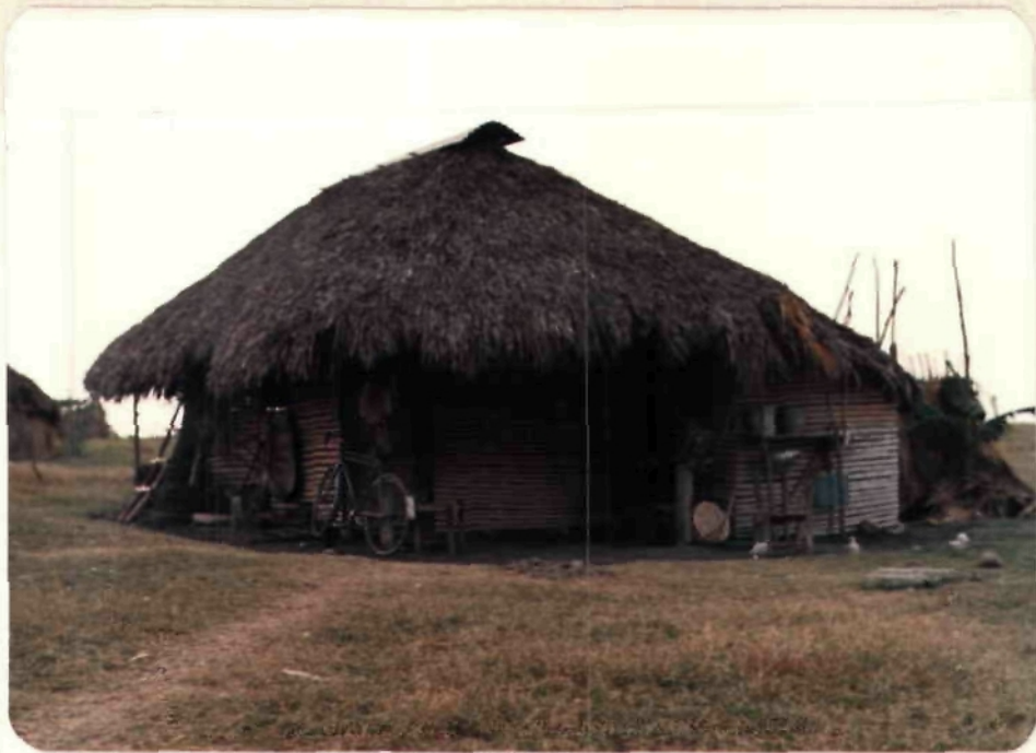
Casa de pared de vara horizontal y cubo en una de sus esquinas
