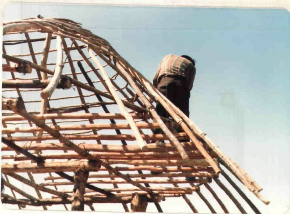
Estructura del techo
