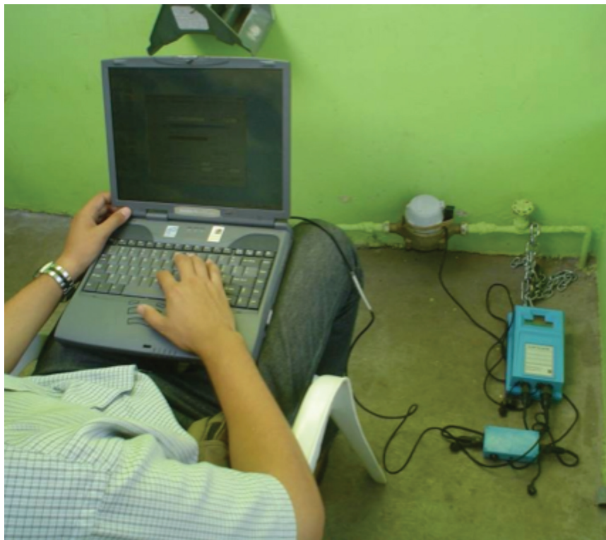
Figura 3.2.5 Instalación, programación y almacenamiento de datos en campo.
