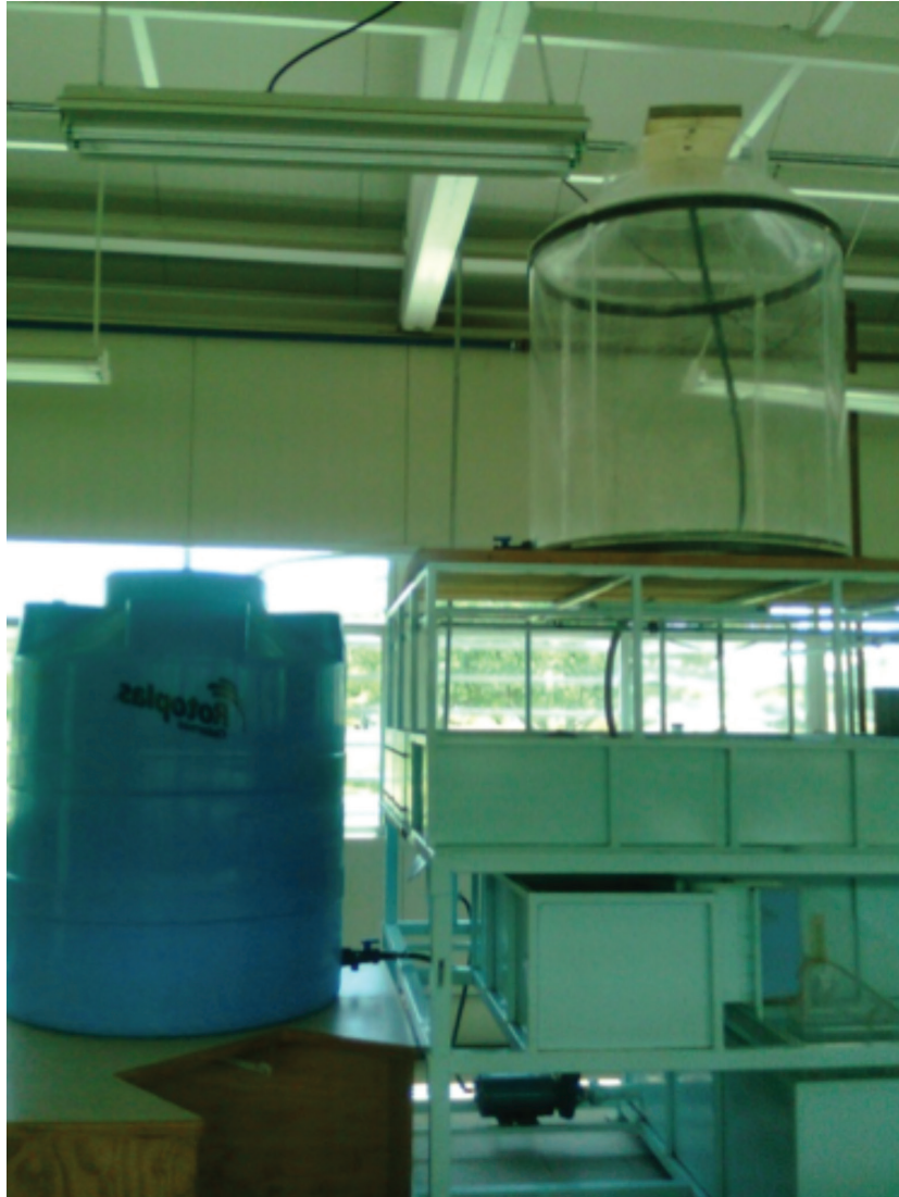
Figura 4.3.2 Instalación del sistema de depósitos
