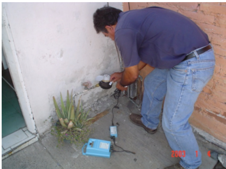
Figura 3.4.5 Instalación, programación y almacenamiento de datos en campo
