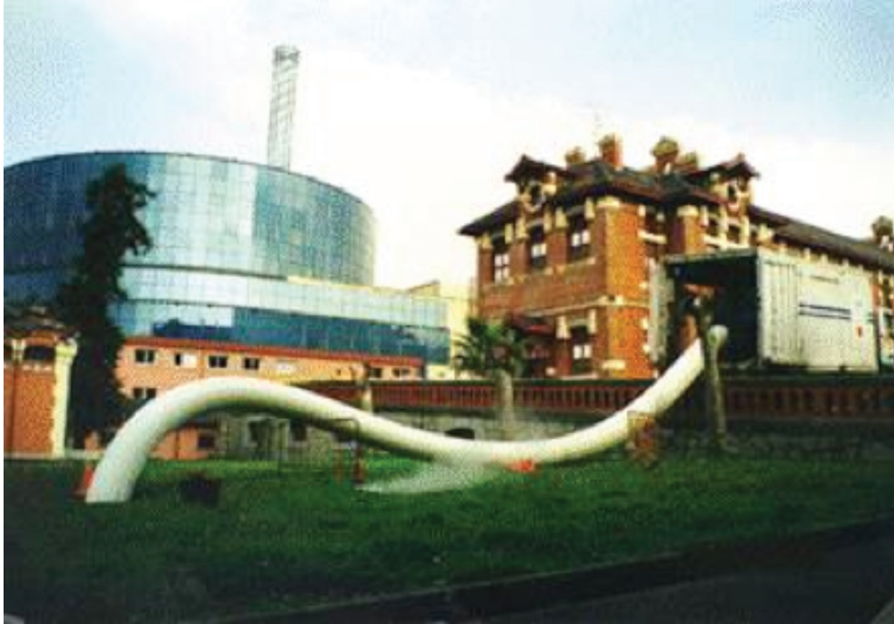
Figura 6.1.56 Sistema temporal del agua instalado
