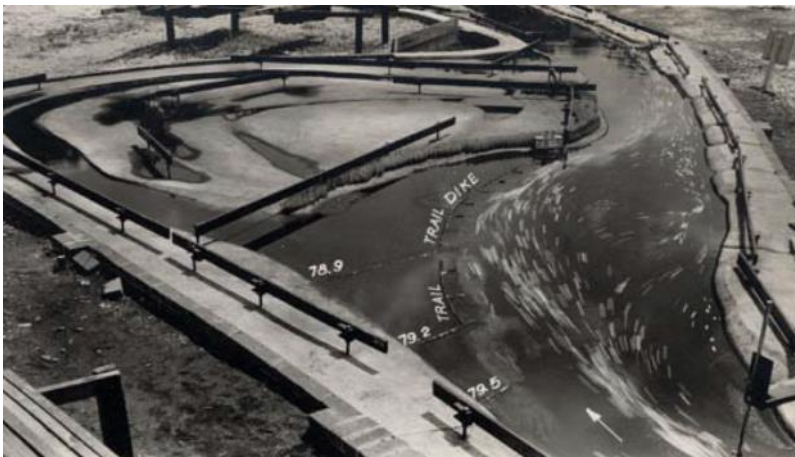
Figura 7. Sistema de rieles para un modelo de fondo móvil de escala grande (U.S. Army Engineer Waterways, Experiment 1937)
