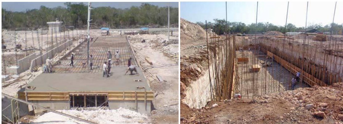
Foto 2.8.1. Construcción de la planta potabilizadora Mérida IV
