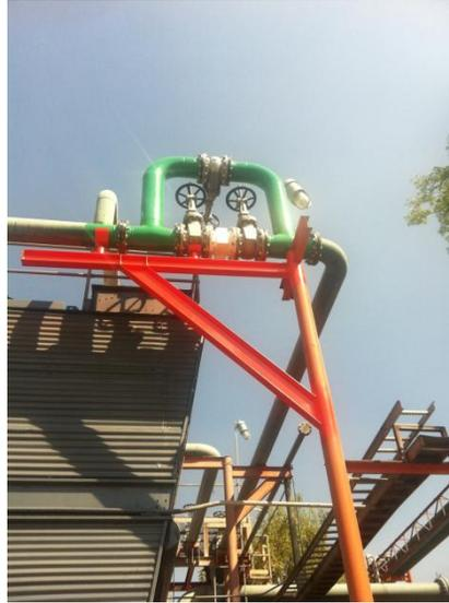
*Ilustración 4.5 Dispositivo magnético instalado en la tubería de agua de recirculación de torre de enfriamiento*
