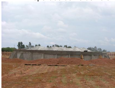
Repellado del refuerzo en la parte superior de la cisterna y colocación del vertedero excedencia
