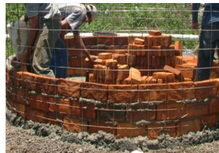
Levantamiento de muro capuchino
