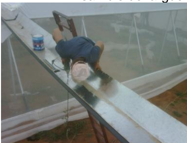
Instalación de canaleta de recolección y conducción de agua de lluvia
