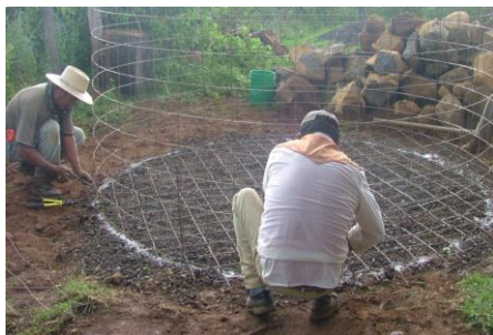
Armado del cilindro
