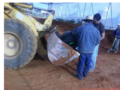
Traslado de la geomembrana para su colocación
