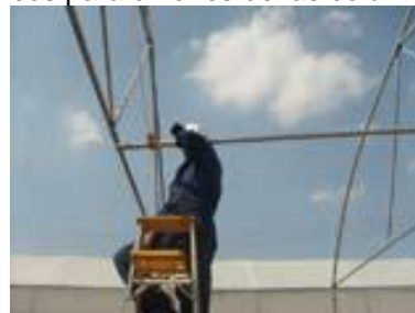
Instalación de canaleta de recolección y conducción de agua de lluvia
