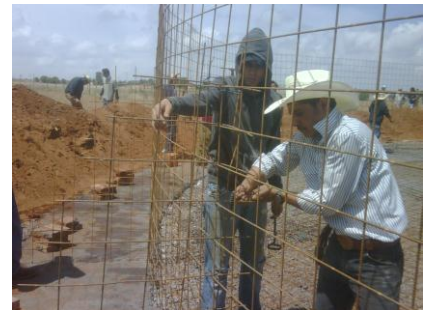
Armado y colado de contrarefueros sobre la franja perimetral
