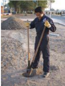
Excavación de hoyos de 45 cm de profundidad y separados a 2.5 metros
