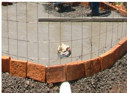
Colado de la losa del fondo
