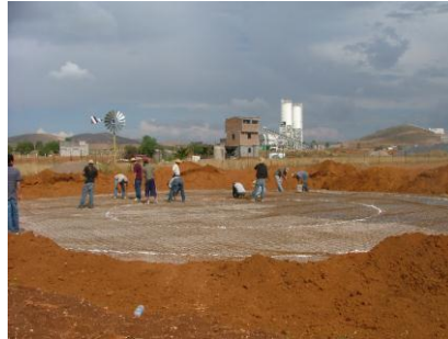
Armado y amarre para la losa de la cisterna
