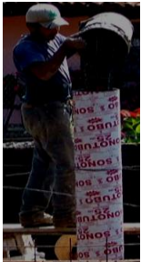
Colado de castillos y colocación y recubrimiento de refuerzos (anillos de varilla periféricos a la cisterna)
