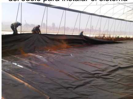
Instalación de la geomembrana sobre el piso preparado
