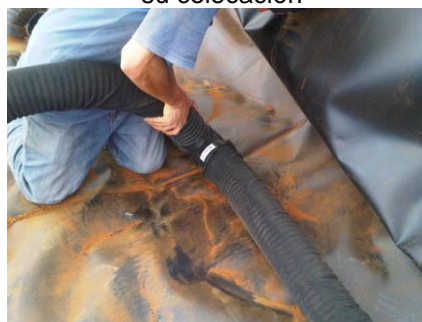
Instalación de piezas especiales de la red de Subirrigación
