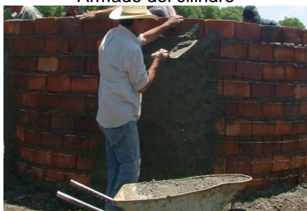
Colado parte externa del tanque
