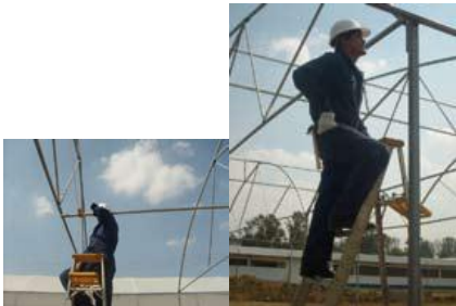
Ensamble de largueros y arcos para uniones de las columnas en ambos sentidos
