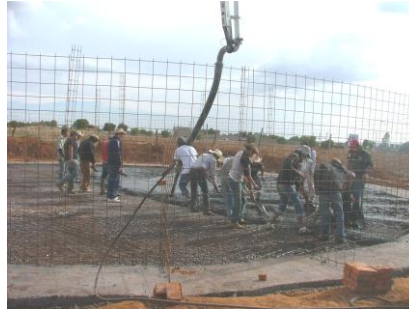
Colado de la losa del fondo de la cisterna
