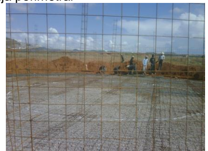
Armado y amarre de zapatas de refuerzo y columnas sobre el circunferencia auxiliar
