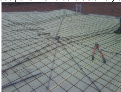
Tejido y colocación de malla con arpilla y colado de la tapa
