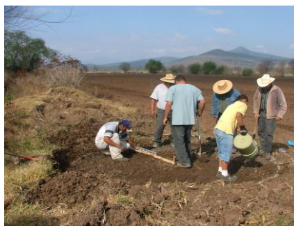
Limpieza, trazo, nivelación y compactación del terreno
