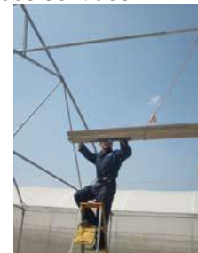
Instalación de canaleta de recolección y conducción de agua de lluvia
