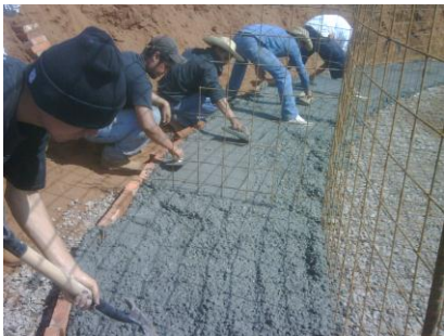
Armado y colado de contrarefueros sobre la franja perimetral
