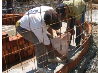
Levantamiento del muro capuchino
