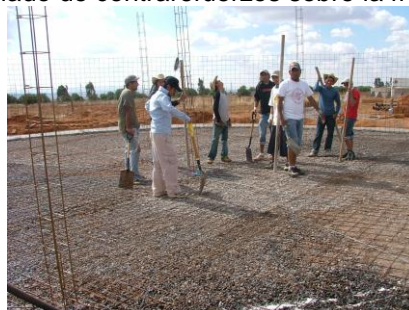
Armado y amarre de zapatas de refuerzo y columnas sobre el circunferencia auxiliar
