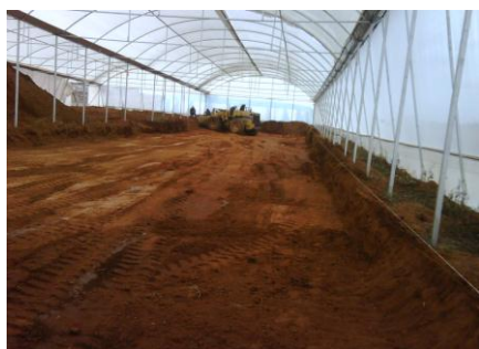
Cargador frontal realizando el corte del suelo para instalar el sistema
