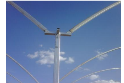
Ensamble de largueros y arcos para uniones de las columnas en ambos sentidos
