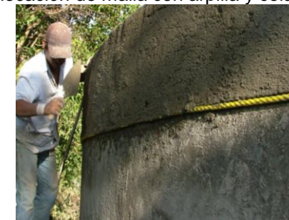
Repellado del refuerzo en la parte superior de la cisterna y colocación del vertedero excedencia
