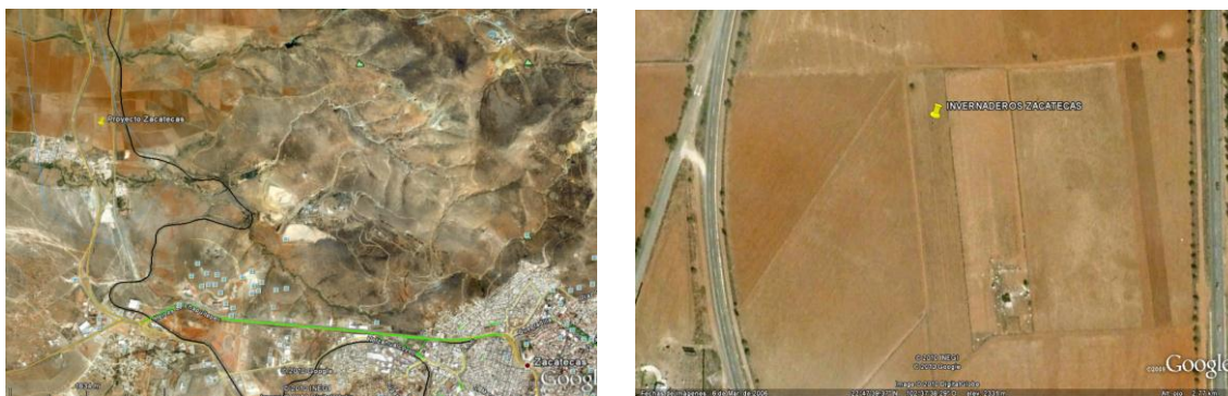
Figura 3. Vista aérea del sitio del proyecto
