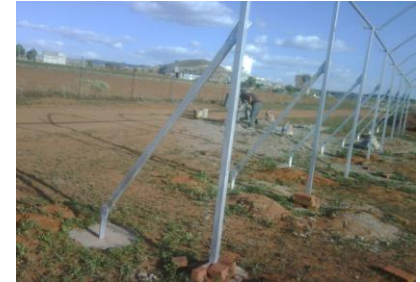
Excavación de hoyos de 45 cm de profundidad y separados a 2.5 metros
