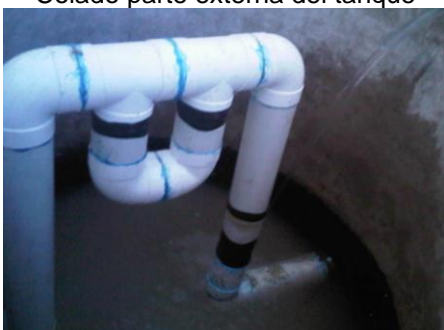
Colocación y fijación del sifón interno
