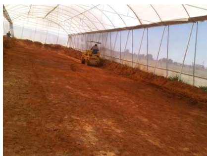
Afinando el piso para la colocación de la geomembrana
