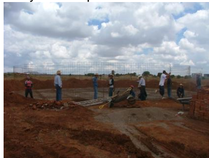
Armado y amarre para el cilindro de la cisterna
