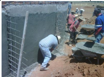
Colado parte externa de la cisterna y colado de cotrrefuerzos
