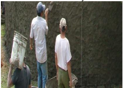
Colado parte externa de la cisterna y colado de cotrrefuerzos
