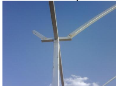
Ensamble de largueros y arcos para uniones de las columnas en ambos sentidos
