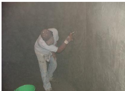
Colado parte interna de la cisterna y chaflán
