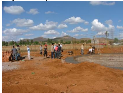
Armado y colado de contrarefueros sobre la franja perimetral
