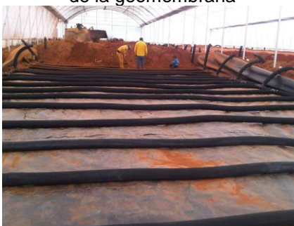
Instalación de tubos de Subirrigación (separación 1 metro)
