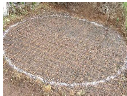
Armado de la losa o piso
