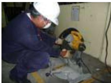
Preparación de piezas y elementos para la estructura metálica de acero
