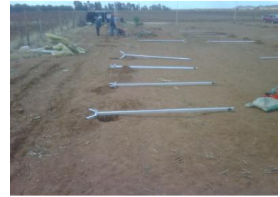
Excavación de hoyos de 45 cm de profundidad y separados a 2.5 metros
