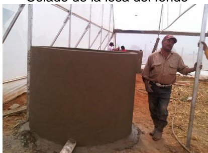
Terminado y pintado del tanque
