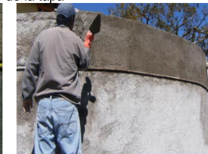
Repellado del refuerzo en la parte superior de la cisterna y colocación del vertedero excedencia
