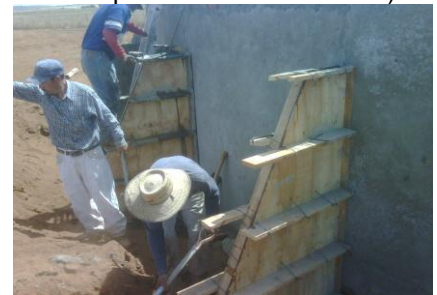
Colado parte externa de la cisterna y colado de cotrrefuerzos
