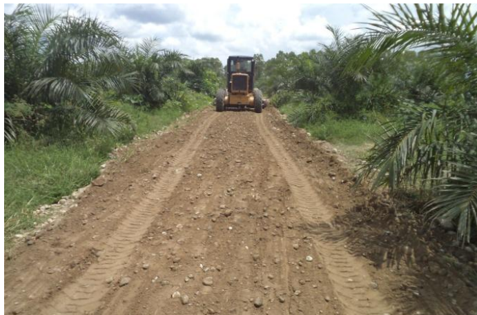
Foto 4.2 Extendido de material de revestimiento
