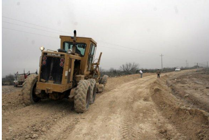
Foto. 4.1 Conformación en caminos
