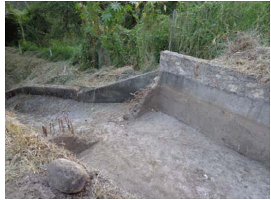
Toma 4 del río Apatlaco
