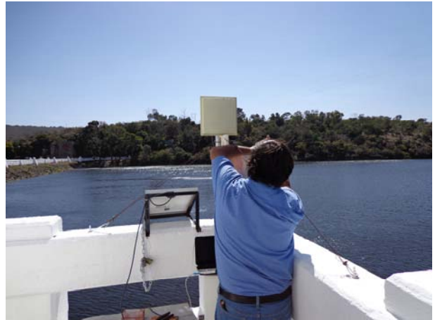
Figura 2. Re-orientación de la antena celular.
