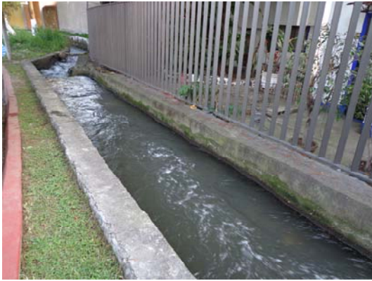
Toma 1 del río Apatlaco
