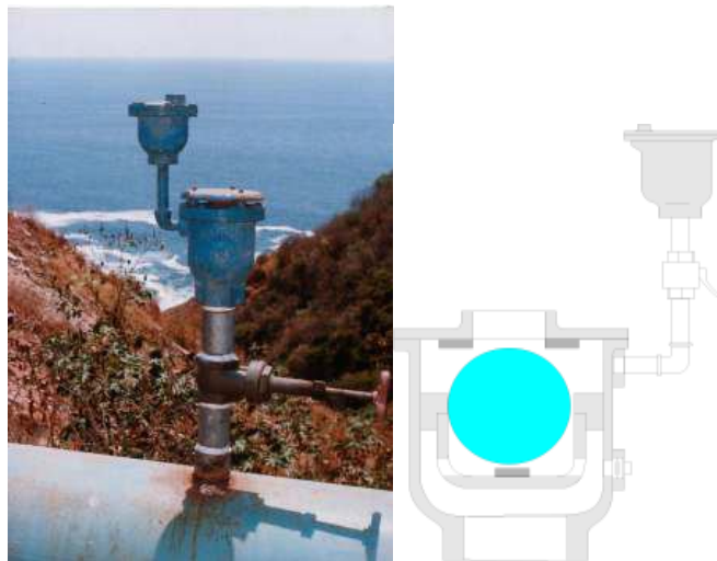
Ilustración 5.29. Válvula de admisión y expulsión de aire en conducciones presurizadas.
