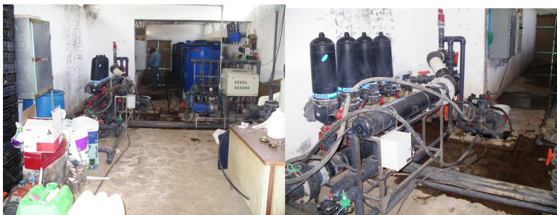
Ilustración 1.2. y 1.3. Cabezal de bombeo. Equipo motor bomba y filtrado e inyección de fertilizantes.
