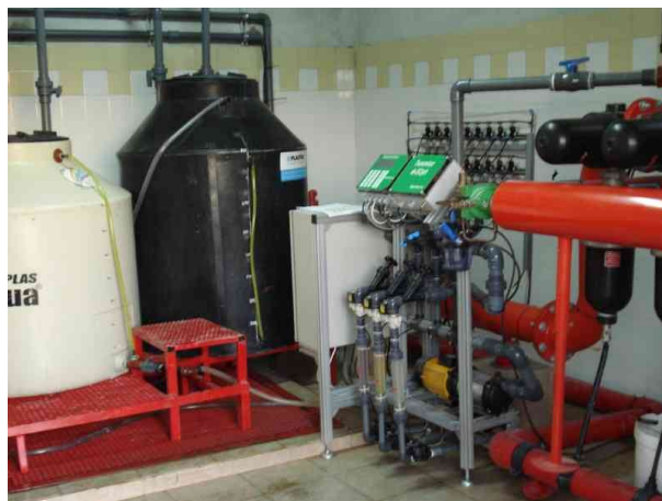
Ilustración 6.6. Inyectores de la solución nutritiva.
