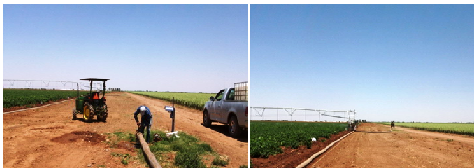
Ilustración 5.52. Hidrante para el riego de una tubería regante de avance frontal.
