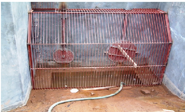
Ilustración 5.36. Obra de toma con rejilla y trampa de azolves.
