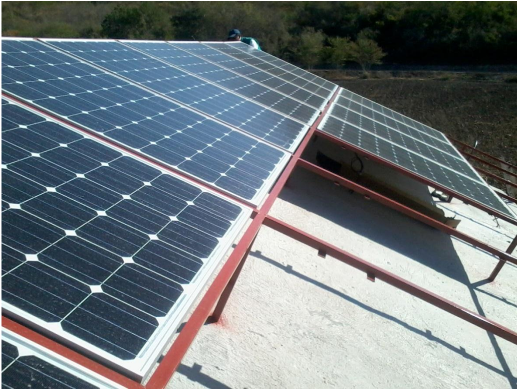
Figura III.54 Instalación de los paneles solares que generarán la energía para impulsar las bombas.
