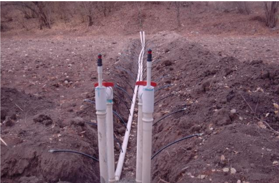
Figura III. 55 Instalación del sistema de riego
