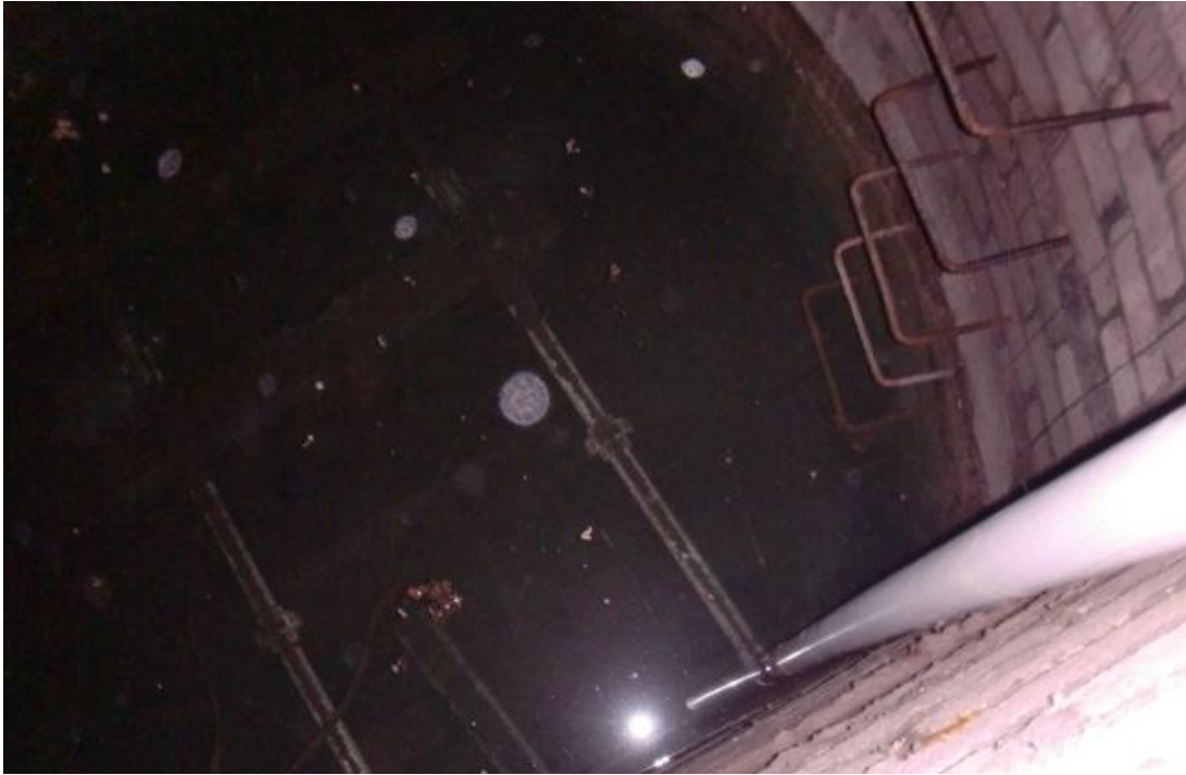
Figura III. 53 Bombas sumergibles para bombeo del riego
