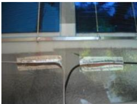
Figura III.19 Proceso de soldado entre polos
