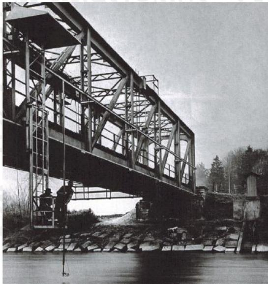
Figura 1.67 Instalación permanente en el puente de un río para medir la velocidad del caudal
