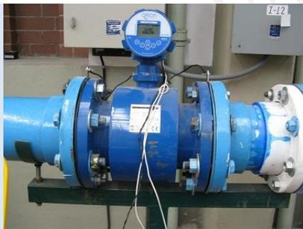
Imagen 2.2 Medidores de gasto electromagnético revisados.
