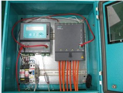
Ilustración 5.2 Equipos de medición de gasto Rittmeyer
