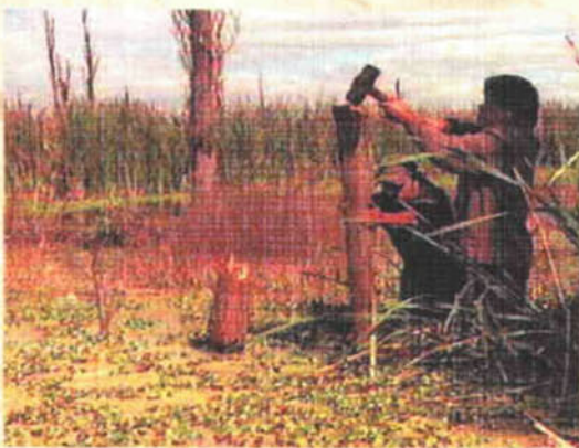
Foto 19. Las estacas deben quedar lo más vertical posible y tener del orden de un metro de altura.
