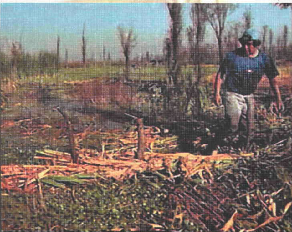
Foto 30. Formación del bordo con carrizo tejido en torno al perímetro delimitado por las estacas.
